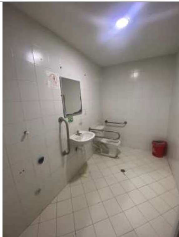
IMAGEN DE REFERENCIA BAÑOS EXISTENTES
