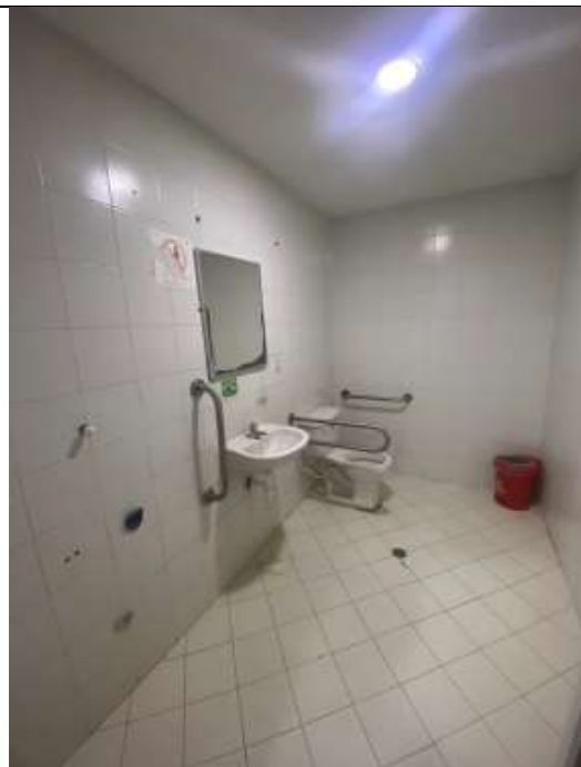
IMAGEN DE REFERENCIA BAÑOS EXISTENTES
