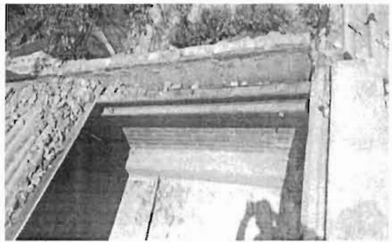
Demolición de muro
