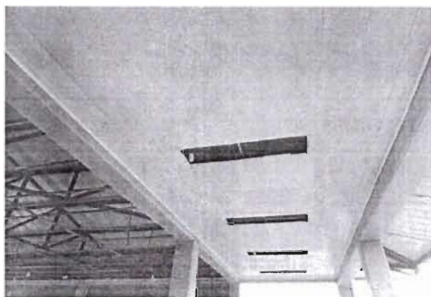
Instalación de laminas de PVC
