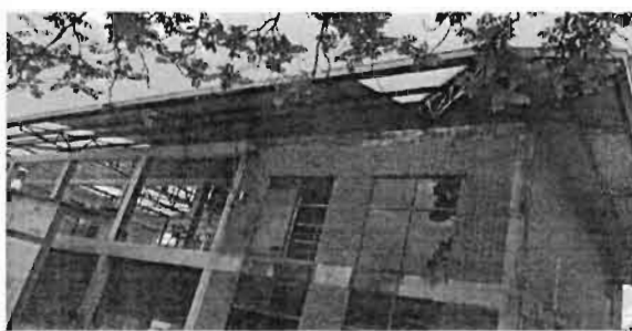
Instalación de cubierta
