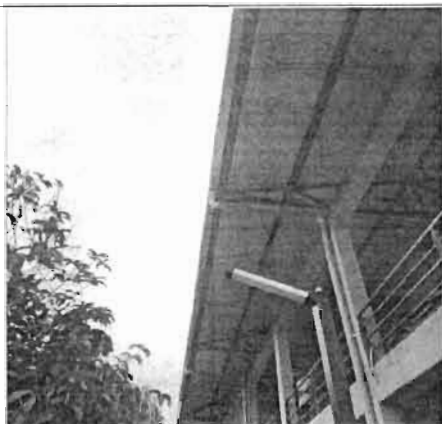
Bajantes, codo y canales instalados
