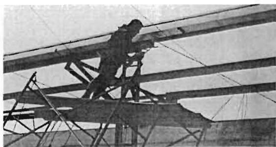
Instalación de canales
