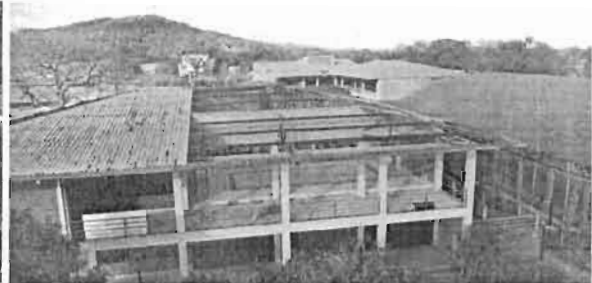
Desmanto de cubierta
