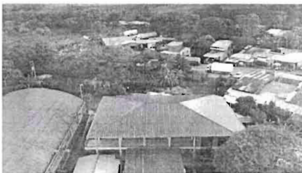
Estado final de la cubierta
