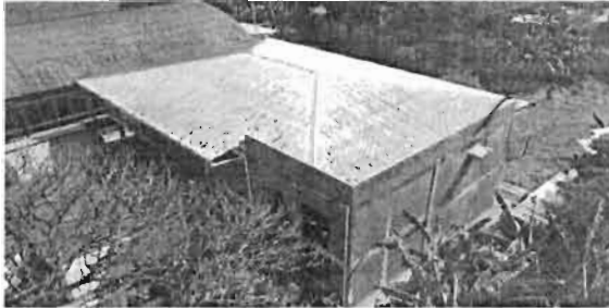
Estado inicial de la cubierta
