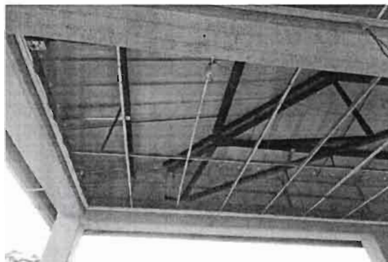
Refuerzo estructura cielo raso
