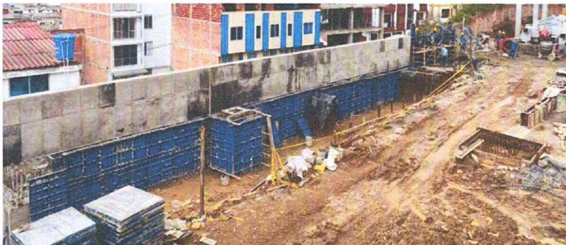
Ilustración 9 Muro de contención 4.40 mts de altura modulo A
