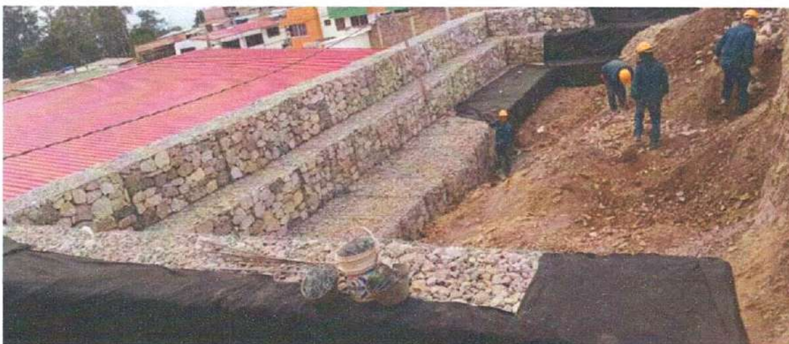
Ilustración 6 Construcción de muro en gavión módulo D
