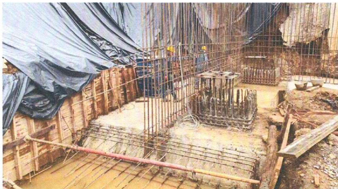
Ilustración 17 Concreto de zarpa muro de contención 4000 Psi
