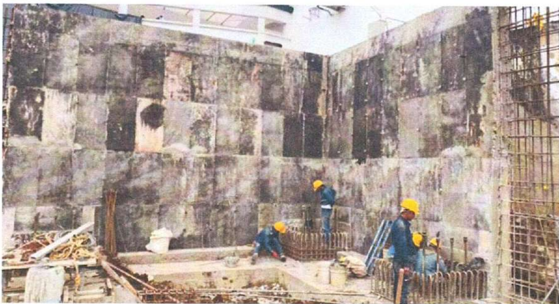
Ilustración 12 Muro de contención modulo A, altura 6.00 mts
