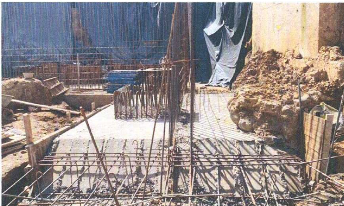
Ilustración 18 Concreto de zarpa para muro de contención modulo A eje 1
