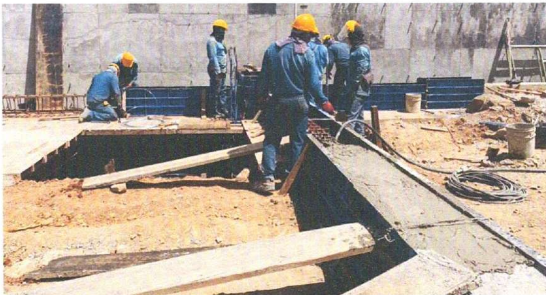
Ilustración 23 Viga en concreto de 4000 Psi modulo A
