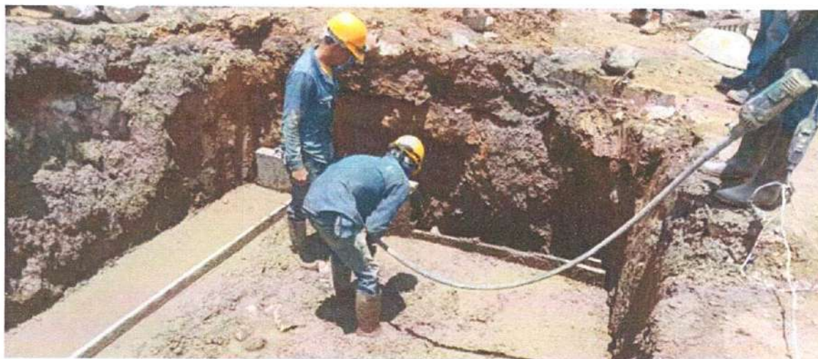
Ilustración 16 Vibrado de concreto de 3000 psi con piedra ciclópeo
