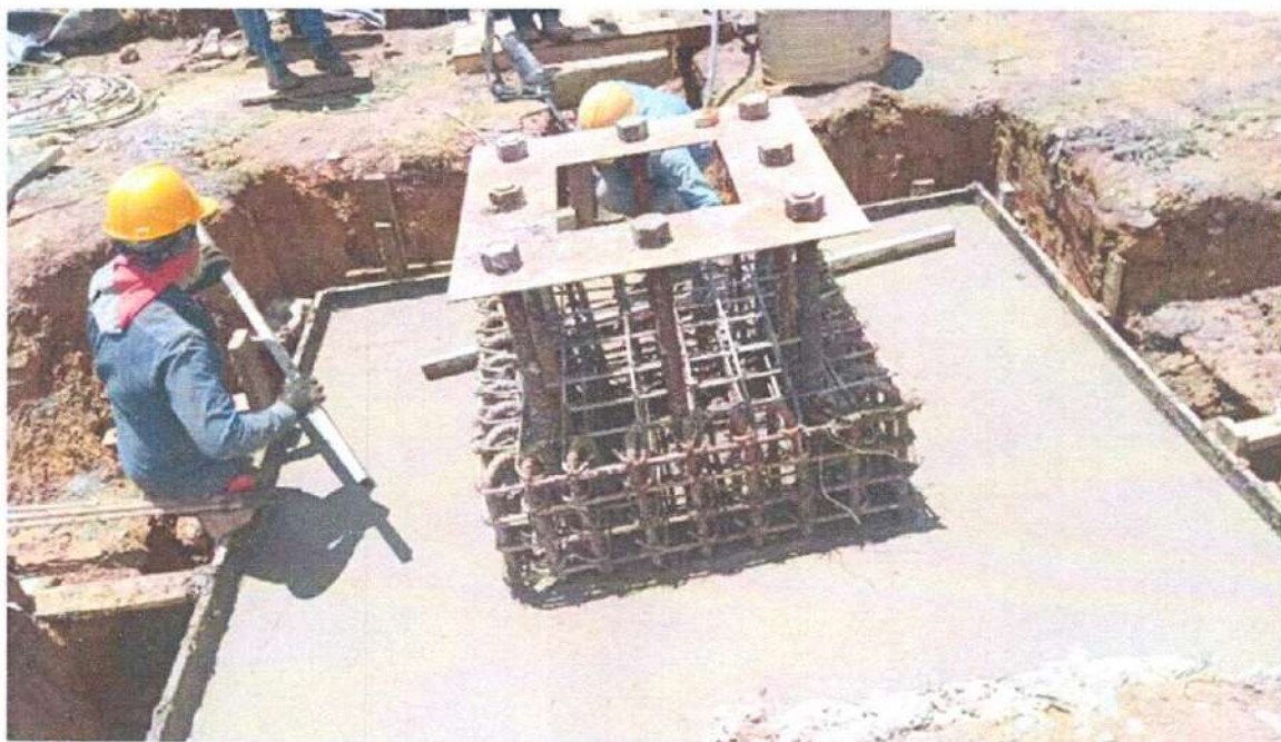
Ilustración 19 Concreto de 4000 psi eje G-3
