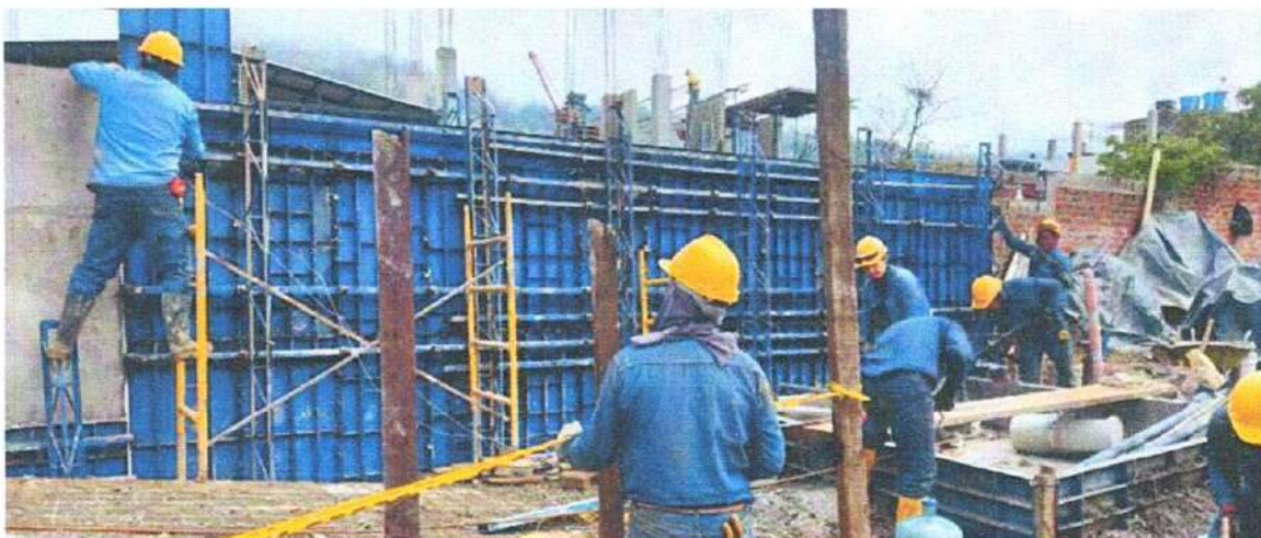
Ilustración 8 Muro de contención de altura 2.40 mts
