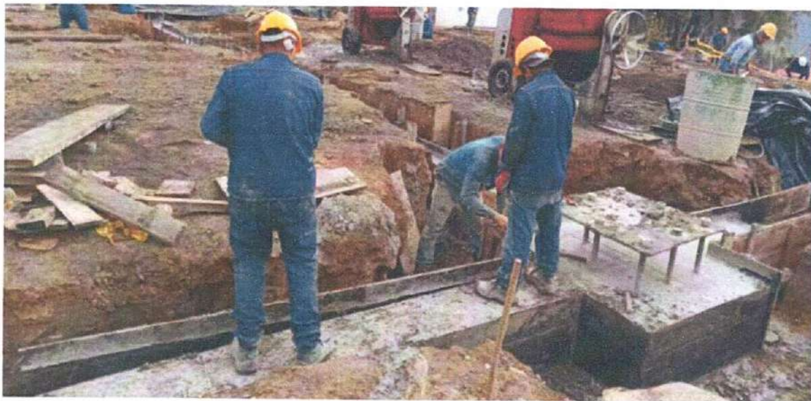
Ilustración 16 Vigas en concreto de 4000 Psi módulo D
