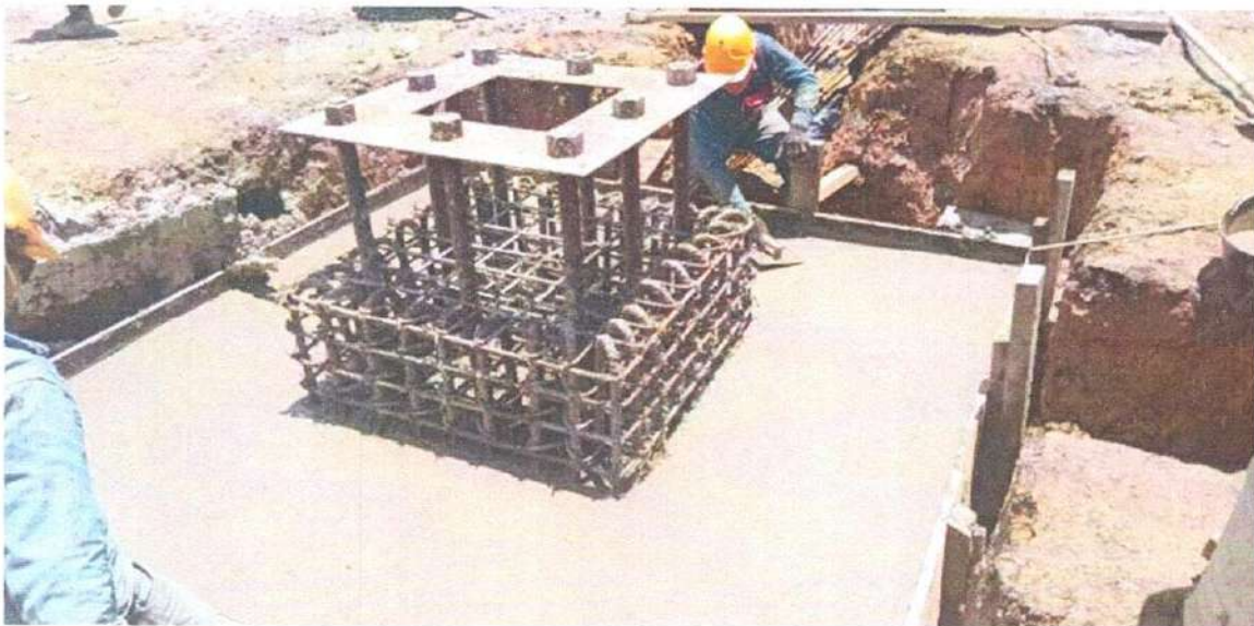
Ilustración 18 Fundida concreto de 4000 psi zapatas modulo A
