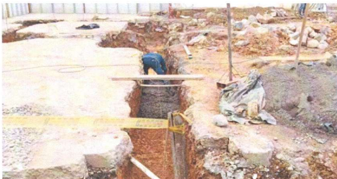
Ilustración 13 Base en concreto pobre de 5 cm
