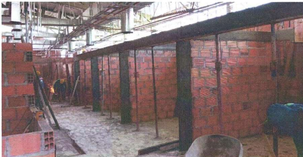
Ilustración 13 Columnas de confinamiento en el área UCI
