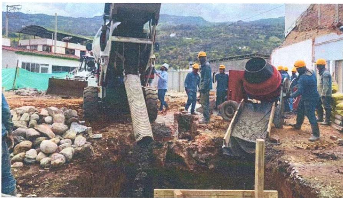
Ilustración 15 Concreto ciclópeo módulo D
