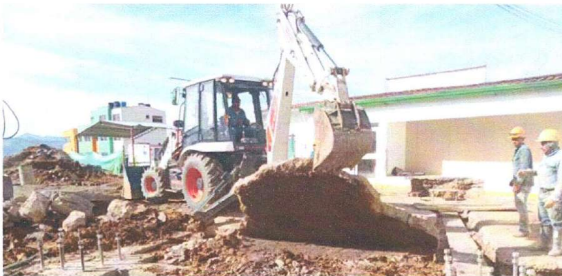
Ilustración 7 Demolición de placa de plazoleta módulo D
