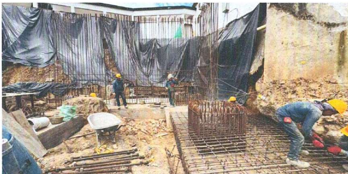
Ilustración 16 Acero de refuerzo muro de contención de h=6.00 mts
