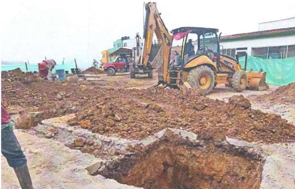
Ilustración 5 Excavación zapatas módulo D
