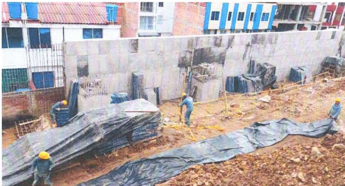
Ilustración 10 Muro de contención modulo A
