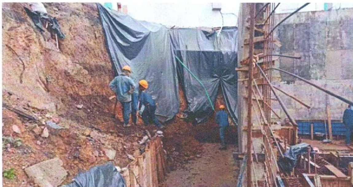
Ilustración 8 Relleno de excavación
