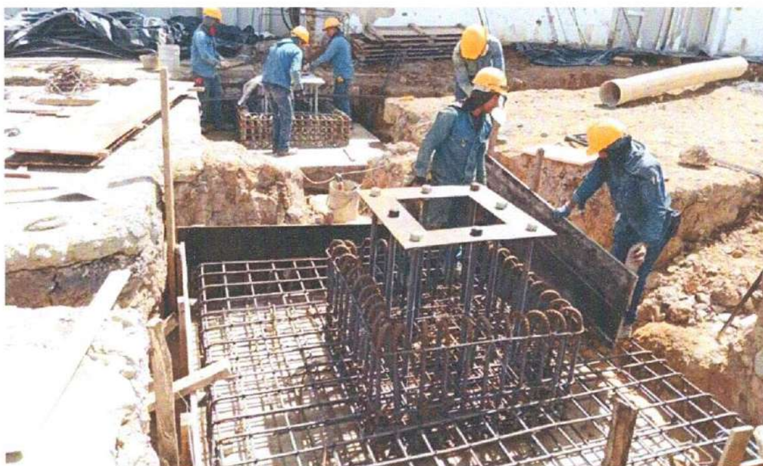
Ilustración 15 Zapatas y pedestales módulo D
