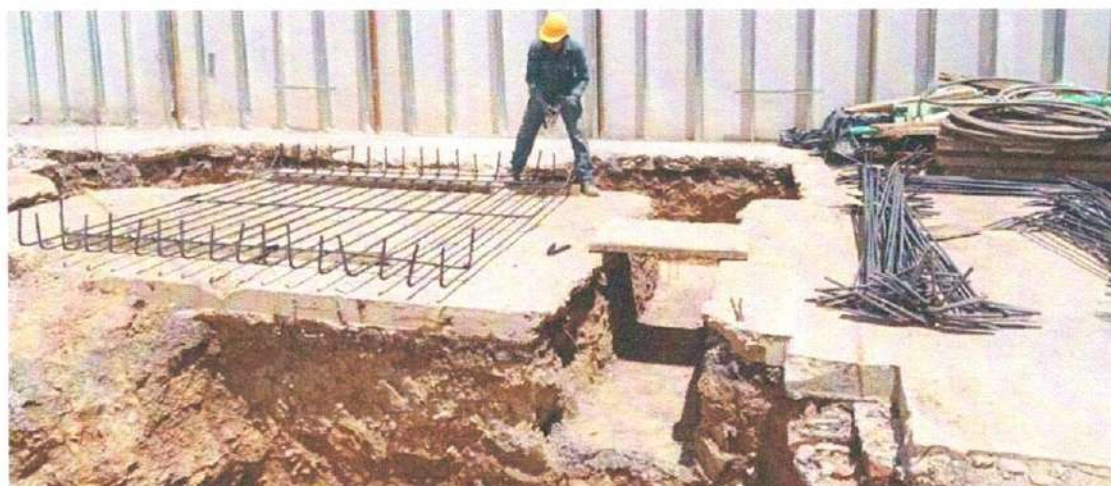
Ilustración 11 Excavación cimentación módulo D
