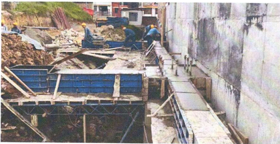
Ilustración 15 Viga en concreto de 4000 Psi modulo A
