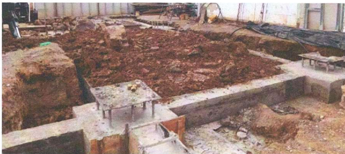
Ilustración 13 Concreto de zapatas de 4000 Psi
