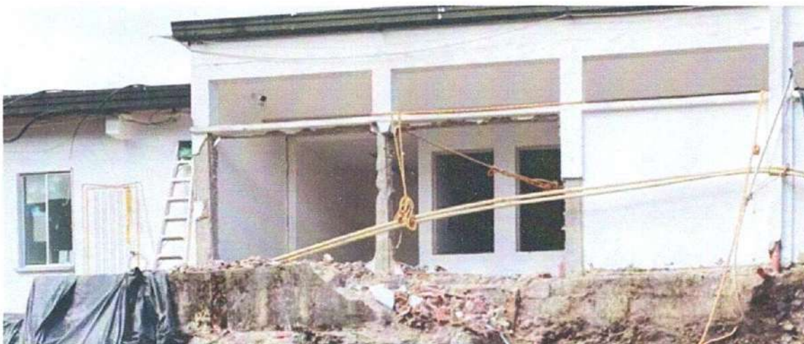
Ilustración 5 Demolición de muros modulo E
