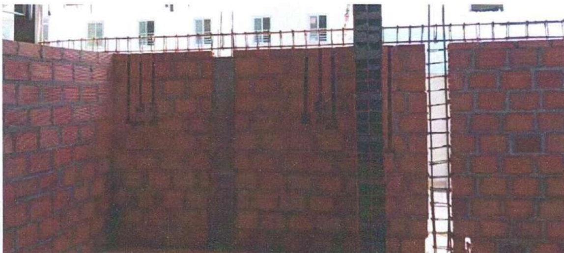
Ilustración 11 Acero de refuerzo de columnetas - vigas de confinamiento
