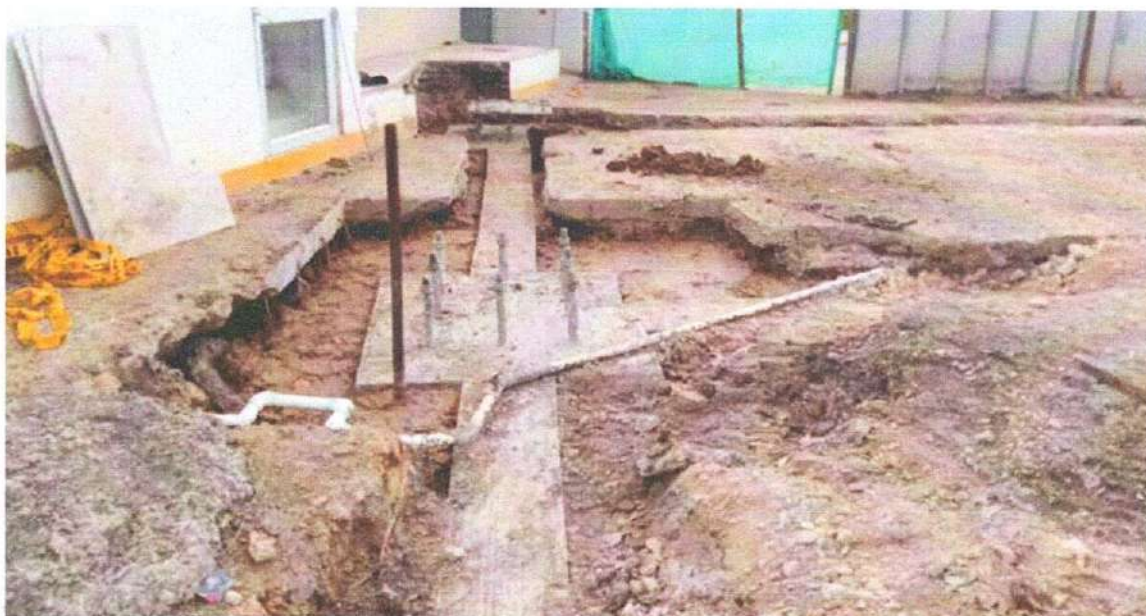
Ilustración 14 Concreto de 4000 Psi para zapatas módulo D
