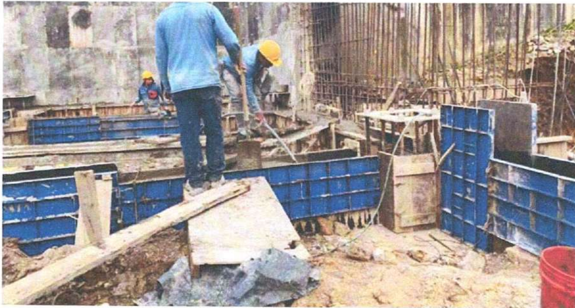
Ilustración 17 Concreto de 4000 psi para vigas de cimentación, modulo A
