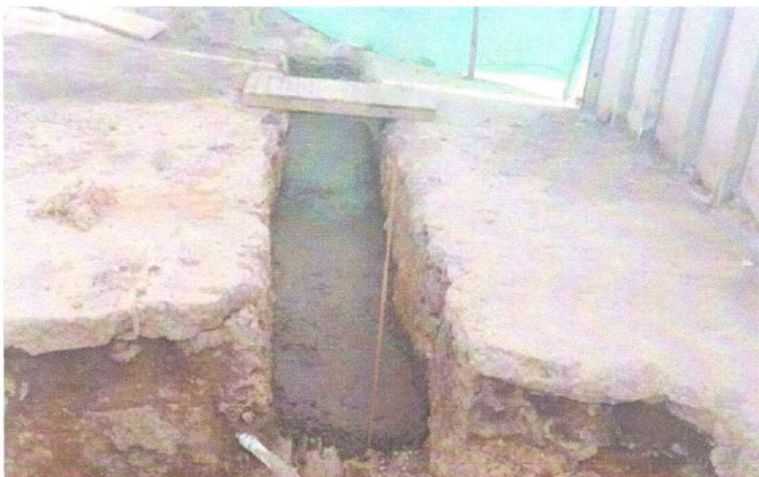
Ilustración 12 Base en concreto pobre módulo D
