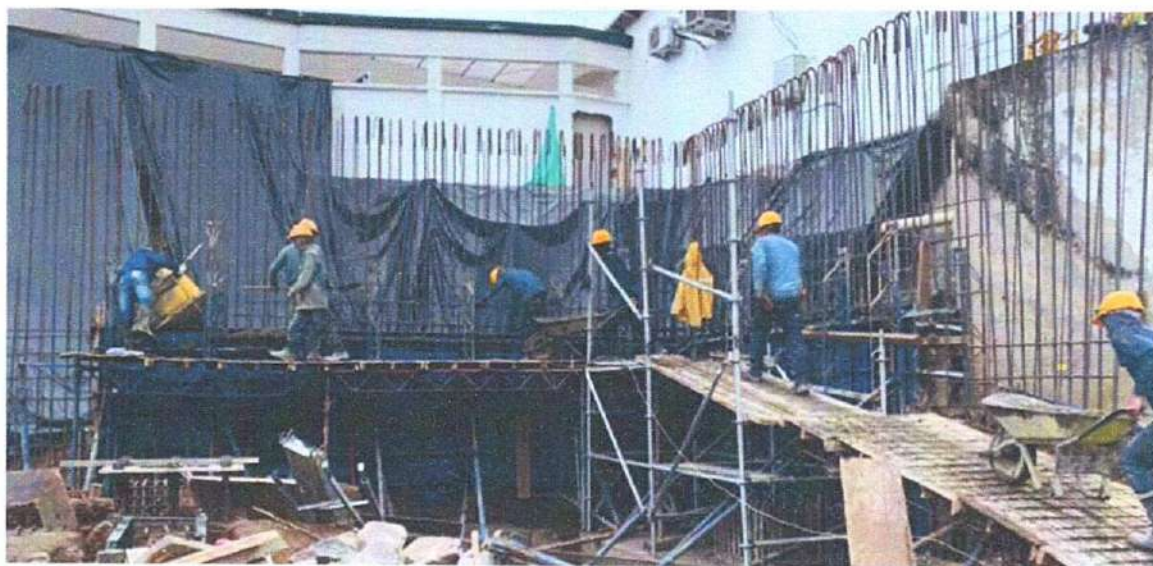
Ilustración 11 Fundida concreto de 4000 psi en muro de contención, modulo A
