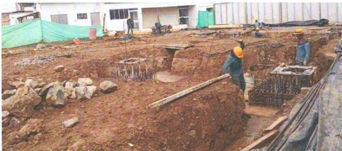
Ilustración 10 Excavación cimentación módulo D
