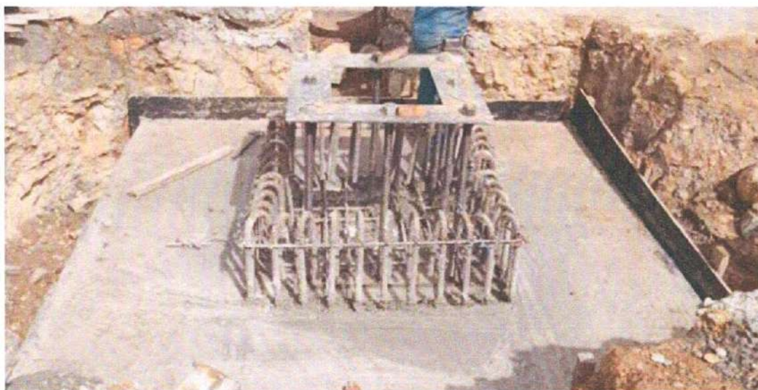
Ilustración 21 Concreto de zapatas de 4000 Psi
