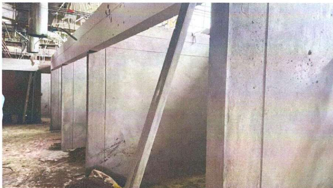
Ilustración 14 Columnas de confinamiento en el área UCI
