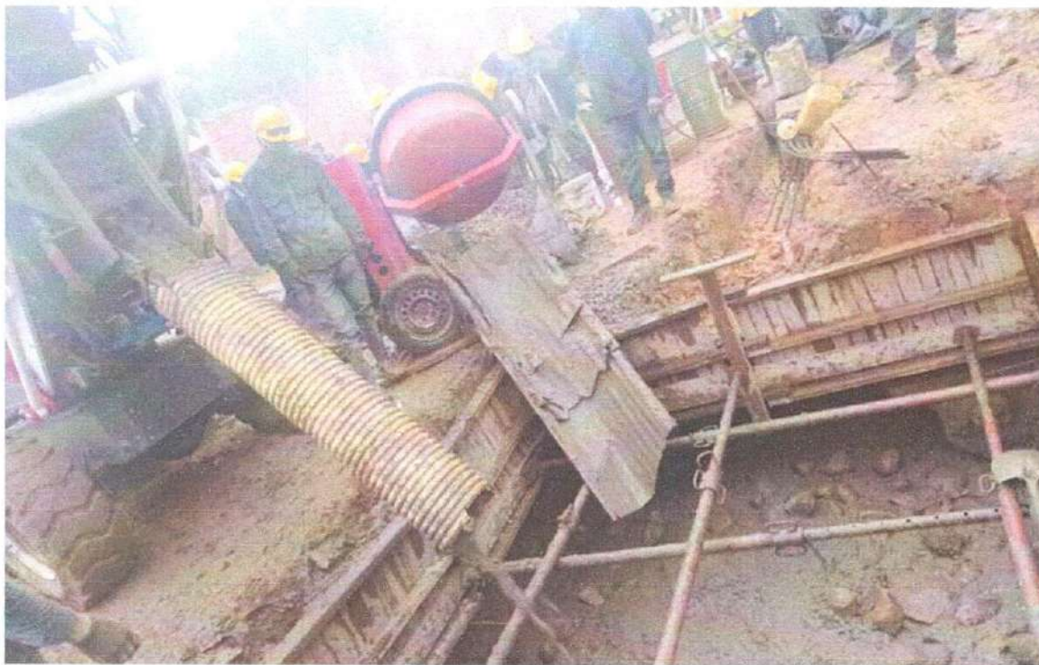
Ilustración 17 Concreto ciclópeo modulo A eje G-3
