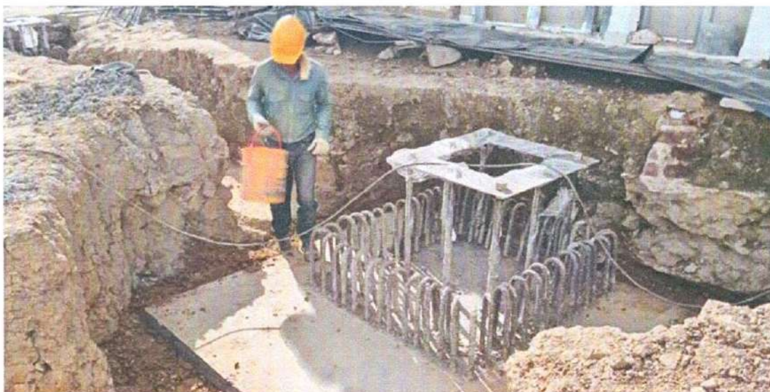
Ilustración 14 Amarre de acero en zapatas
