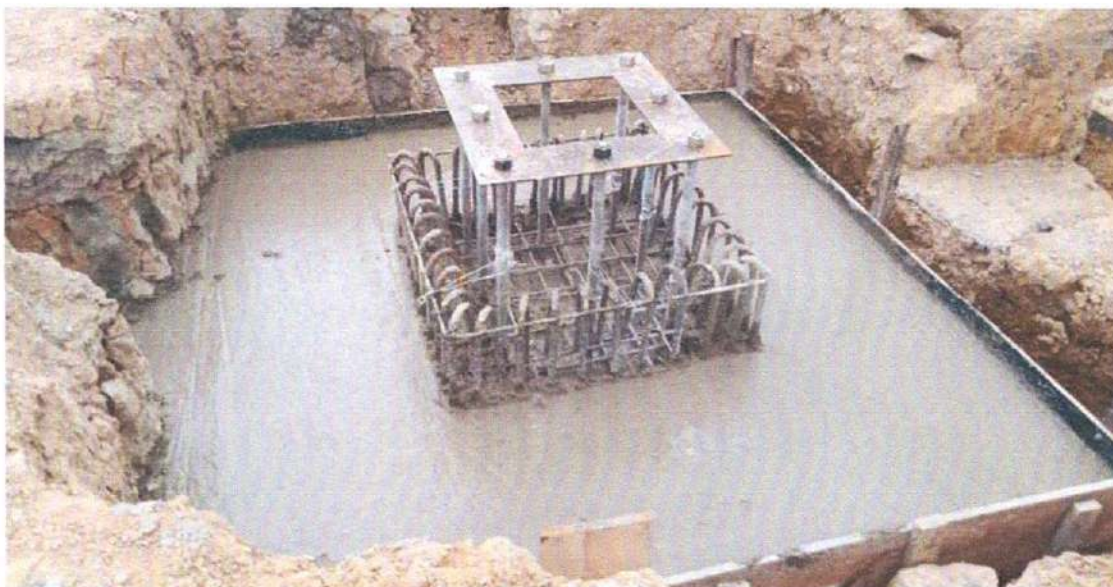
Ilustración 22 Concreto de 4000 Psi para zapatas módulo D
