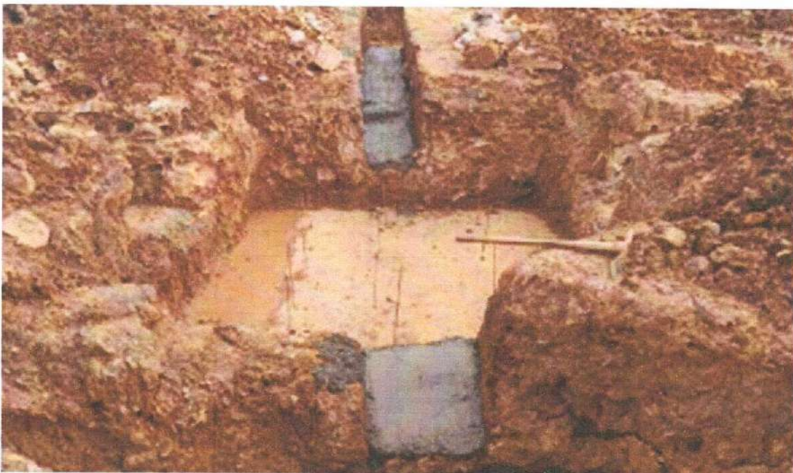
Ilustración 10 Base concreto pobre de 5 cm para limpieza
