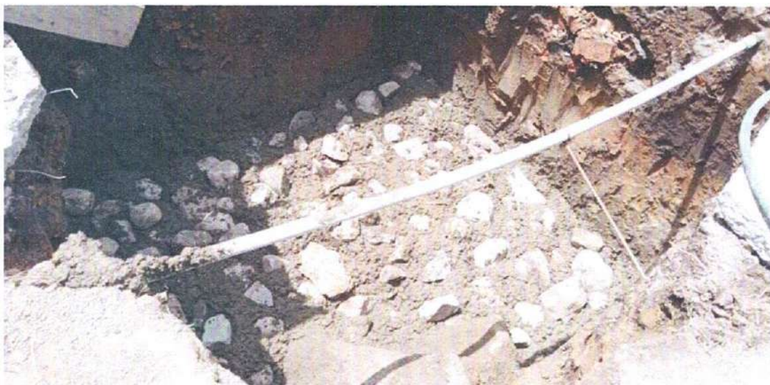
Ilustración 20 Concreto ciclópeo módulo D
