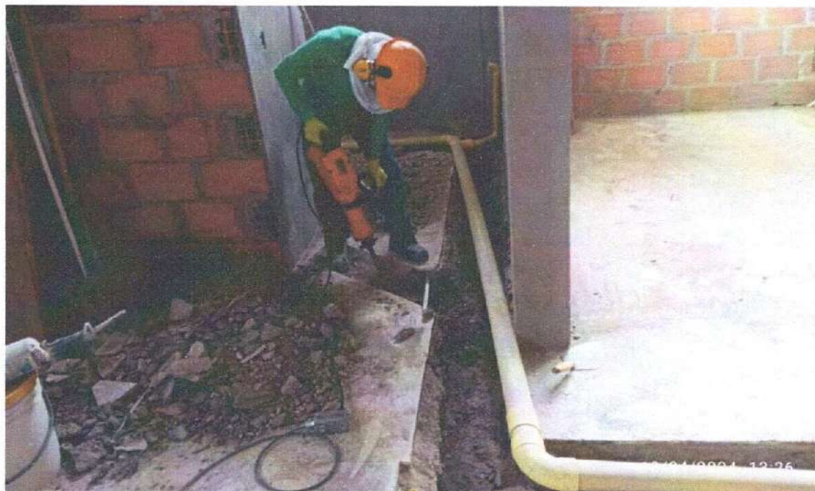
Ilustración 21 Demolición, excavación y postura de red sanitaria
