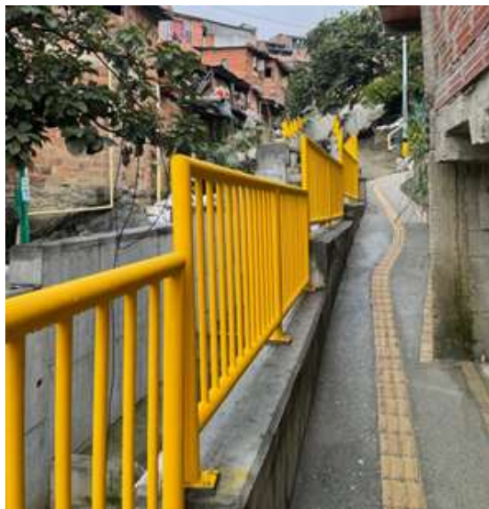
Foto 3 VISTA DEL ANDEN DEL CANAL ABIERTO SECTOR DERECHO AGUAS ABAJO.
