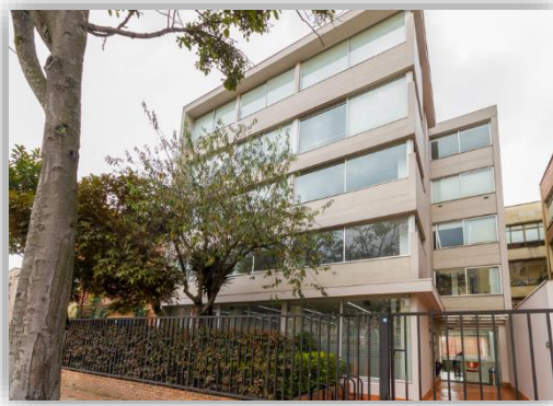
Edificio de Innovación y Emprendimiento Cra 5 No. 34-07
