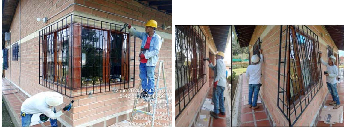
Ítem 9. Hidrofugado para muros exteriores
