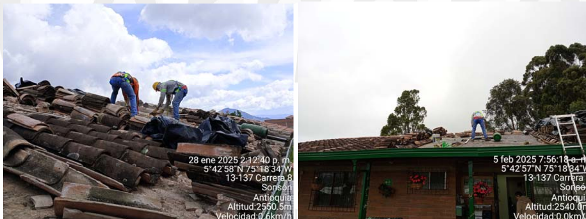
Ítem 11. Reparación cubierta en teja de barro, incluye instalación de Manto impermeabilizante ATV 30 3 mm en toda su superficie, sellada de huecos con mortero, reparación de la tablilla defectuosa e instalación de las tejas.
