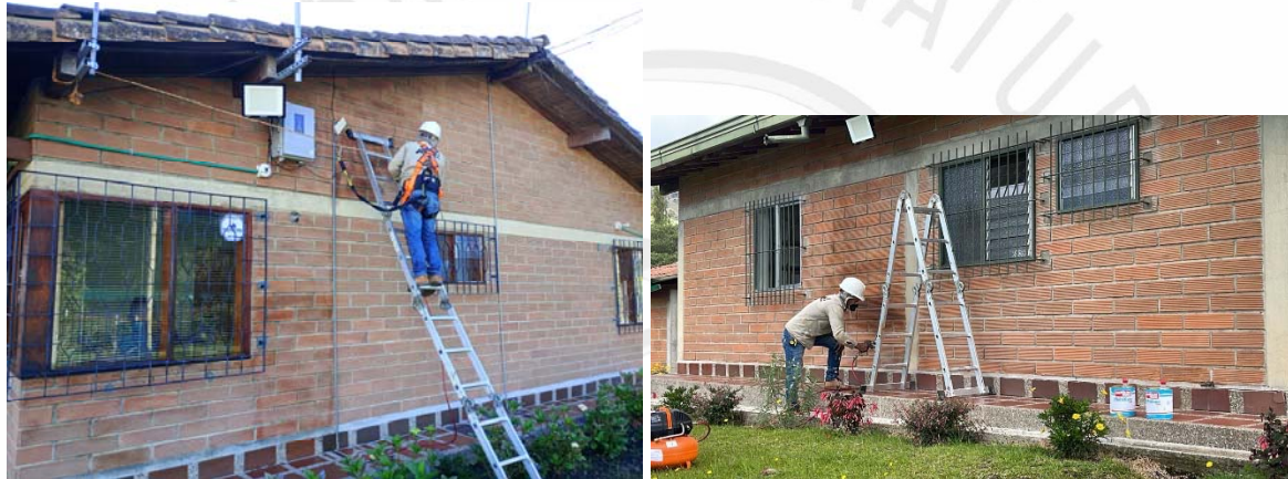
Ítem 10. Desmante de teja de barro, incluyo retiro de tela asfáltica y limpieza de la superficie.
