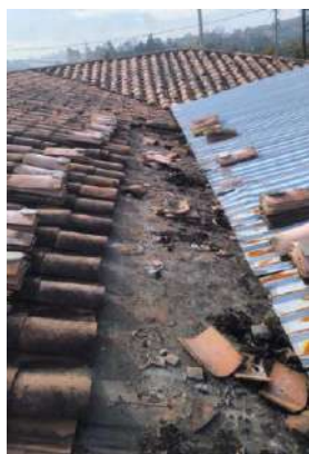
Mantenimiento Cubierta. 5. SANTA BARBARA - SEDE SAN LUIS
