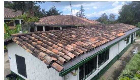
Mantenimiento Cubierta. 6. SANTA BARBARA - SEDE PRINCIPAL
