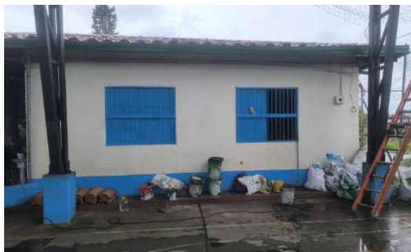
Instalación Canoa Nueva. 5. SANTA BARBARA - SEDE SAN LUIS
