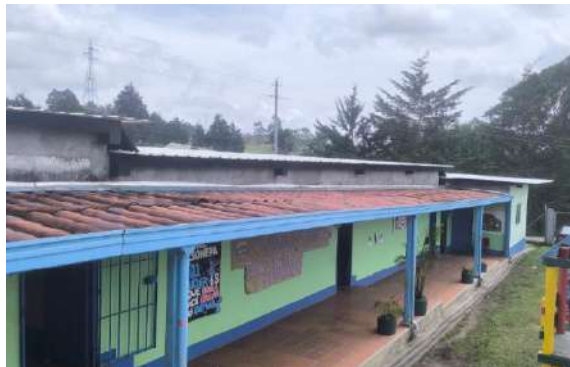
Mantenimiento Cubierta. 4. SANTA BARBARA - SEDE LOS PINOS
