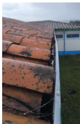
Mantenimiento Cubierta. 5. SANTA BARBARA - SEDE SAN LUIS
