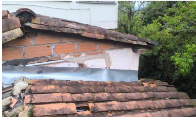
Mantenimiento Cubierta. 15. BARRO BLANCO - SEDE LA INMACULADA
