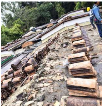
Mantenimiento Cubierta. 12. JOSÉ MARÍA CORDOBA - SEDE PRINCIPAL
