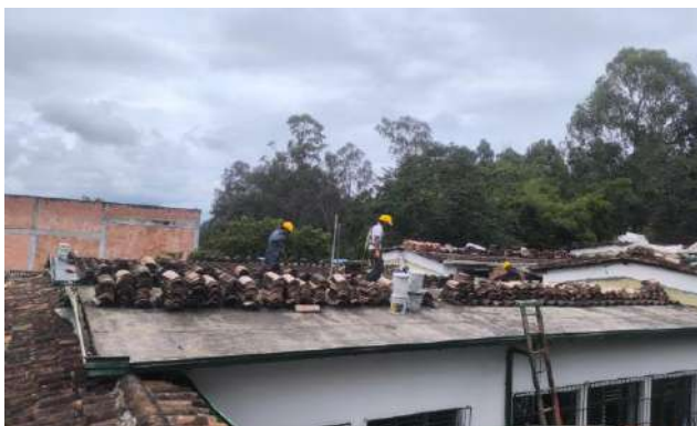
Mantenimiento Cubierta. 12. JOSÉ MARÍA CORDOBA - SEDE PRINCIPAL
