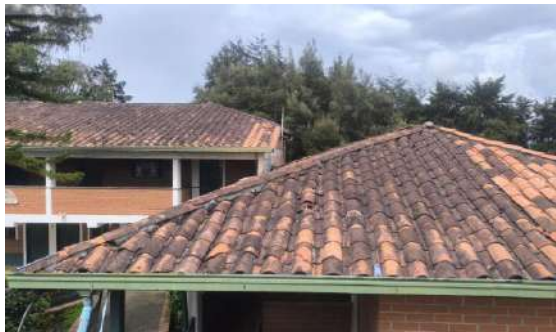
Mantenimiento Cubierta. 6. SANTA BARBARA - SEDE PRINCIPAL
