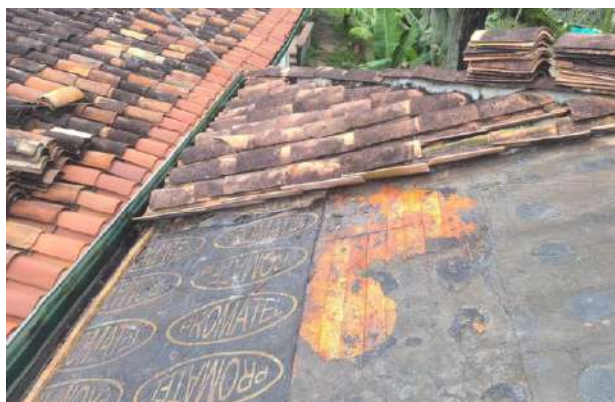
Mantenimiento Cubierta. 6. SANTA BARBARA - SEDE PRINCIPAL
