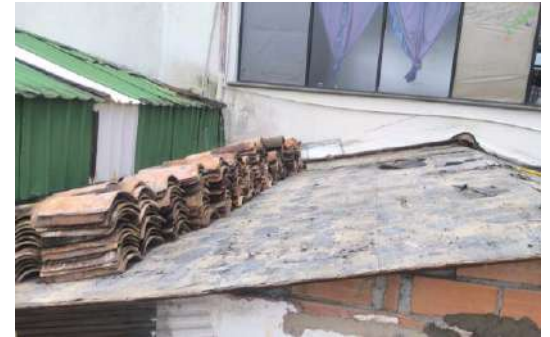
Mantenimiento Cubierta. 15. BARRO BLANCO - SEDE LA INMACULADA
