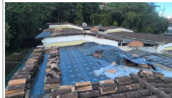
Mantenimiento Cubierta. 12. JOSÉ MARÍA CORDOBA - SEDE PRINCIPAL
