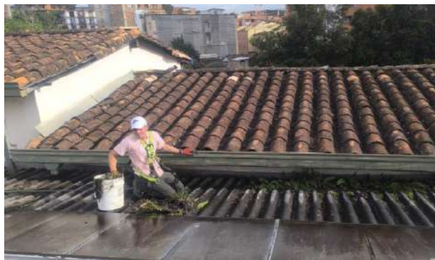
Mantenimiento canoas. 14. NORMAL SUPERIOR
