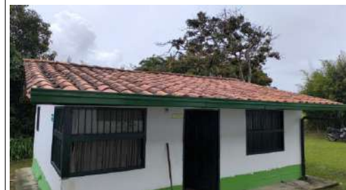
Mantenimiento Canoas. SAN ANTONIO DE PEREIRA - SEDE VILACHUAGA
