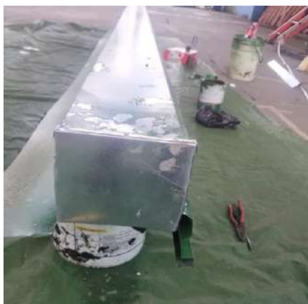
Instalación Canoa Nueva. 5. SANTA BARBARA - SEDE SAN LUIS
