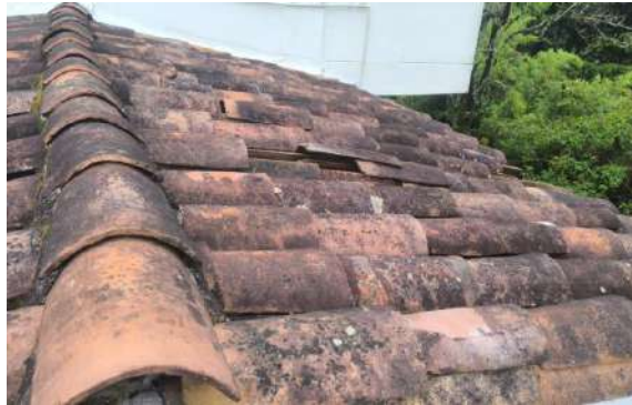
Mantenimiento Cubierta. 15. BARRO BLANCO - SEDE LA INMACULADA
