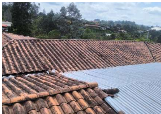
Mantenimiento Cubierta. 5. SANTA BARBARA - SEDE SAN LUIS
