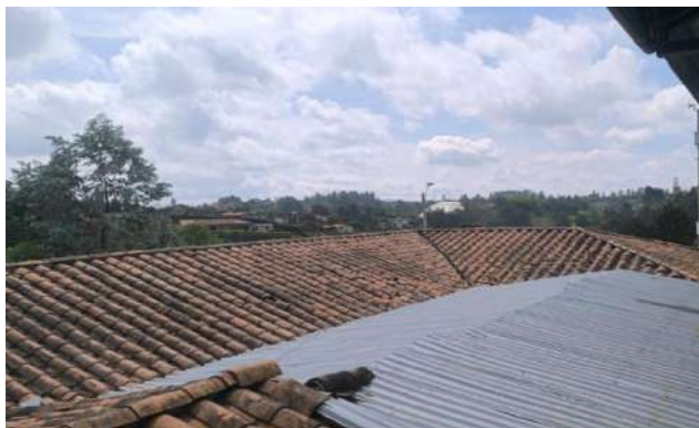
Mantenimiento Cubierta. 5. SANTA BARBARA - SEDE SAN LUIS
