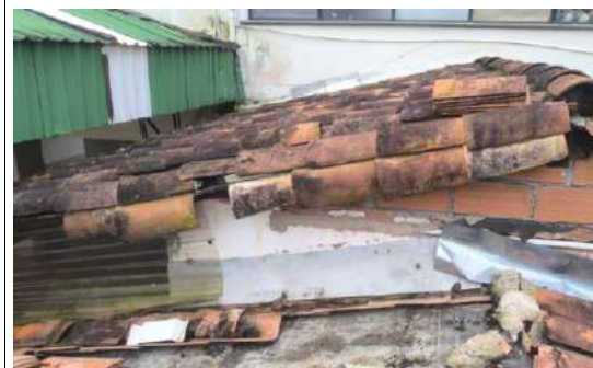
Mantenimiento Cubierta. 15. BARRO BLANCO - SEDE LA INMACULADA
