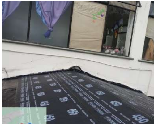
Mantenimiento Cubierta. 15. BARRO BLANCO - SEDE LA INMACULADA
