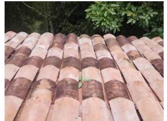
Mantenimiento Cubierta. 15. BARRO BLANCO - SEDE LA INMACULADA
