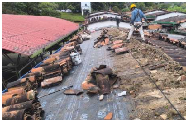
Mantenimiento Cubierta. 14. NORMAL SUPERIOR
