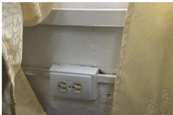
Retiro y suministro aparatos eléctricos 4. SANTA BARBARA - SEDE LOS PINOS
