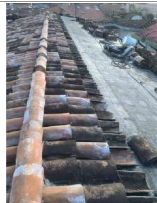
Mantenimiento Cubierta. 14. NORMAL SUPERIOR
