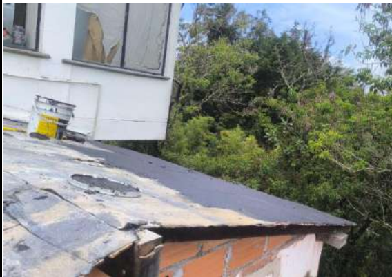
Mantenimiento Cubierta. 15. BARRO BLANCO - SEDE LA INMACULADA
