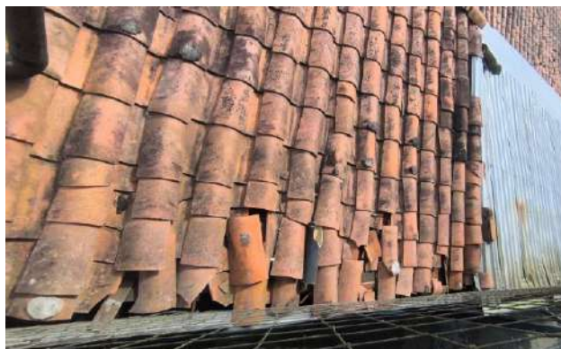
Mantenimiento Cubierta. 5. SANTA BARBARA - SEDE SAN LUIS
