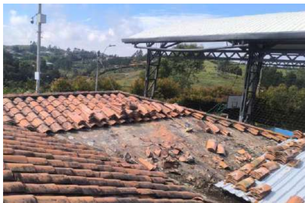
Mantenimiento Cubierta. 5. SANTA BARBARA - SEDE SAN LUIS
