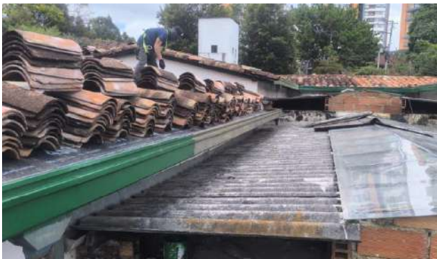
Mantenimiento canoas. 14. NORMAL SUPERIOR
