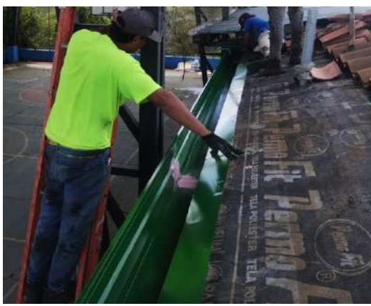
Instalación Canoa Nueva. 5. SANTA BARBARA - SEDE SAN LUIS
