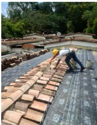
Mantenimiento Cubierta. 12. JOSÉ MARÍA CORDOBA - SEDE PRINCIPAL
