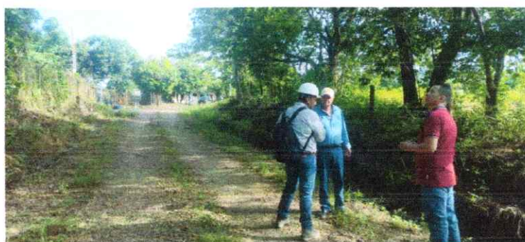
Visita de obra vía a pavimentar y chequeo de eje preliminar
