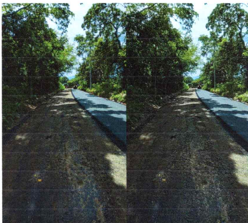
Tramo de pavimento ya terminado, costado derecho de la via
