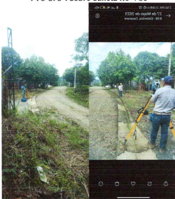
PTO GPS 3 punto de armada e inicio poligonal Sobre Cuneta K1+700
