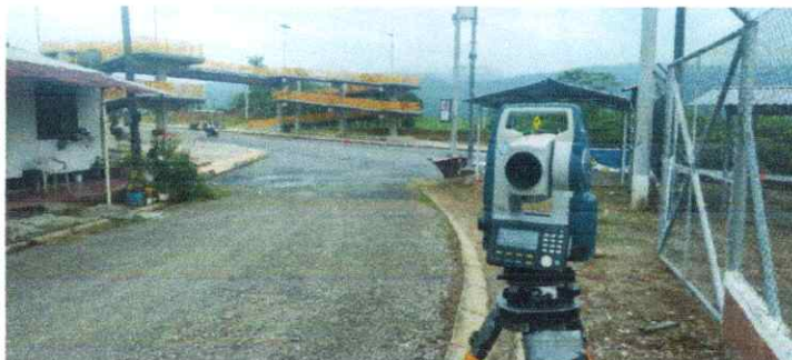
PUNTO GPS 4 Amarre y Empalme Vía Marginal K1+806
