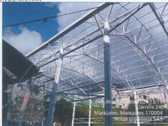
Ilustración 50 Estructura para cubierta
