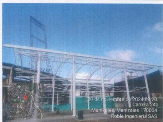
Ilustración 31 Vista lateral estructura para cubierta
