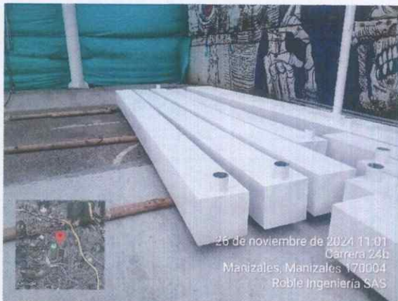
Ilustración 16 Aplicación pintura para canales
