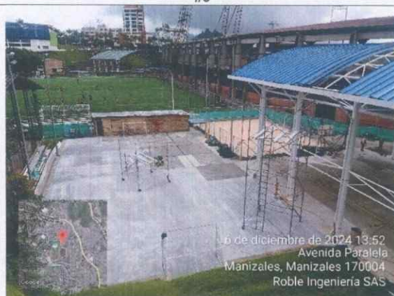
Ilustración 67 Vista superior de las intervenciones
