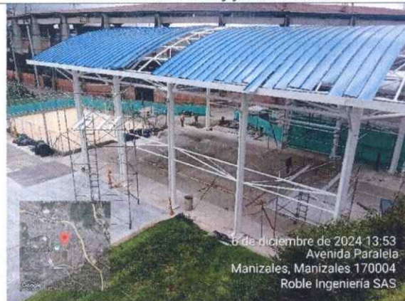
Ilustración 61 Vista superior de las intervenciones
