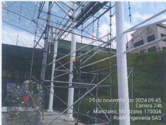
Ilustración 26 Aplicación pintura estructura metálica
