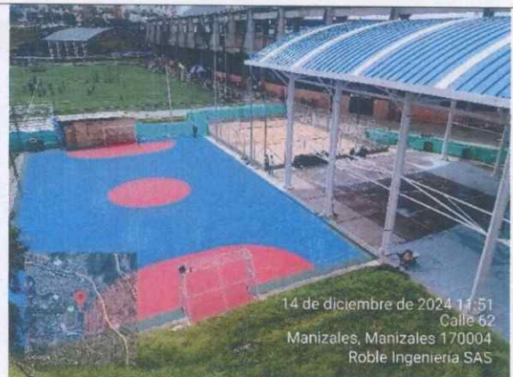
Ilustración 87 Vista superior de las intervenciones
