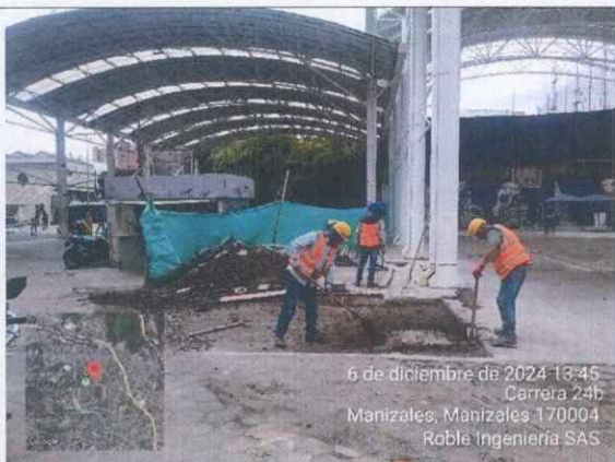
Ilustración 66 Aplicación de estructura para placa
