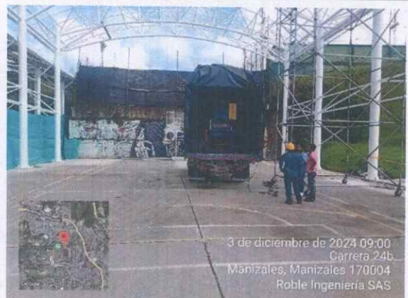
Ilustración 39 Equipos para elaboración de tejas
