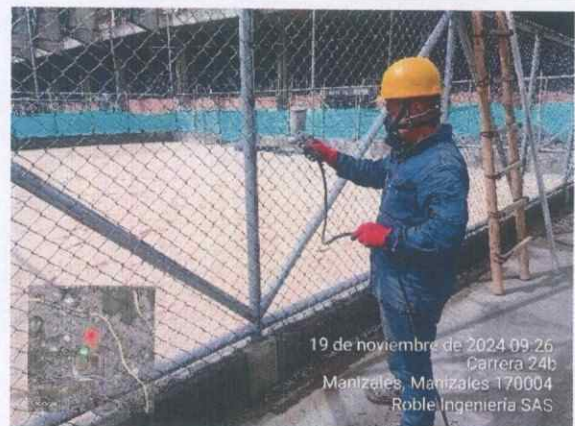
Ilustración 5 Aplicación de pintura malla eslabonada y postes
