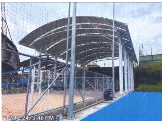
Ilustración 82 Vista lateral de las intervenciones
