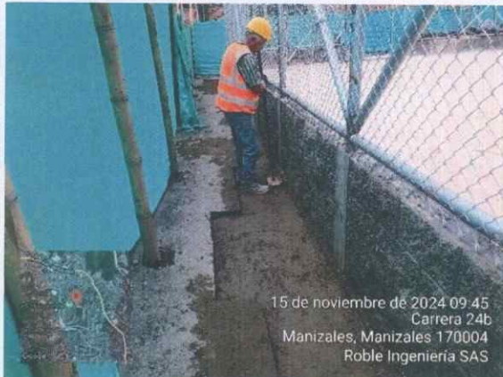
Ilustración 2 Compactación de afirmado
