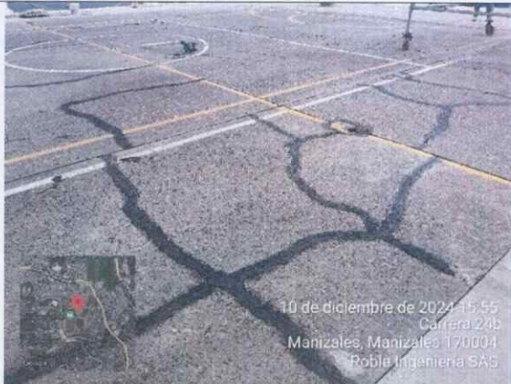
Ilustración 74 Instalación de sello para juntas y fisuras
