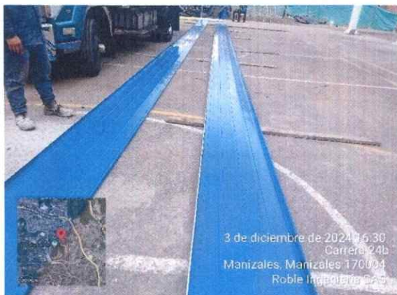
Ilustración 44 Elaboración de teja
