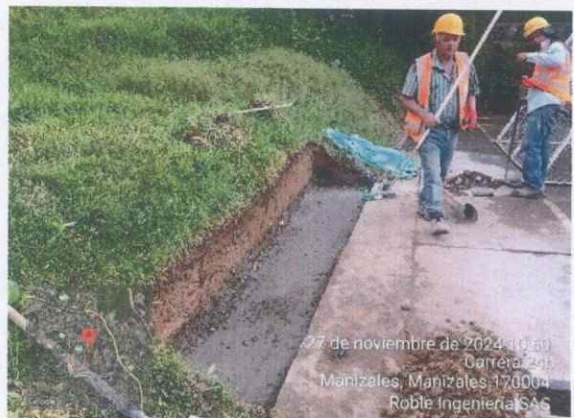
Ilustración 19 Excavación y traslado de arco norte cancha #4
