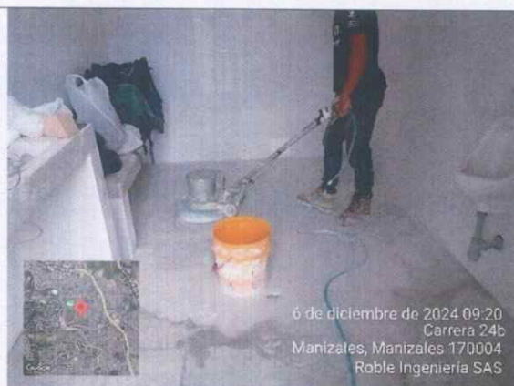
Ilustración 63 Brillado y pulido terrazo
