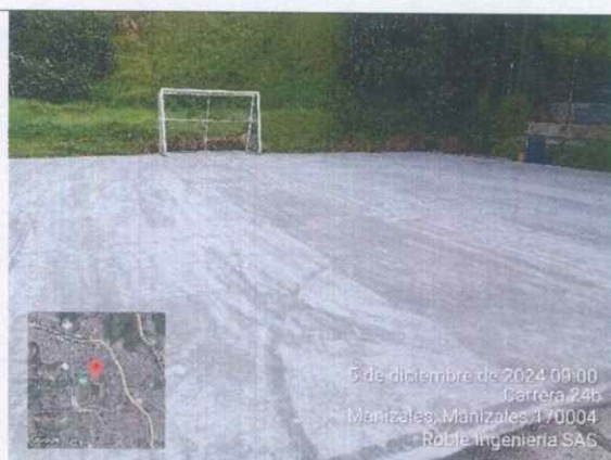
Ilustración 51 Aplicación de mortero autonivelante
