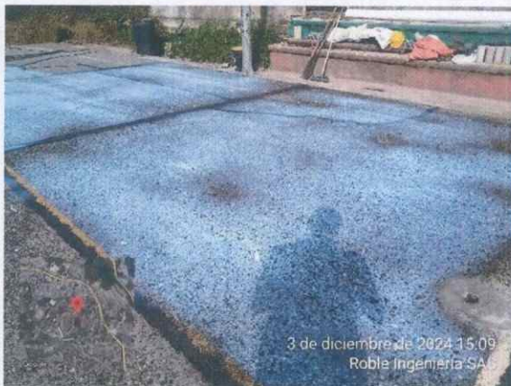
Ilustración 40 Lavado de losa cancha #4
