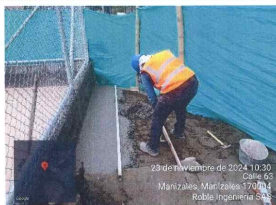
Ilustración 12 Placa de concreto para cierre área de seguridad
