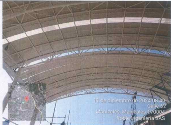
Ilustración 79 Instalación tejas cubierta cancha #3
