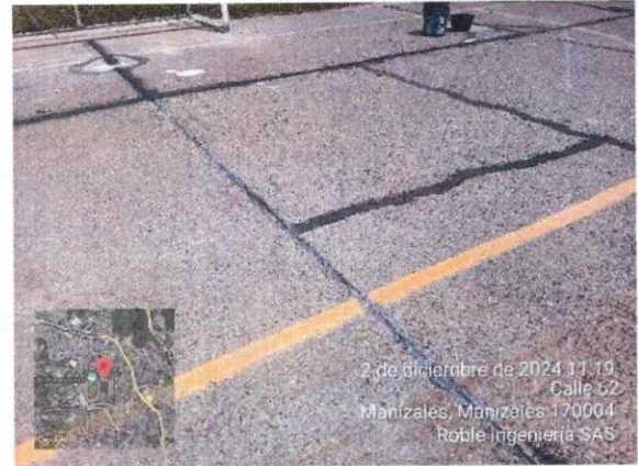
Ilustración 33 Sello de juntas y fisuras cancha #4
