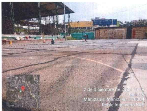
Ilustración 34 Aplicación de sello para juntas y fisuras
