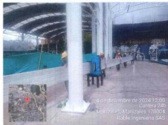
Ilustración 49 Generación de curvatura para teja
