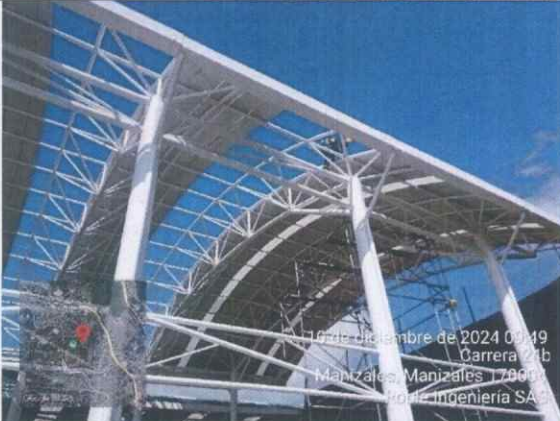
Ilustración 76 Instalación de tejas para cubierta
