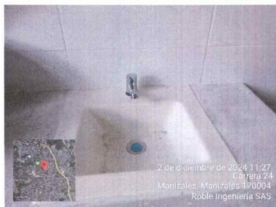
Ilustración 36 Instalación lavamanos de empotrar
