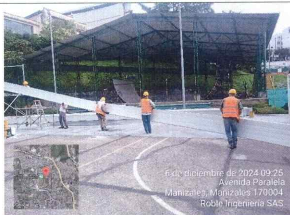
Ilustración 57 Montaje de tejas a cubierta
