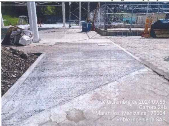
Ilustración 70 Losa de ingreso a Unidad Deportiva
