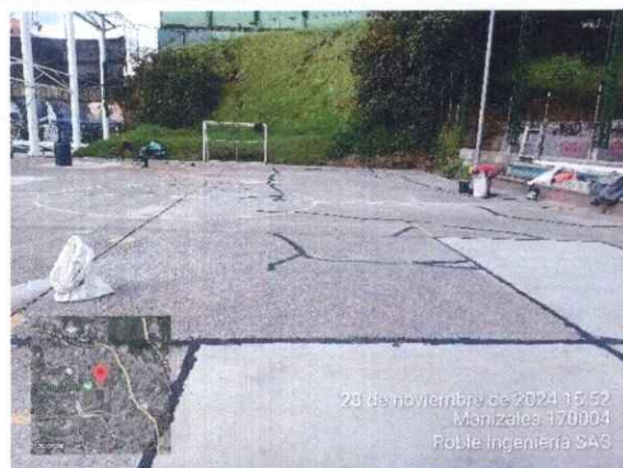
Ilustración 23 Sello de fisuras y juntas cancha #4
