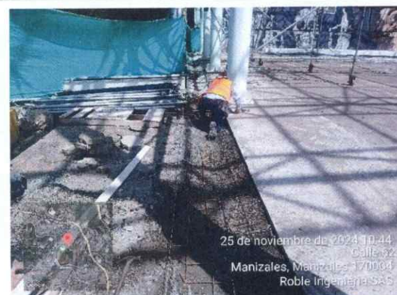
Ilustración 13 Malla electrosoldada para canal
