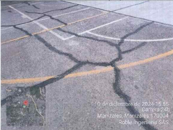
Ilustración 78 Aplicación de sello para juntas y fisuras
