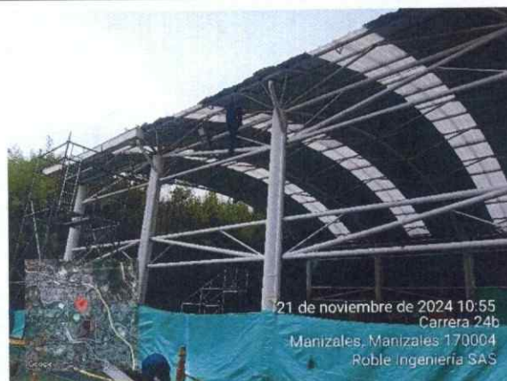
Ilustración 9 Desmonte de canal cancha #2
