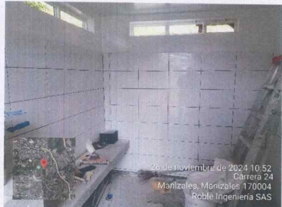
Ilustración 15 Instalación cerámica baños patinódromo
