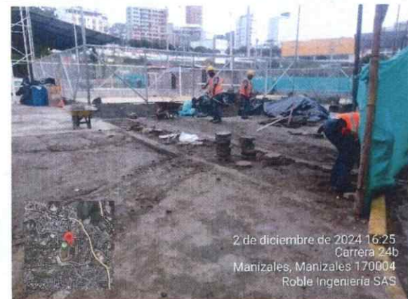
Ilustración 37 Reinstalación de adoquines
