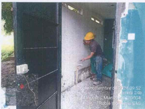
Ilustración 4 Sobre pique para instalación de cerámica en pared
