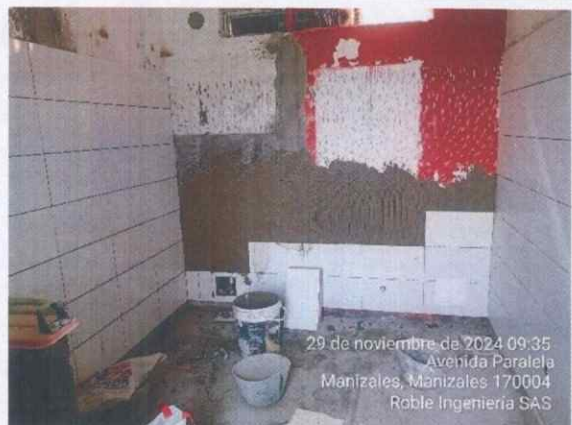
Ilustración 29 Instalación cerámica baños pátinódromo
