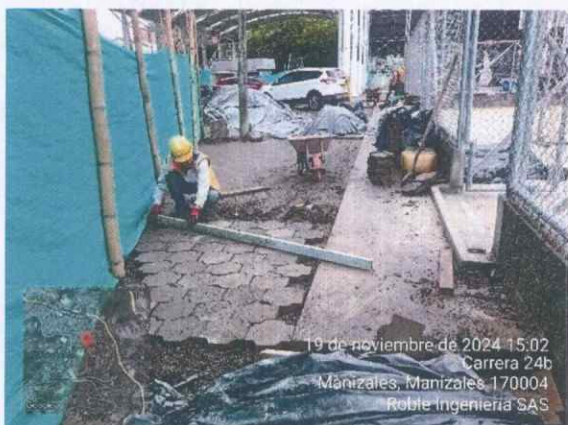
Ilustración 6 Reinstalación de adoquines
