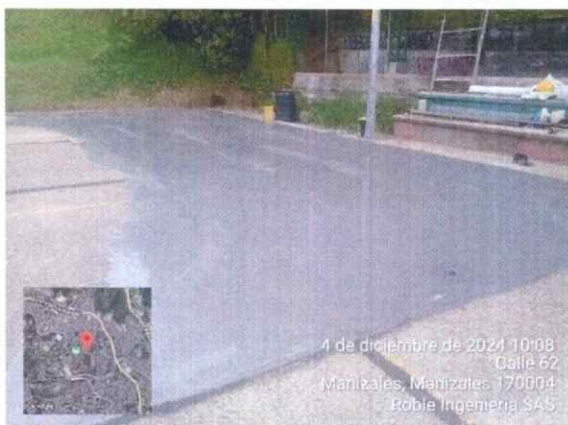
Ilustración 46 Aplicación de autonivelante
