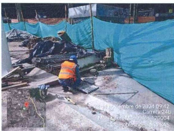
Ilustración 22 Instalación reja sumidero
