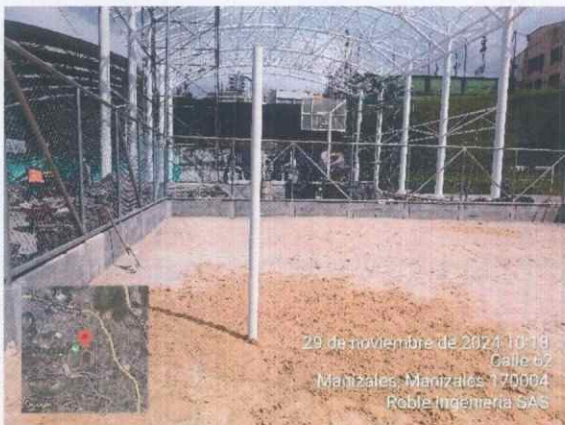
Ilustración 28 Instalación estructura para área de juego
