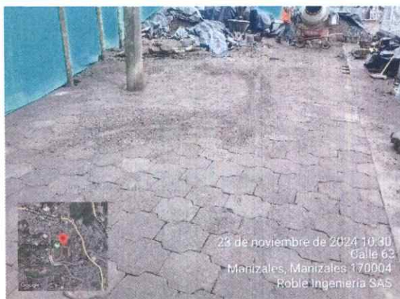
Ilustración 10 Reinstalación de adoquines
