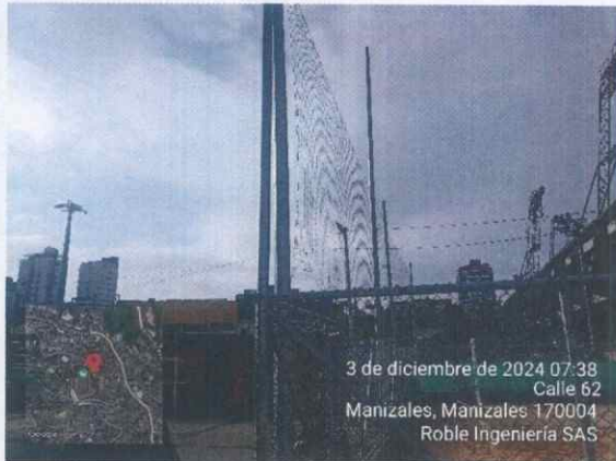
Ilustración 38 Instalación malla en nylon
