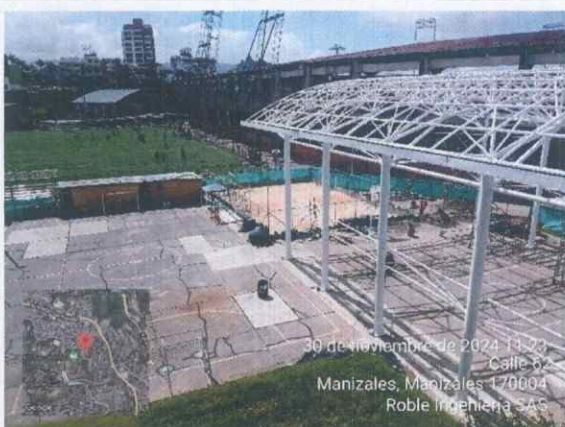
Ilustración 30 Vista superior de las intervenciones
