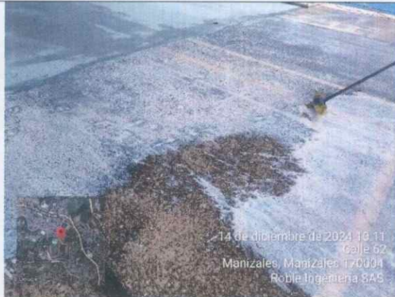
Ilustración 86 Lavado de losa cancha #3
