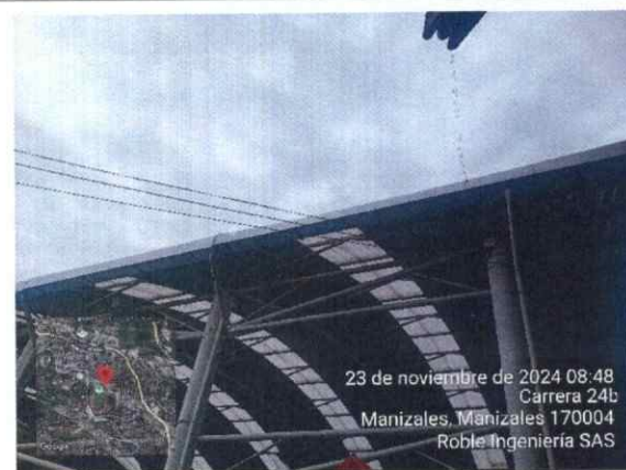
Ilustración 11 Instalación de canal cancha #2
