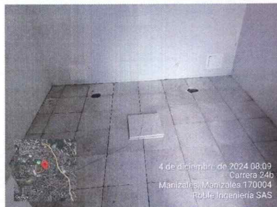
Ilustración 47 Instalación de terrazo
