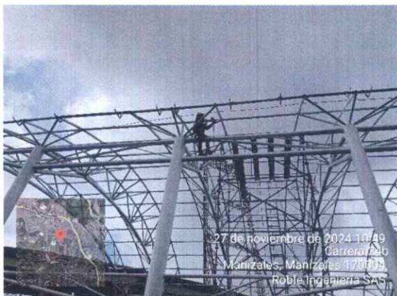
Ilustración 20 Aplicación de pintura estructura metálica
