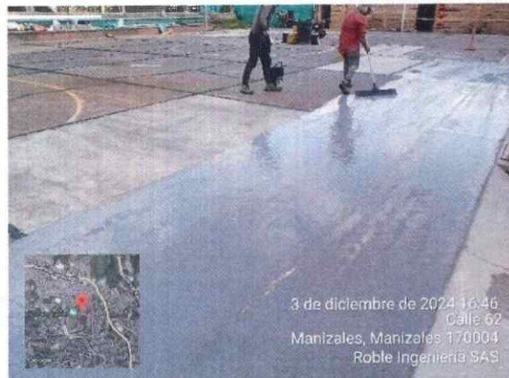
Ilustración 45 Aplicación de autonivelante cancha #4
