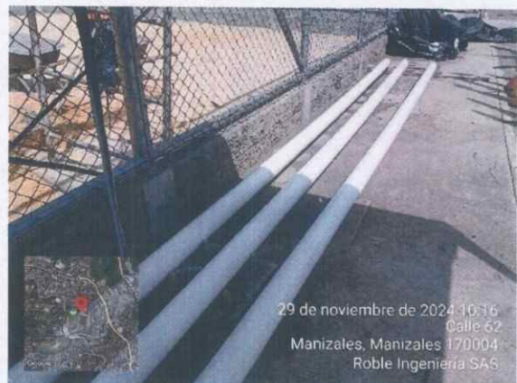
Ilustración 27 Aplicación pintura para bajantes
