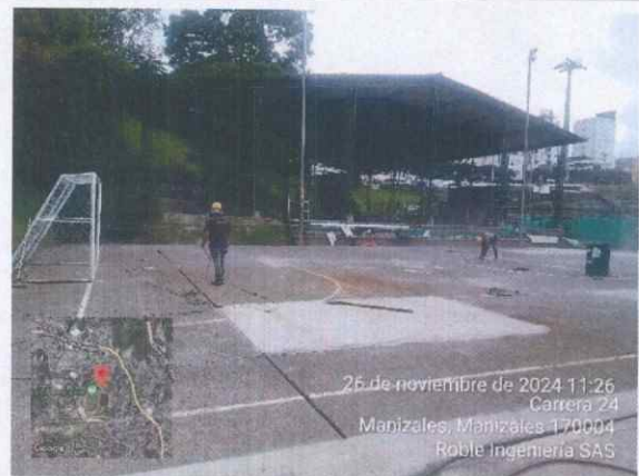
Ilustración 17 Sello de juntas para aplicación sintético
