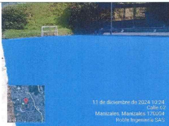
Ilustración 80 Aplicación capa 1 pintura sintéticos
