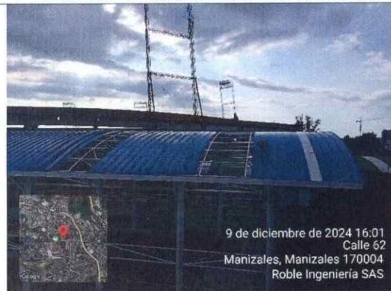
Ilustración 73 Instalación de tejas para cubierta
