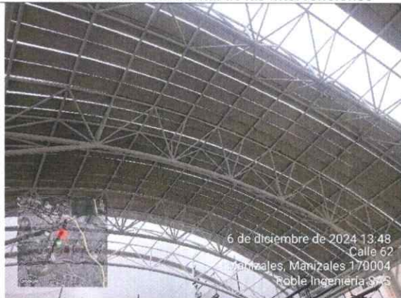
Ilustración 60 Instalación tejas en cubierta cancha #3
