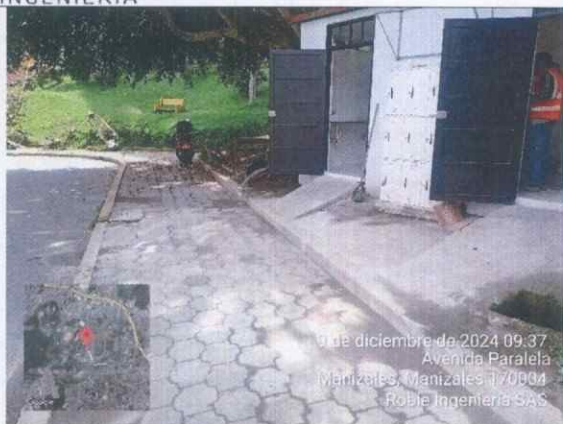
Ilustración 62 Limpieza zona exterior de los baños
