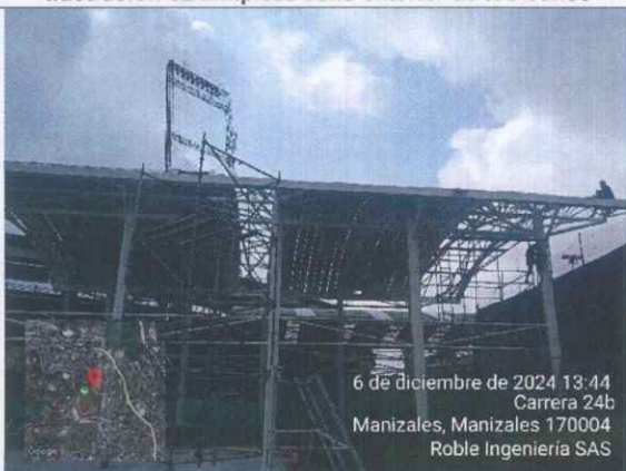
Ilustración 64 Instalación tejas para cubierta cancha #3
