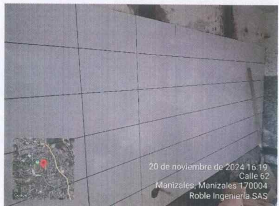
Ilustración 7 Instalación de cerámica
