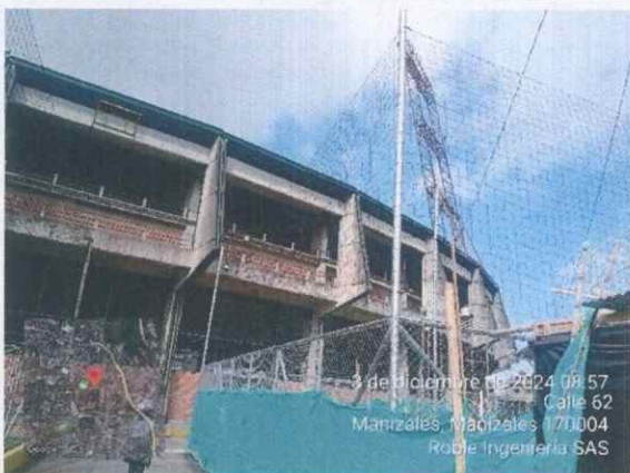
Ilustración 42 Instalación de malla de nylon
