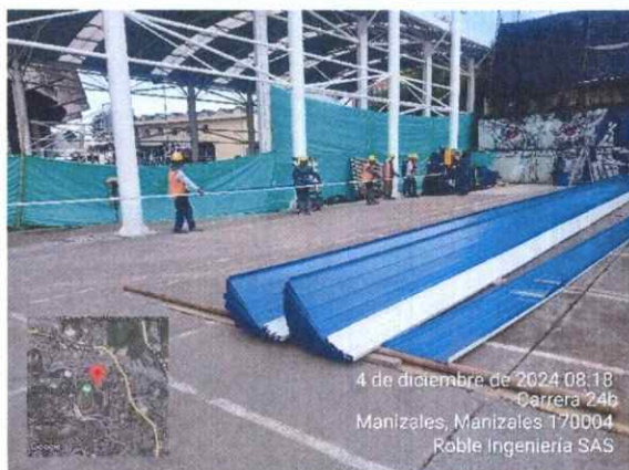
Ilustración 48 Elaboración de teja
