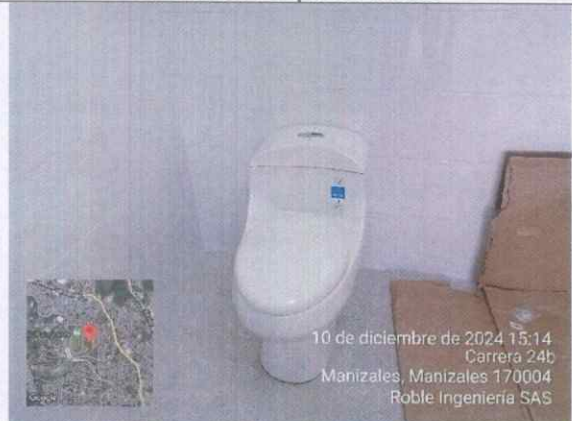
Ilustración 77 Instalación unidad sanitaria
