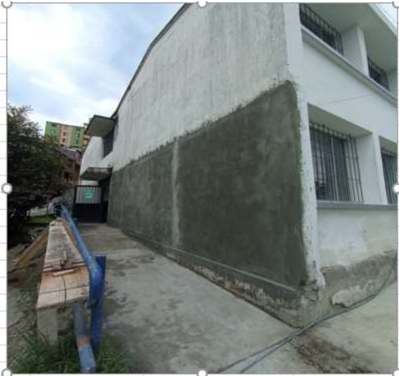
FACHADAS LATERALES EN GRANIPLAST Y PINTURA
