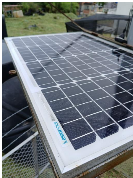
Figura 8. Limpieza a panel Solar, estación La Pola.
