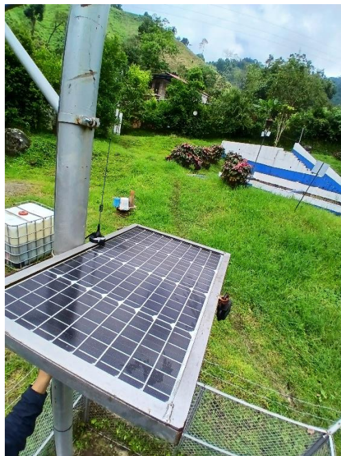
Figura 19. Limpieza panel solar
