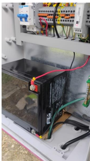
Figura 22. Instalación de la batería para la estación de IMDRI Parque deportivo.
