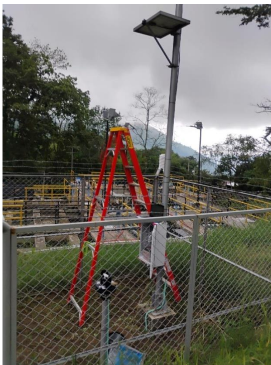
Figura 21. Ejecución del mantenimiento estación Chembe.
