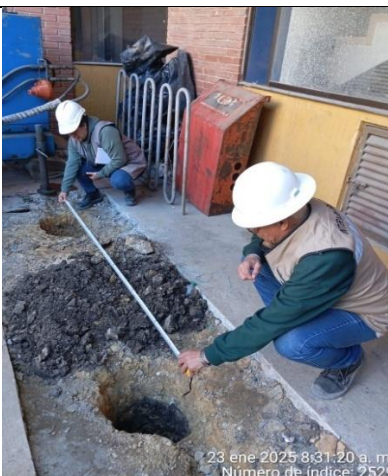
Verificación de la separación de los prehuecos para los micropilotes de prueba
