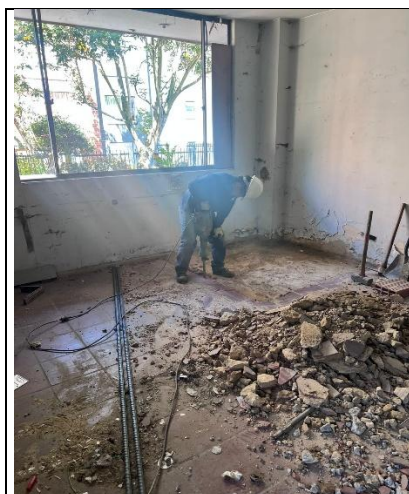
Demolición de piso 4to nivel
