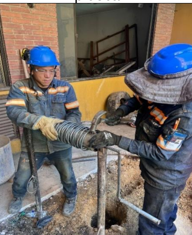
Configuración de hierro para micropilotes de prueba
