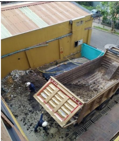
Retiro de material producto de la excavación del poso de lodos
