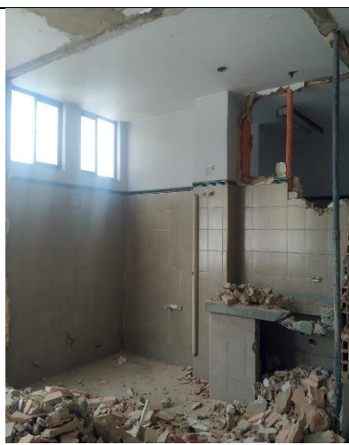
Demolición de muros internos
