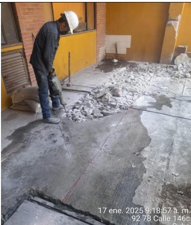
Demolición de placa para localización de micropilotes de prueba
