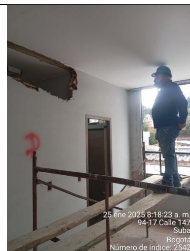
Demolición de muros
