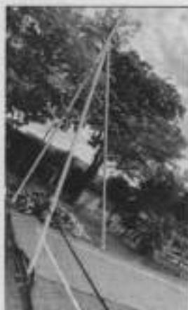
Adecuación. Reparación y puesta en funcionamiento de la tubería de la estructura de cerramiento. Incluye soldadura, resane y pintura
