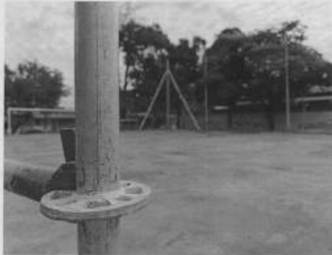
Ilustración 12 Inspección de andamios utilizados para actividades de alto riesgo
