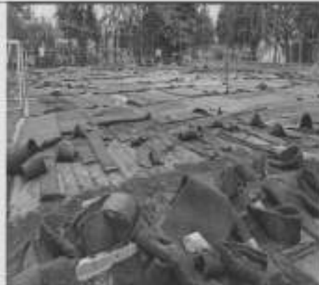
ii Residuos segregados antes del transporte
