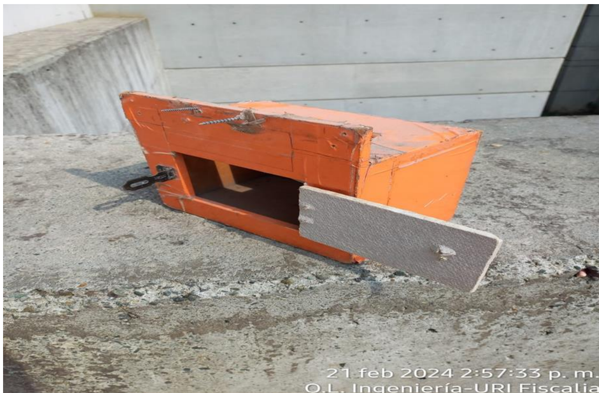
Imagen 3. Revisión del buzón de sugerencias. Parte 2
