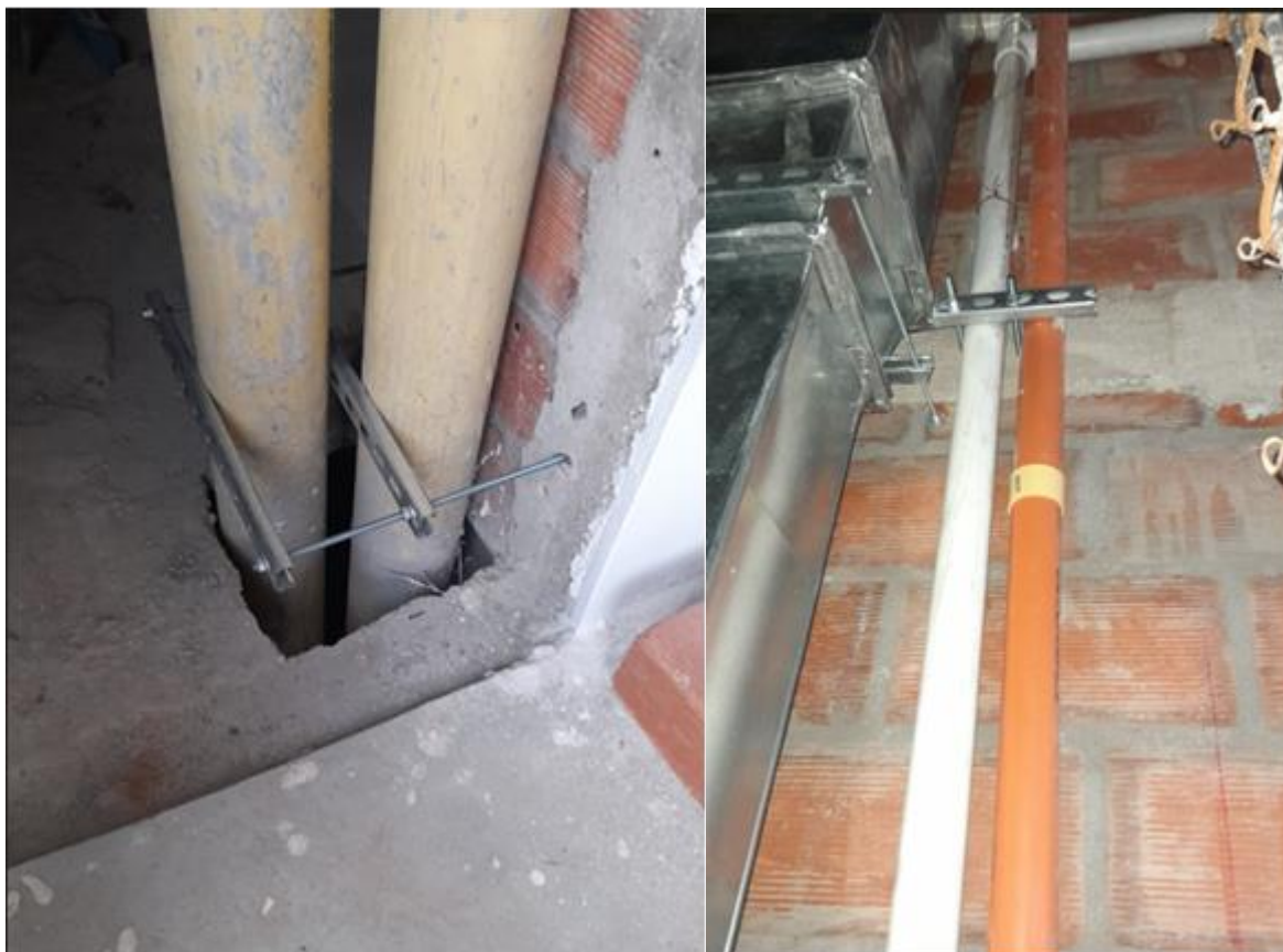
Imagen 13. Fijación de tuberías
