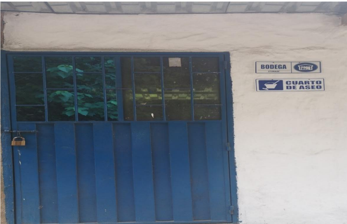
Cuarto de aseo
