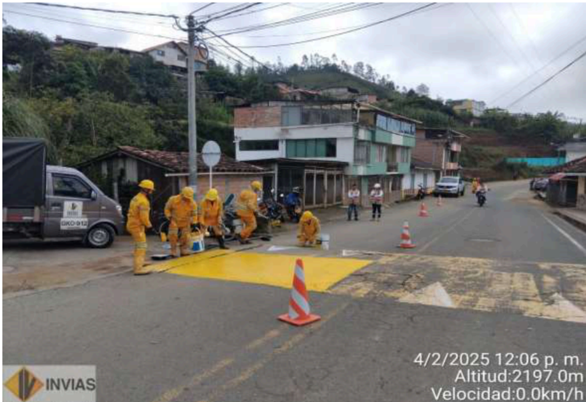
MANTENIMIENTO RESALTOS MUNICIPIO LA FLORIDA CON PERSONAL MANTENIMIENTO ROUTINARIO RUTA 2501B
