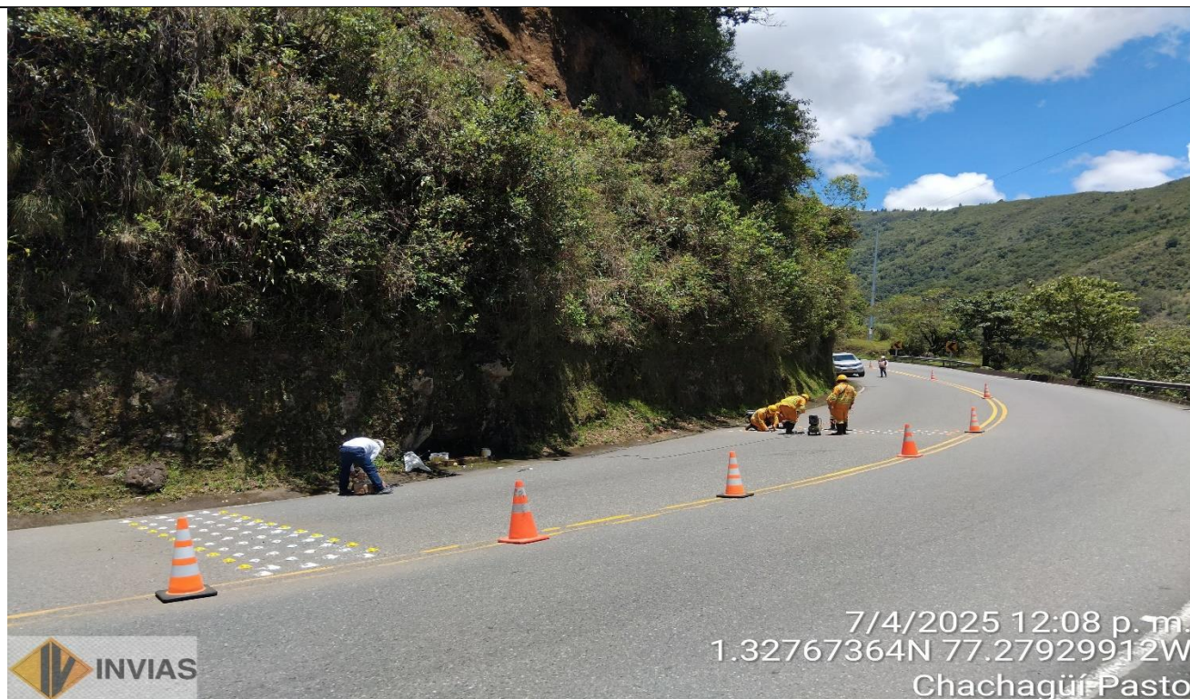
INSTALACION DE ESTOPEROLES RUTA 2502, SECTOR CHACHAGUI (CASABUY)
