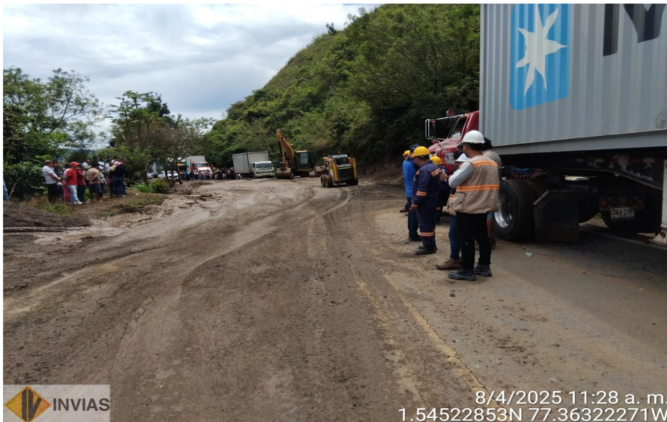
ATENCION DE EMERGENCIA RUTA 2502, PR70+0000 SECTOR TABLON PANAMERICANO
