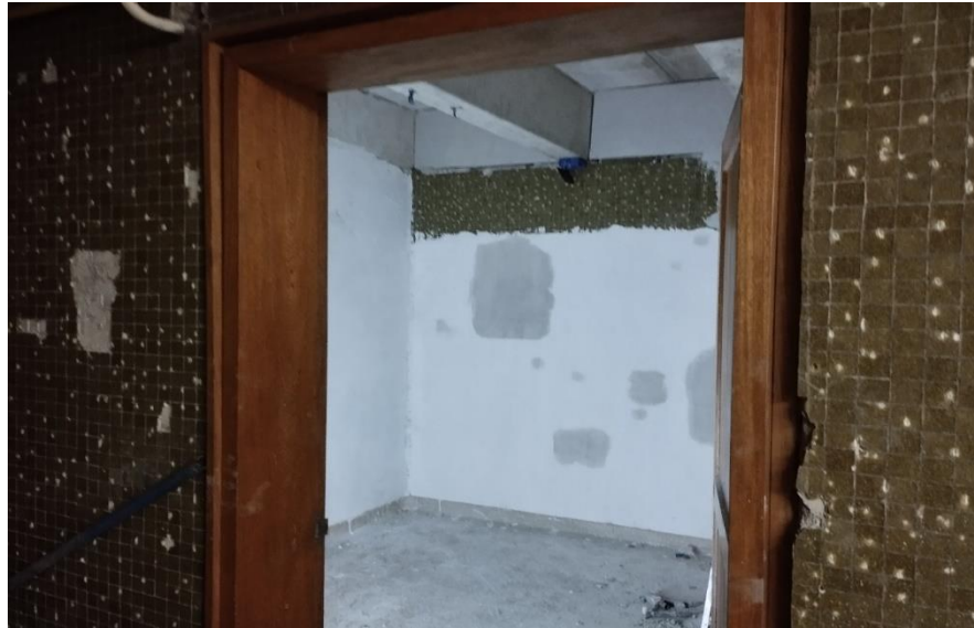
ADECUACION MUROS EN ARGAMASA
