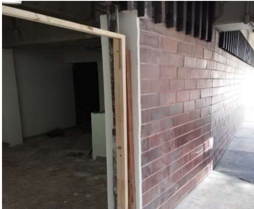
COLUMNETA EN CONCRETO EN VANO PUERTA
