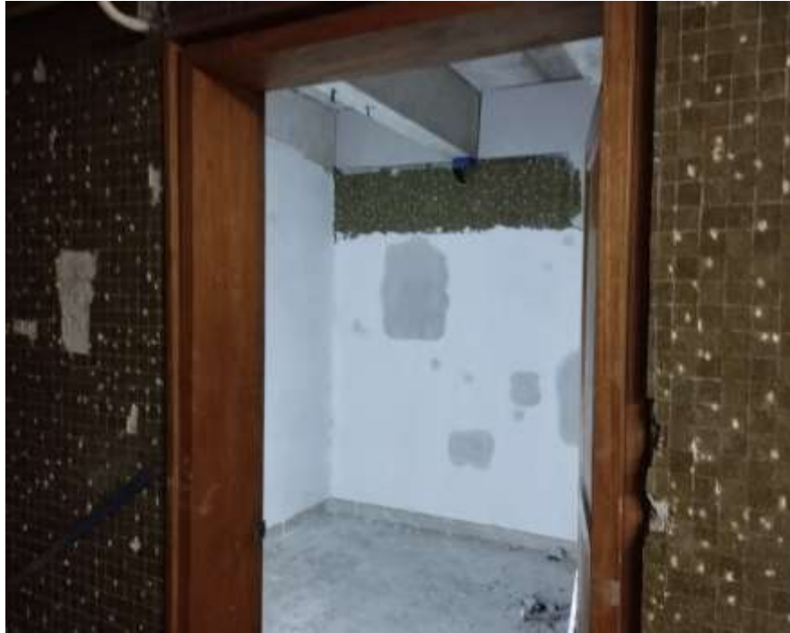
ADECUACION MUROS EN ARGAMASA
