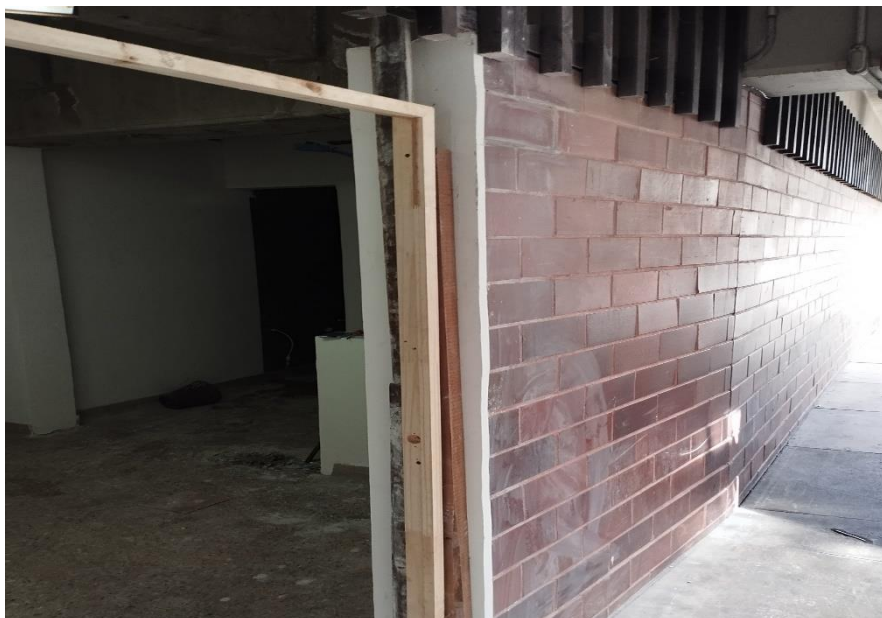
COLUMNETA EN CONCRETO EN VANO PUERTA
