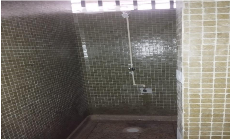
ADECUACION DE DUCHA
