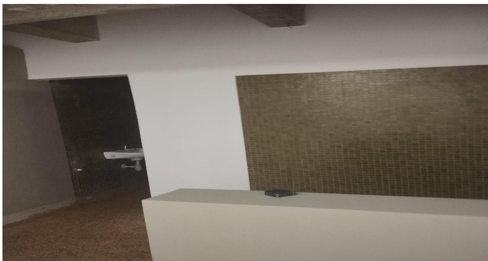
PINTURA Y ASEO GENERAL
