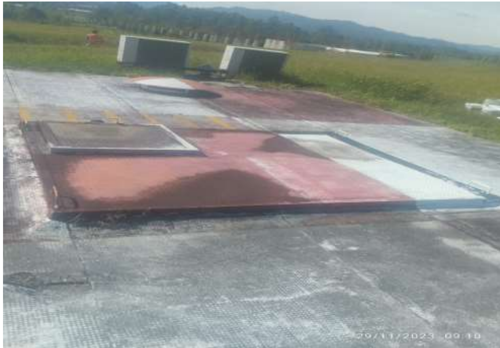
RETIRO MANTO Y LAVADO ZONA LADO AIRE
