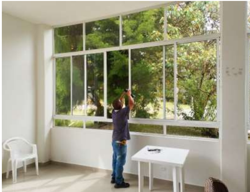
REPARACION CHAPAS VENTANAS
