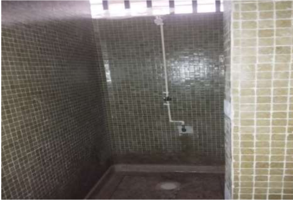
ADECUACION DE DUCHA
