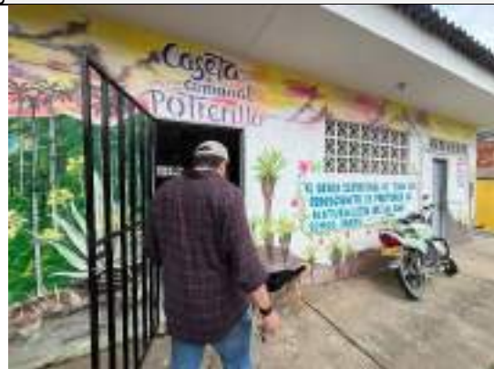
Fachada de la caseta comunal del corregimiento de Potrerillo.
