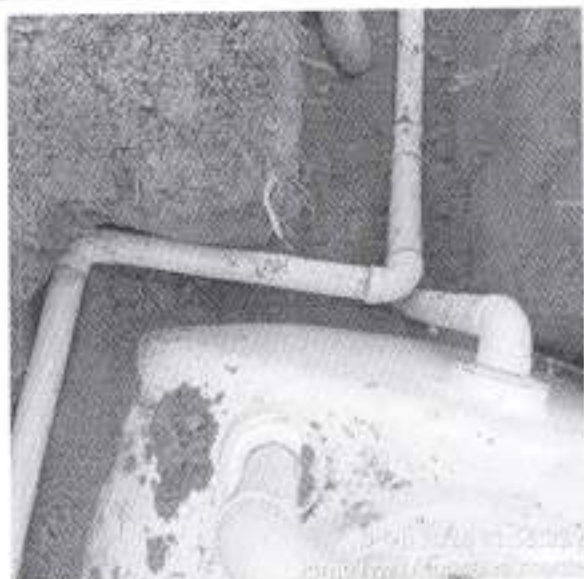
Imagen 6. Detalle de la junta y codo de PVC.
