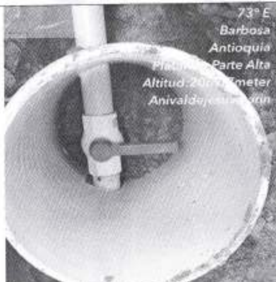
Imagen 8. Vista interior de la tubería.
