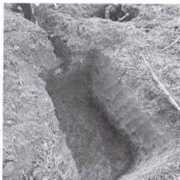
Imagen 3: Excavación manual de pozos.
