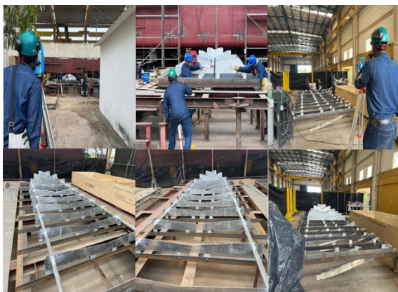
Foto No. 27 a 32 – Construcción y alineación de cunas
