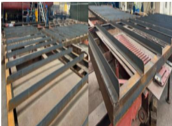
Foto No. 01 a 02 – Construcción de cunas
