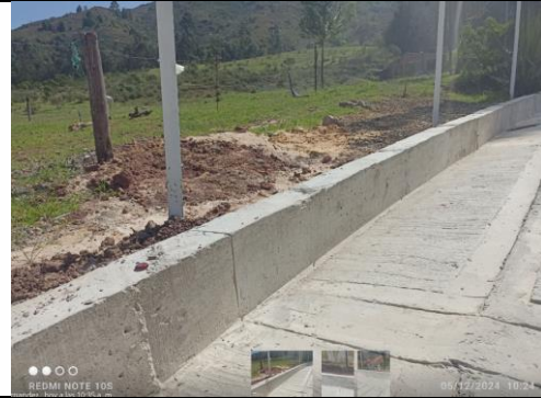
Imagen 12: Corte de dilatación de bordillo k0+150.
