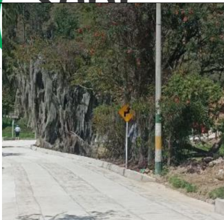
Imagen 17: Instalación de señales k0+0
