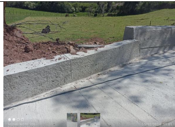
Imagen 8: Corte de dilatación de bordillo k0+040.
