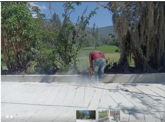
Imagen 9: Corte de dilatación de bordillo k0+070.
