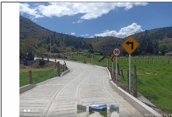
Imagen 15: Instalación de señales k0+020
