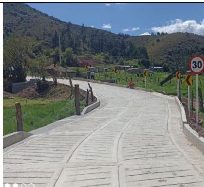
Imagen 19: Instalación de delineadores de curva entre k0+015/080.
