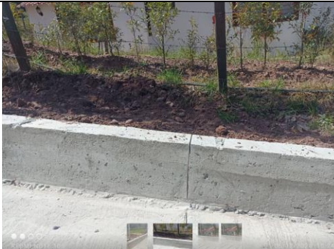
Imagen 13: Corte de dilatación de bordillo k0+165.
