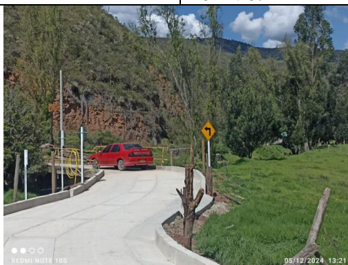
Imagen 19: Instalación de señales k0+015.
