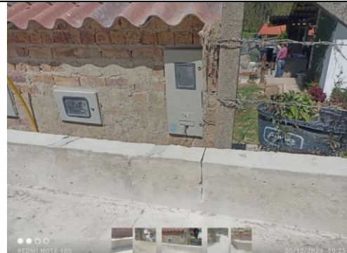
Imagen 14: Corte de dilatación de bordillo k0+185.
