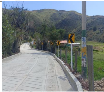
Imagen 20: Instalación de delineadores de curva entre k0+015/080.
