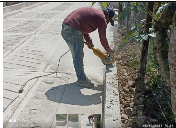
Imagen 10: Corte de dilatación de bordillo k0+090.
