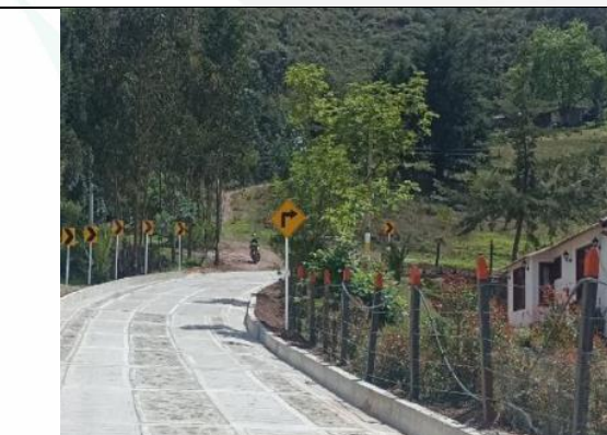
Imagen 16: Instalación de señales k0+130.
