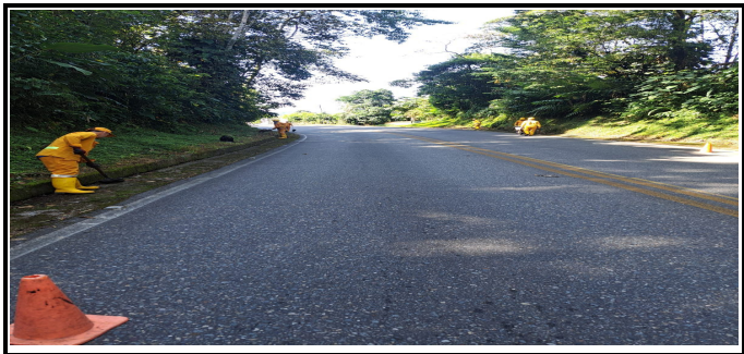
Limpieza de cunetas alcantarillas descoles y recolección de señales de tránsito, RUTA 40 MTA
