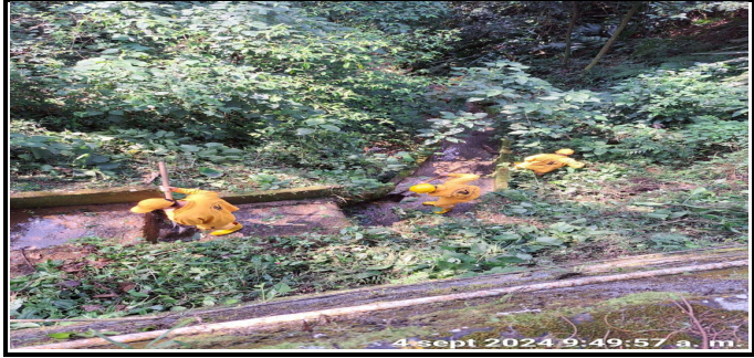
Limpieza de cunetas alcantarillas y descoles del PR 85+000 al PR 86+000
