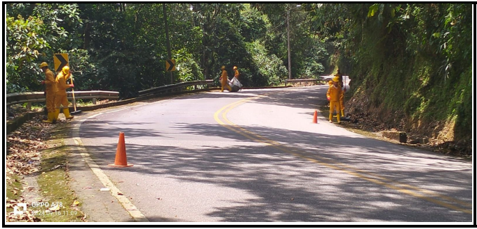
Limpieza de cunetas alcantarillas y descoles del PR 80+000 al PR 82+000 RUTA 40MTA
