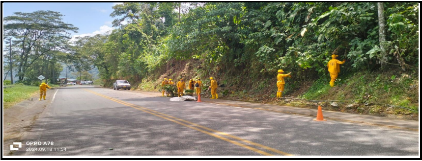
Limpieza de cunetas alcantarillas y descoles del PR 82+500 al PR 83 +500 RUTA 40MTA
