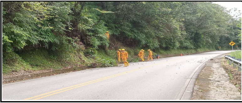
Limpieza de cunetas alcantarillas y descoles del PR 84+500 al PR 85+500 RUTA 40MTA
