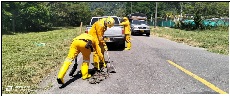
Mantenimiento del PR 92+200 al PR 93+000 RUTA 40MTA
