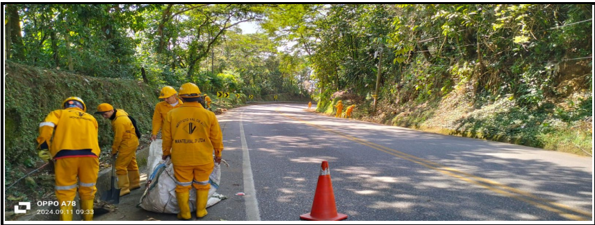
Limpieza de cunetas alcantarillas y descoles del PR 91+290 al PR 92+200 RUTA 40MTA
