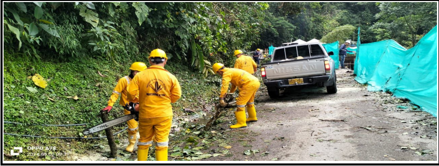
Retiro de árboles y derrumbes en la RUTA 40 MTA
