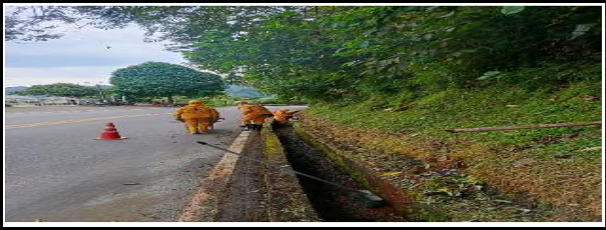
Mantenimiento general del PR 90+000 al PR 91+000 RUTA 40MTA
