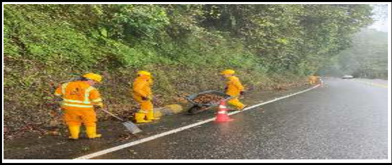
Mantenimiento general del PR 91+000 al PR 92+000 RUTA 40MTA
