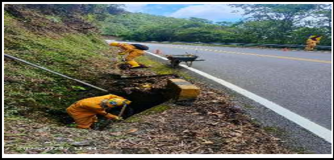
ntenimiento general del PR 87+000 al PR 88+100 RUTA 40M'
