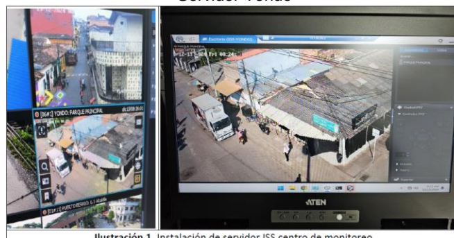
Ilustración 1. Instalación de servidor ISS centro de monitoreo.
