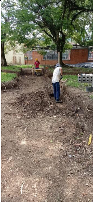
Excavación para bordillos prefabricados
