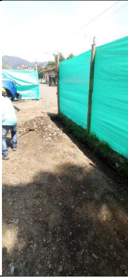
Excavación para tubería sumideros.
