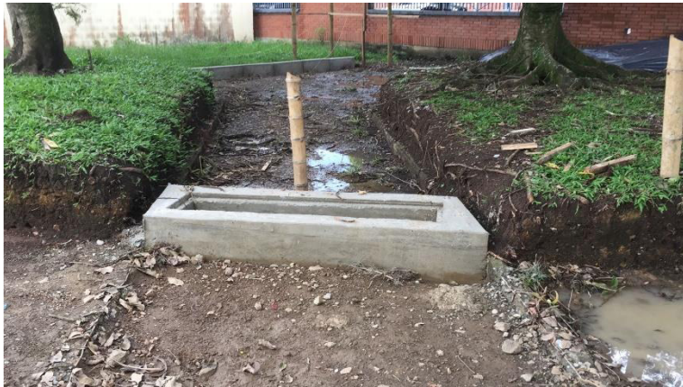
Excavasion para conexión sanitaria.
