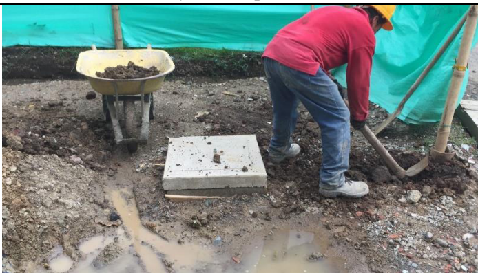
Afirmado y compactado
