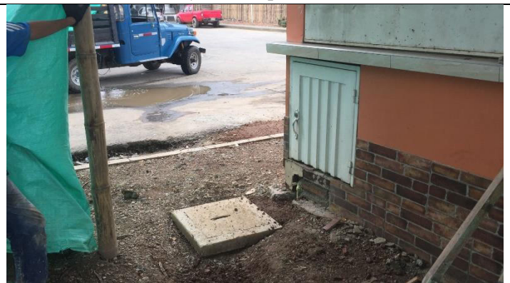
Afirmado y compactado.
