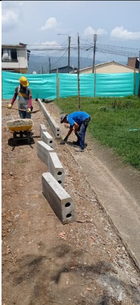
Instalación bordillo sobre carrera 13.
