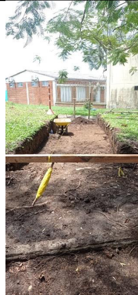
Cargue y retiro de material
