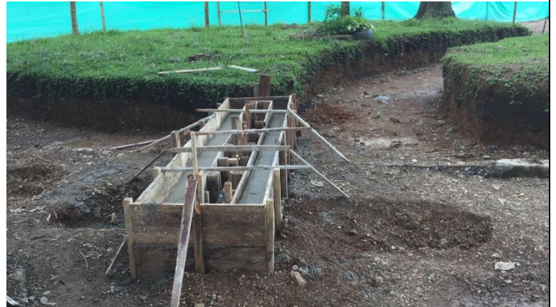
Excavasion para conexión sanitaria.
