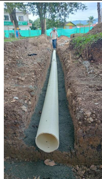
Compactación de afirmado.
