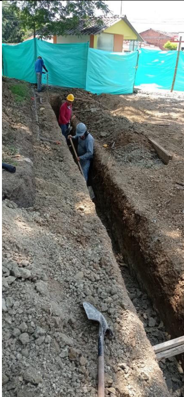
Instalación bordillos lado sur.
