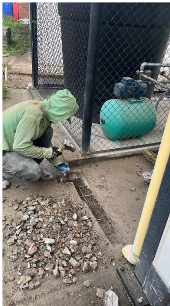
Foto 13. Excavación del cárcamo.
