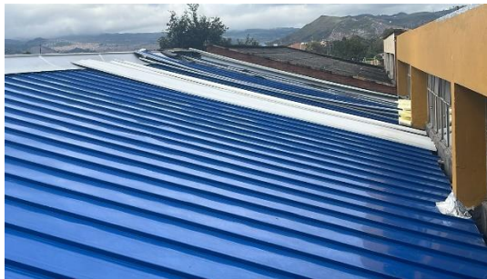
Foto 3. Estado de la cubierta.
