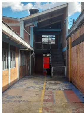
Foto 19. Estado del frente de obra.
