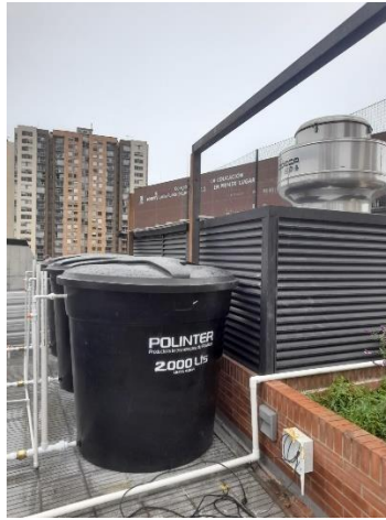
Foto 14. Instalación de tanques.
