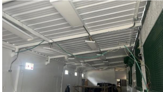
Foto 18. Instalación de tejas para cubierta.
