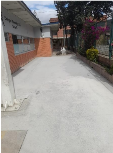
Foto 11. Trabajos de fundida de placa.
