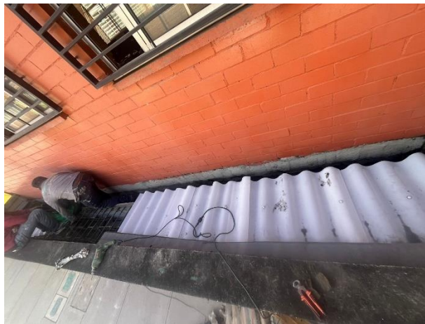
Foto 22. Desmonte de cubierta
