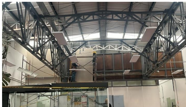
Foto 9. Instalación de Super Board.
