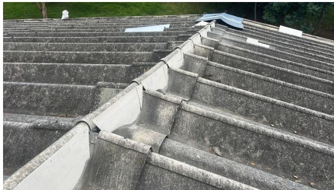
Foto 6. Trabajos en la cubierta del área polivalente.
