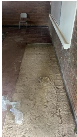
Foto 5. Trabajos en los salones.
