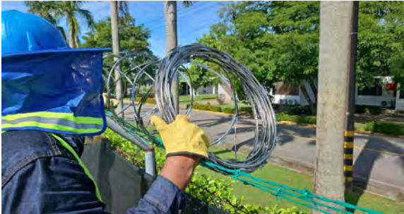
INSTALACIÓN DE CONCERTINA FRENTE PRINCIPAL DE LA UNIDAD
