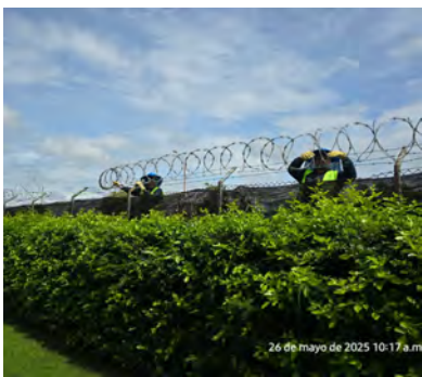
INSTALACIÓN DE CONCERTINA Y ALAMBRE DE PUA
