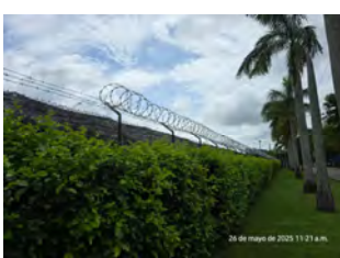
INSTALACIÓN DE ALAMBRE DE PUA
