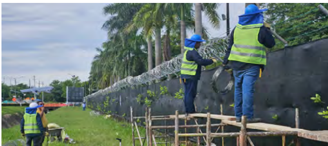
INSTALACIÓN DE CONCERTINA FRENTE PRINCIPAL DE LA UNIDAD
