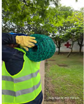
INSTALACIÓN DE ALAMBRE DE PUA
