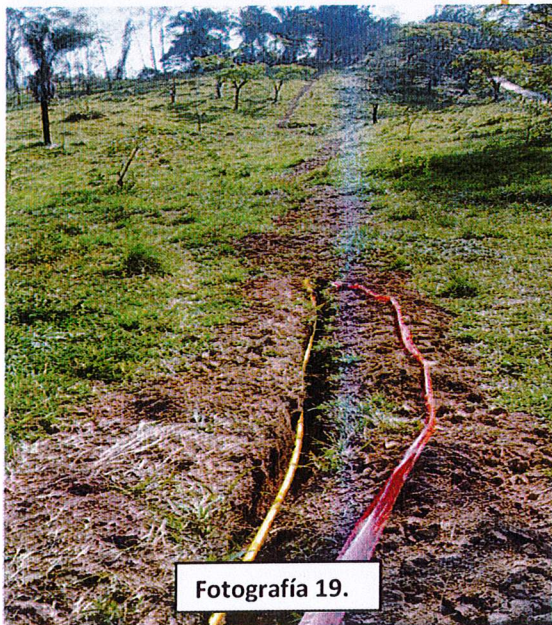
Fotografía 17-20. Relleno en material seleccionado de la excavación compactado para línea de gas.
