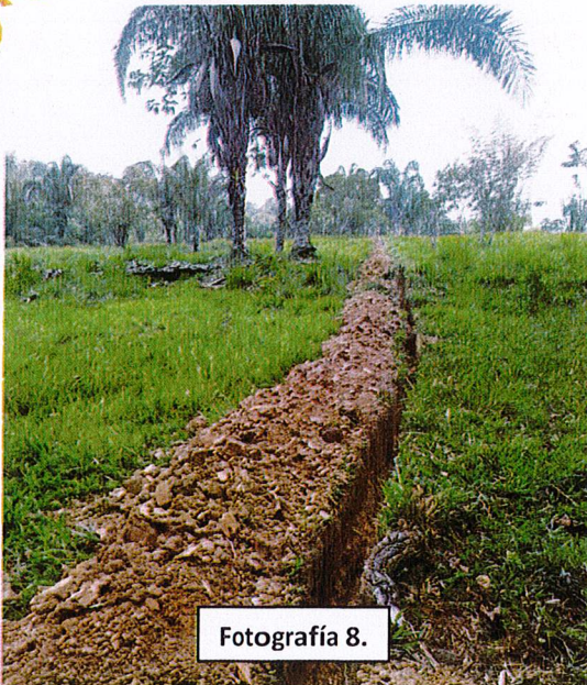
Fotografía 5-8. Excavación a mano en material común línea de gas
