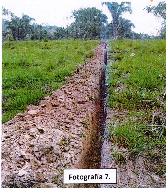
Fotografía 5-8. Excavación a mano en material común línea de gas
