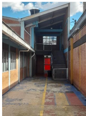
Foto 18. Estado del frente de obra.
