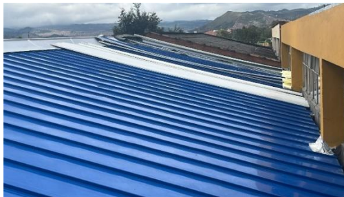
Foto 3. Estado de la cubierta.
