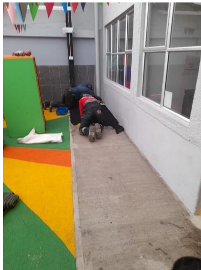
Foto 16. Actividades de instalación de piso chip.
