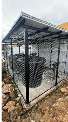
Foto 4. Trabajos en el cuarto de bombas.
