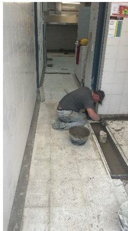
Foto 7. Instalación de cárcamos.
