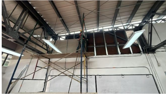
Foto 8. Instalación de Super Board.
