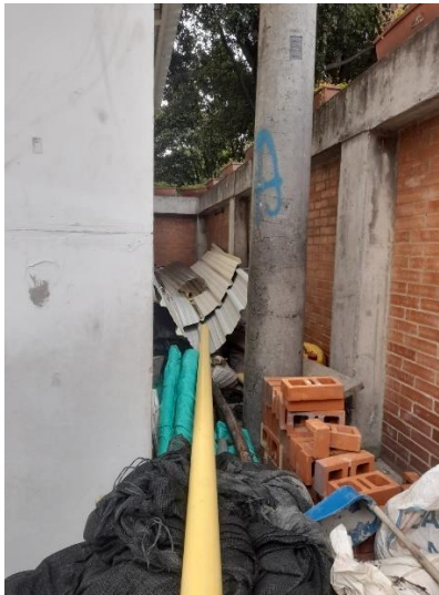
Foto 2. Limpieza de Material.
