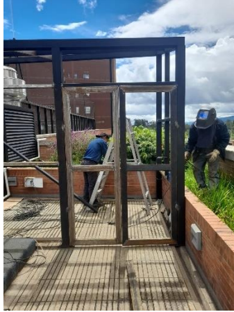
Foto 13. Instalación de tanques y cerramiento.
