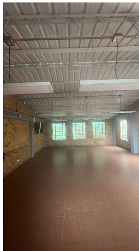
Foto 5. Trabajos en el salón de informática.
