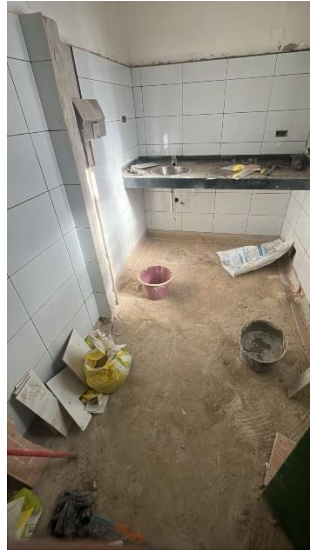
Foto 17. Trabajos en el baño de rectoría.
