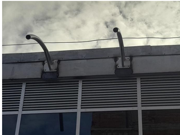
Foto 9. Trabajos de la pérgola.
