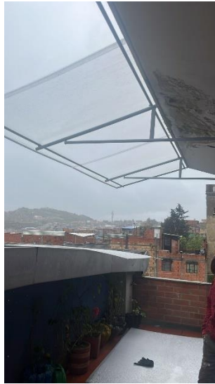
Foto 20. Instalación de la cubierta alveolar.
