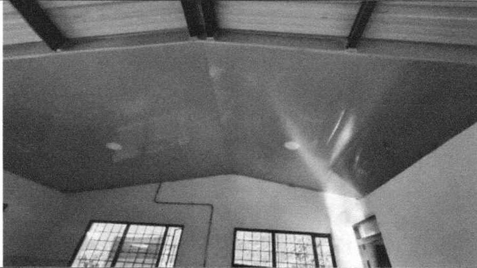
25. SALIDA PARA LUMINARIA CABLE 12AWG HFFR LS PVC 1/2".
