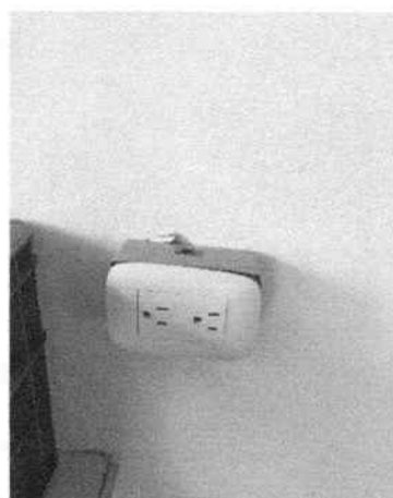
22. SALIDA TOMA DOBLE CABLE 12AWG HFFR-LS PVC 1/2 COMPLETA
