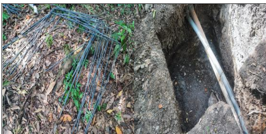
Viotá - paso elevado
