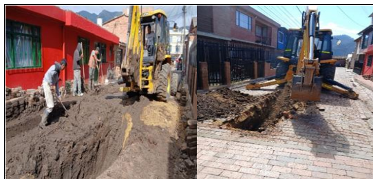
Tabio - alcantarillado centro
