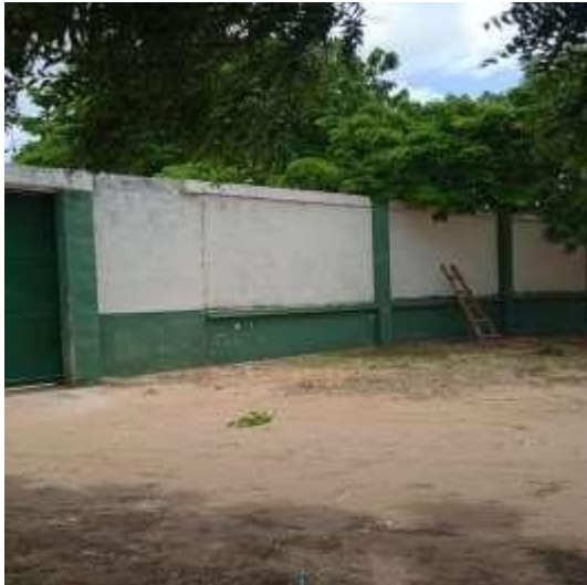
Foto 20: Muro antes de hacer el Mural.
