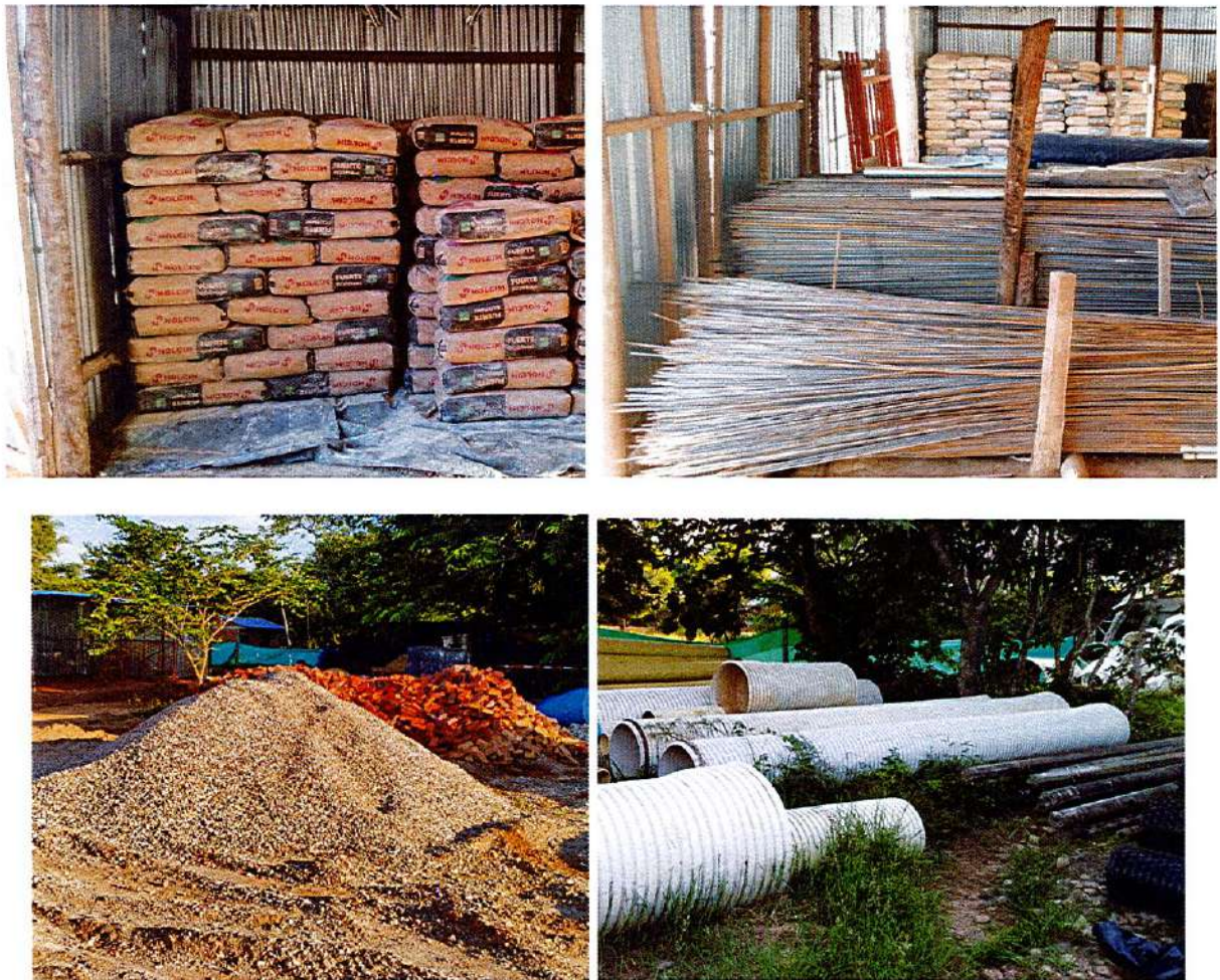
IMAGEN 44. ALMACENAMIENTOS MATERIALES DE CONSTRUCCIÓN EN EL CAMPAMENTO
