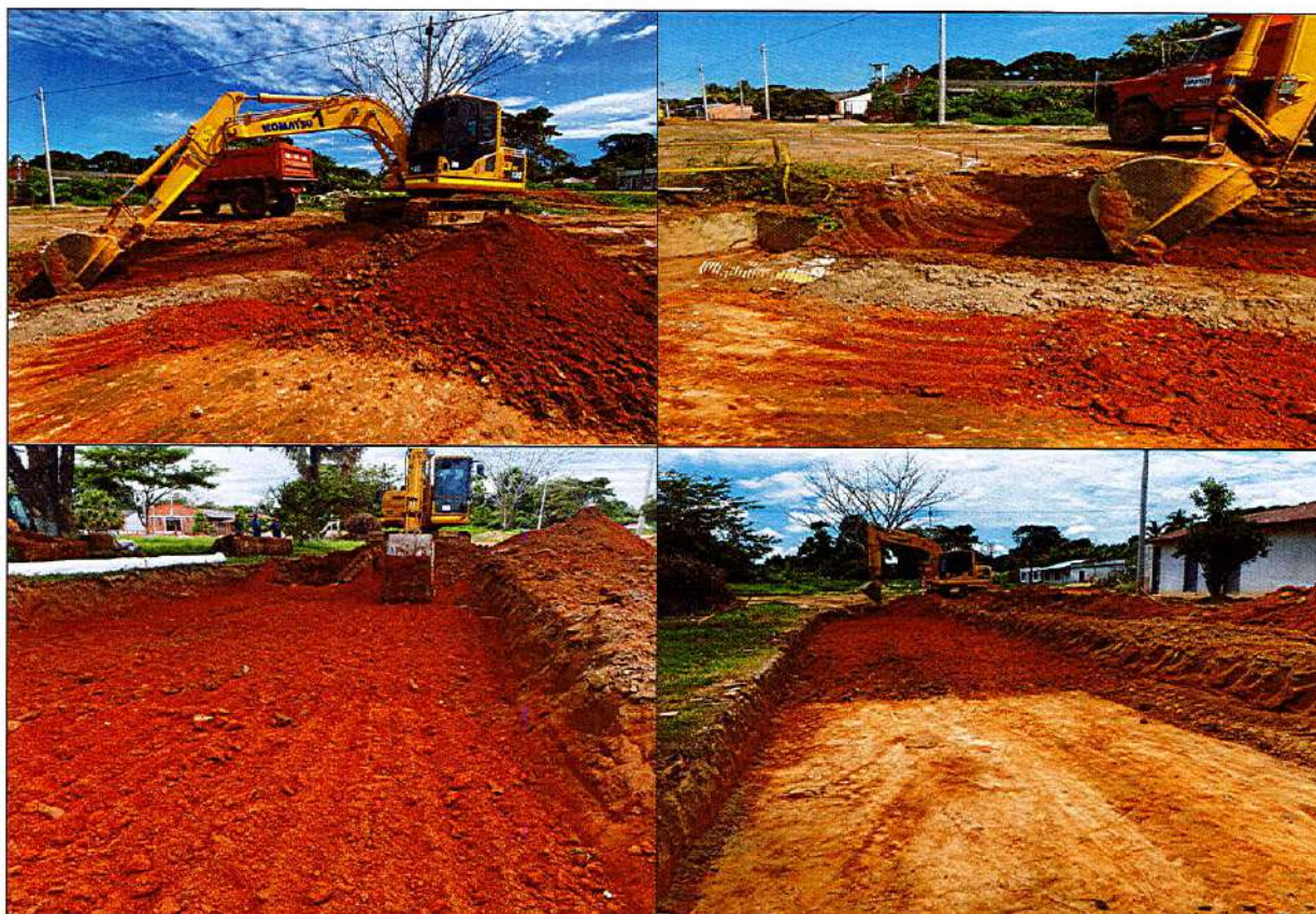
IMAGEN 21. EXCAVACIÓN DE CORTES, CANALES Y PRÉSTAMO
