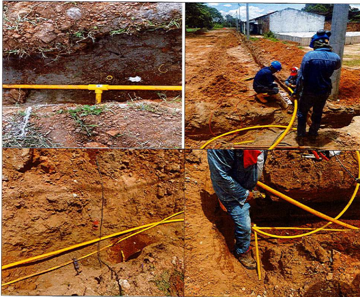
IMAGEN 17. REPARACION TUBERIA DE GAS POLIETILENO
