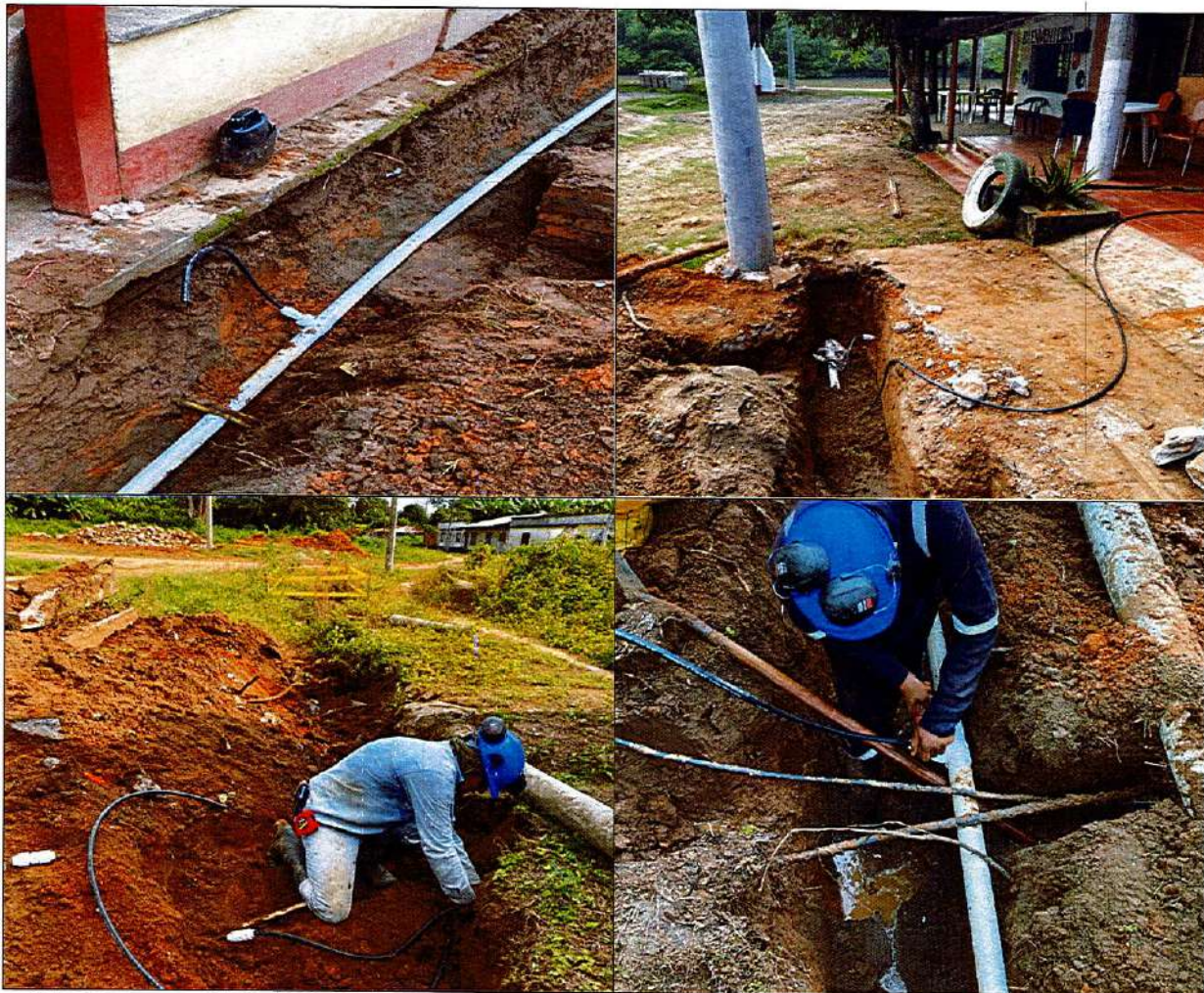
IMAGEN 15. REPARACIÓN DE ACOMETIDA PF+UAD DE 1/2" PARA ACUEDUCTO
