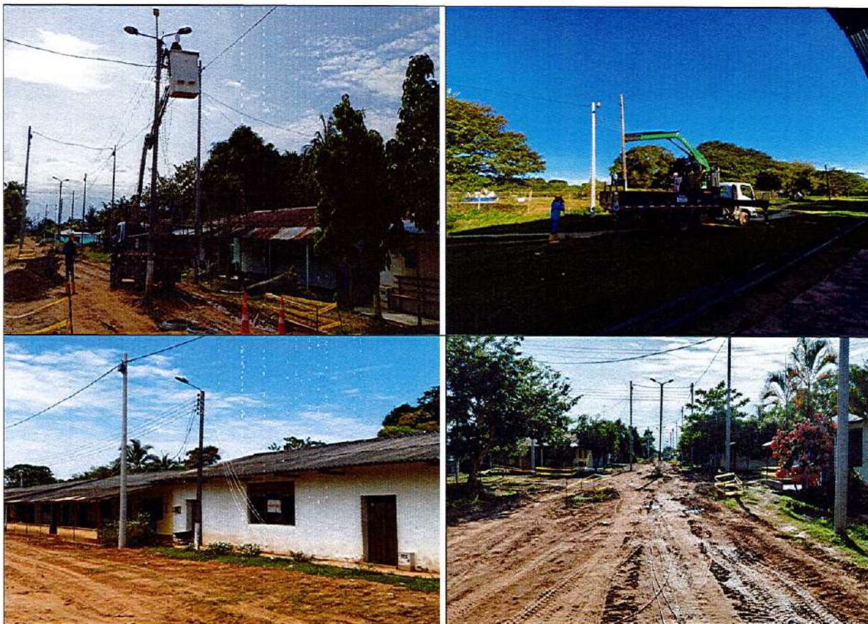
IMAGEN 26. DESMANTELAMIENTO DE RED DE BAJA TENSION
