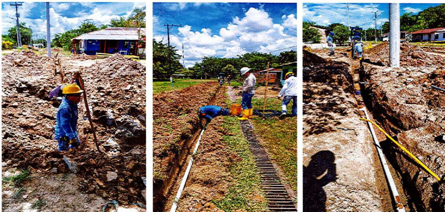
IMAGEN 52. AVANCES EN LA INSTALACION DE TUBERIAS
