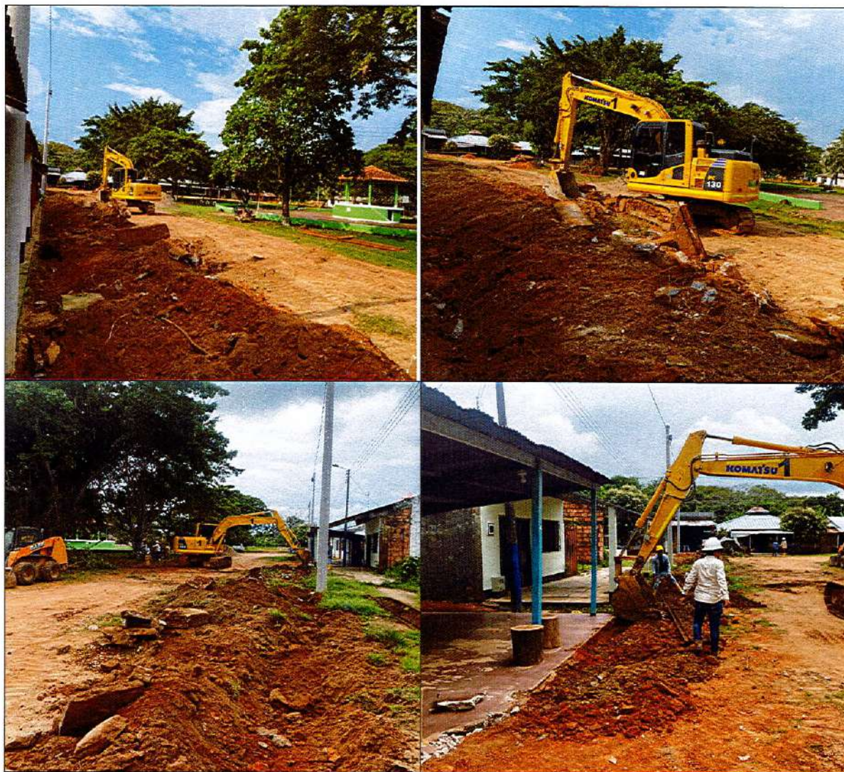
IMAGEN 6. DEMOLICIÓN DE ESTRUCTURAS A NIVEL EN CONCRETO
