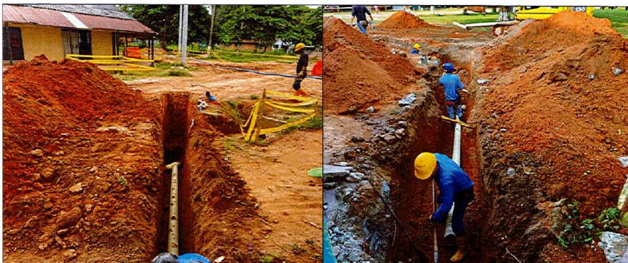
IMAGEN 16. REPARACIÓN DE ACOMETIDA DOMICILIARIA ALCANTARILLADO Ø= 6"
