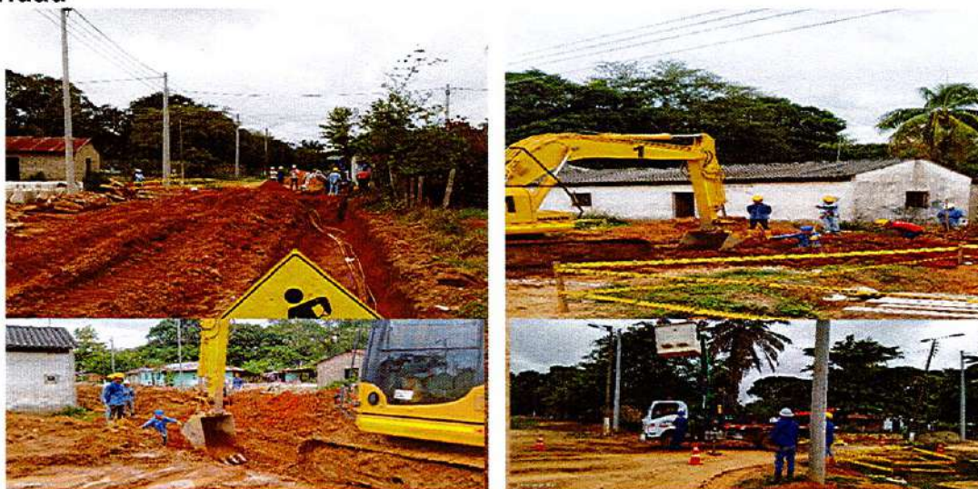
IMAGEN 37. EVIDENCIAS DEL PERSONAL EN OBRA CON SUS RESPECTIVOS EPP.
