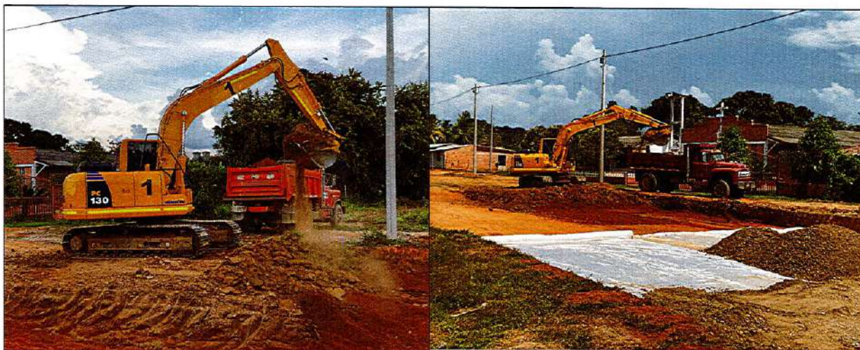
IMAGEN 20. CARGUE Y RETIRO MECÁNICO DE MATERIAL
