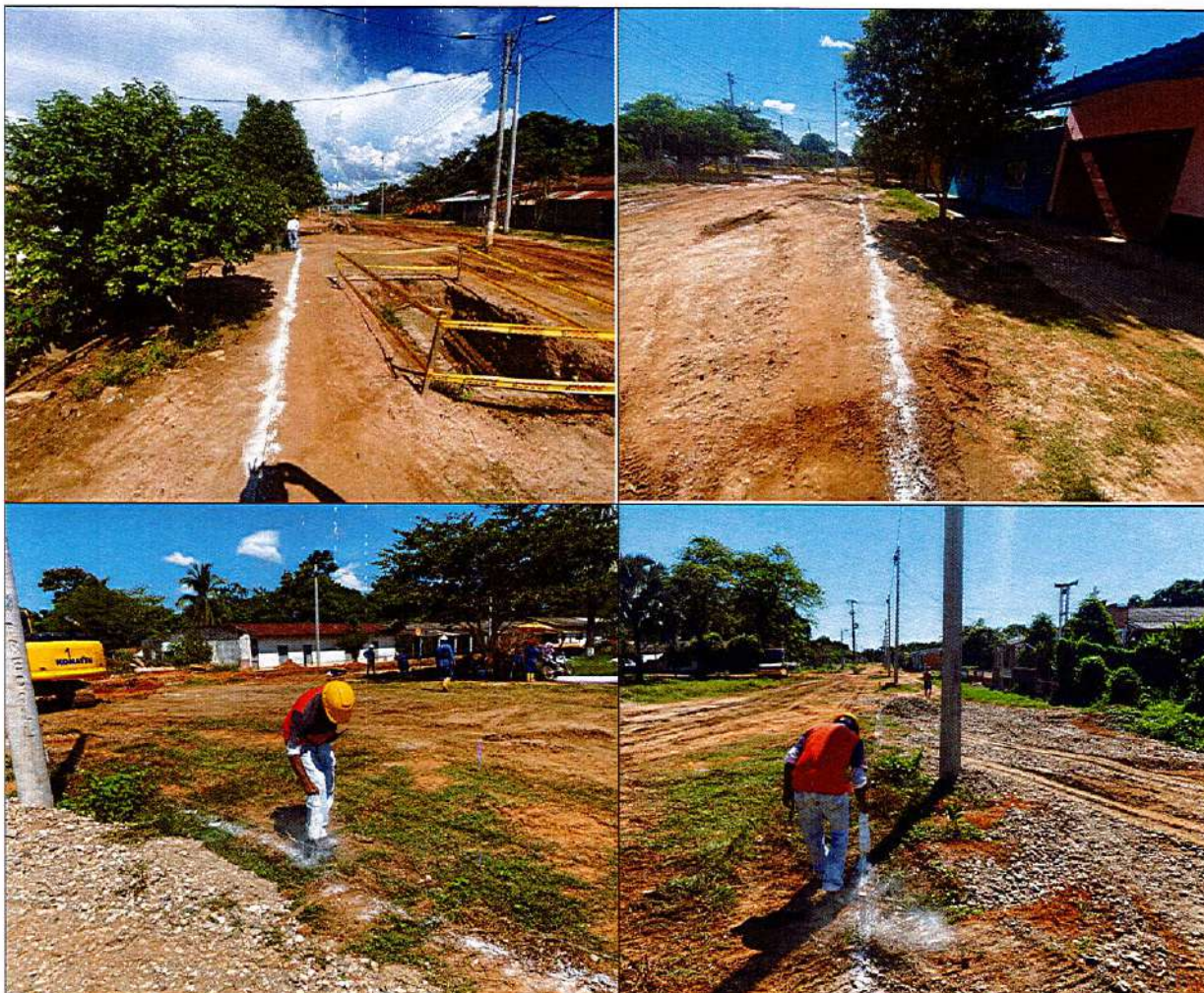
IMAGEN 10. REPLANTEO Y LOCALIZACIÓN DE TUBERÍAS DE ACUEDUCTO
