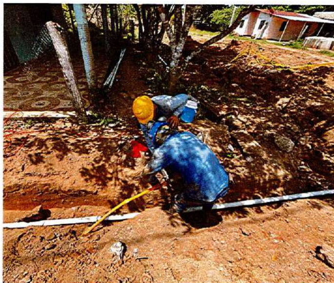
IMAGEN 51. REPARACIÓN DE REDES DE SERVICIOS PÚBLICOS
