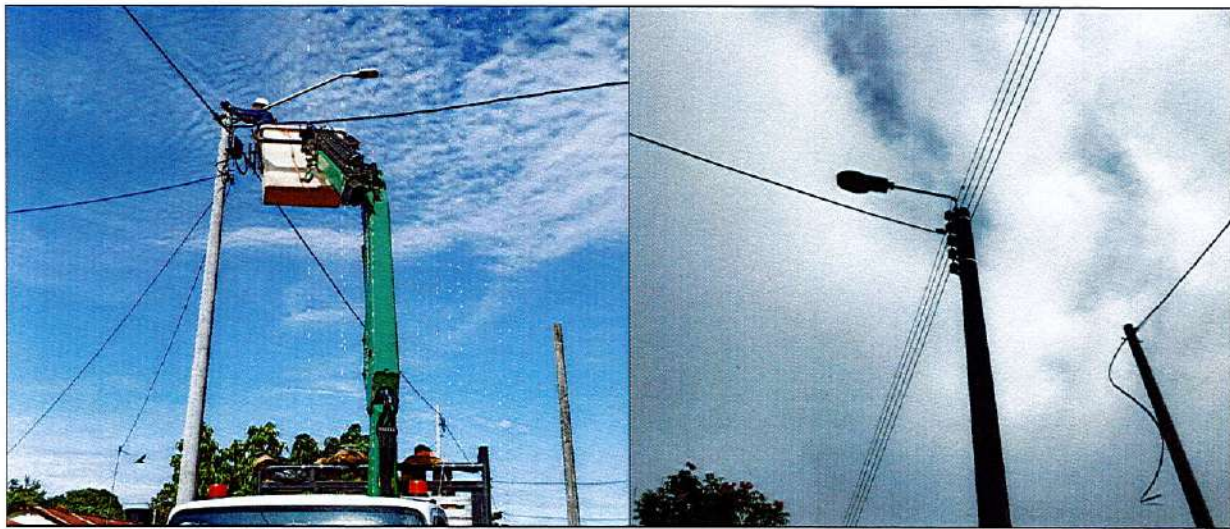
IMAGEN 33. DESMONTE, TRASLADO Y MONTAJE DE LUMINARIA EXISTENTE
