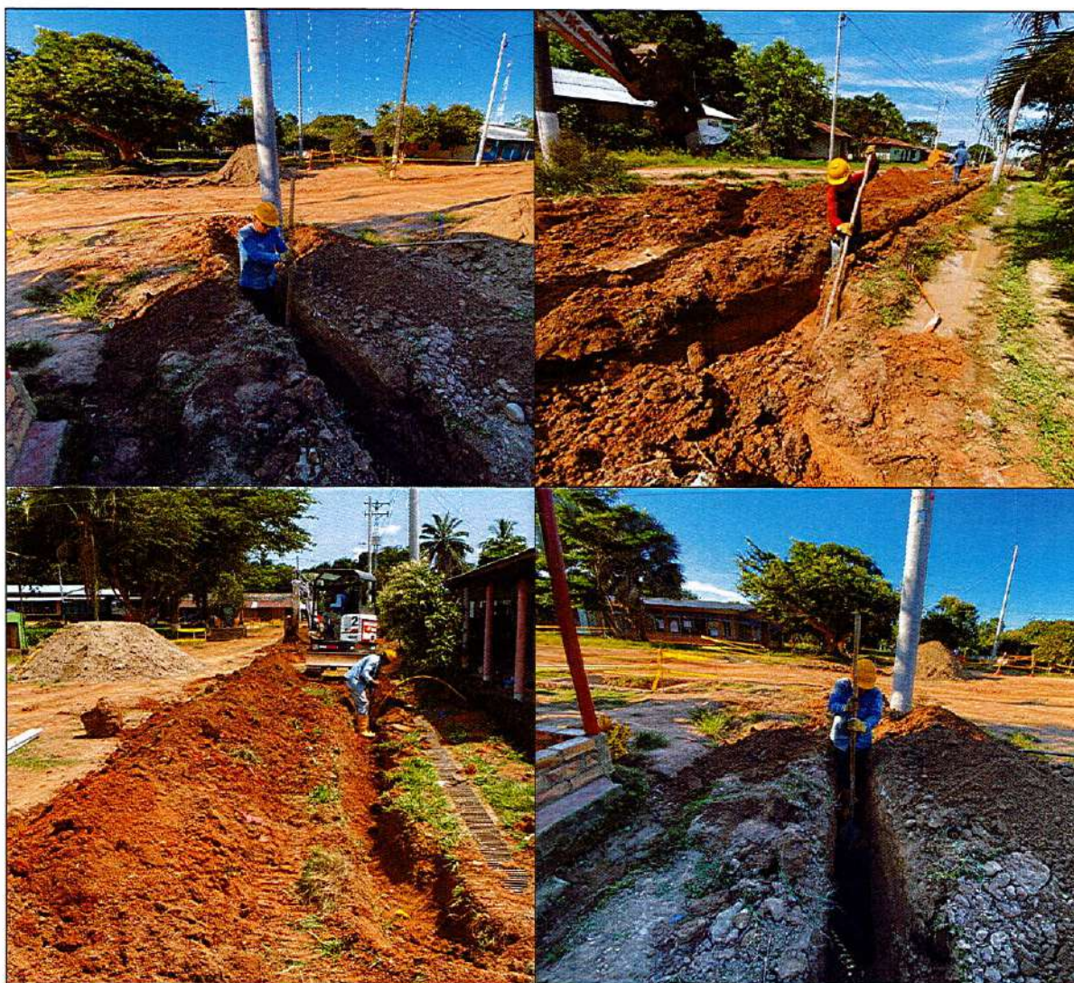
IMAGEN 7. EXCAVACIÓN MANUAL EN MATERIAL COMÚN
