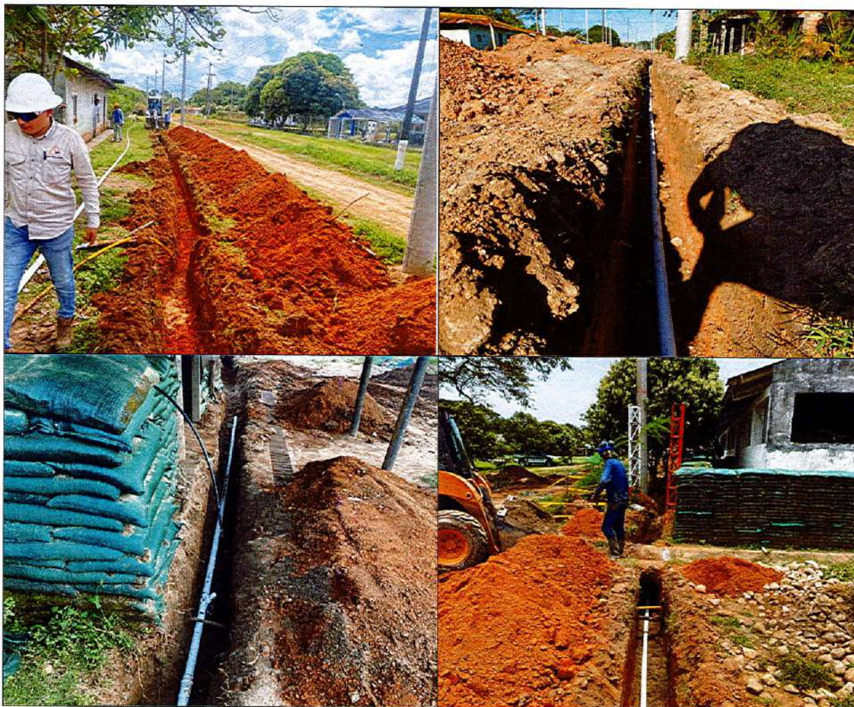
IMAGEN 11. TUBERÍA PRESIÓN PVC RDE 21 2". SUMINISTRO E INSTAL ÍTEM 2.25 Tee de presión PVC 2". Suministro e instal.
