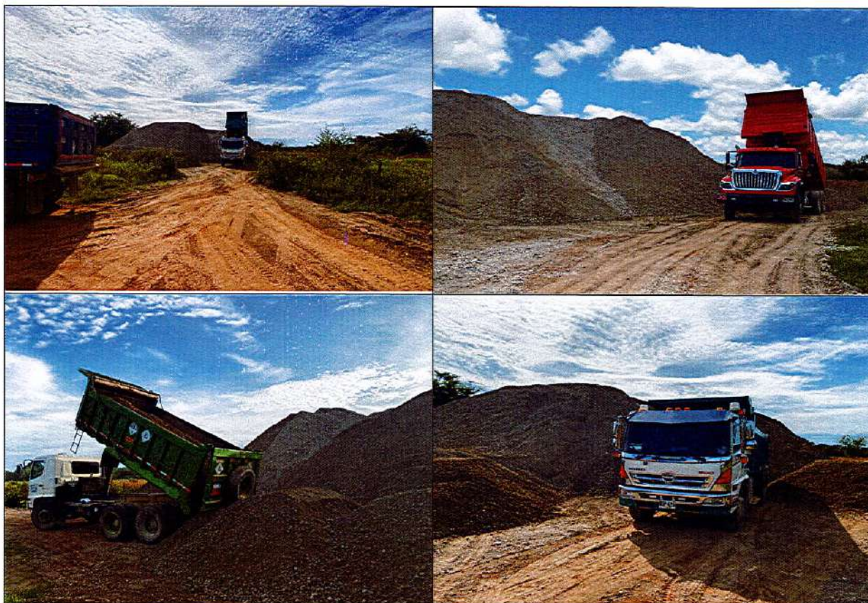
IMAGEN 25. SUB BASE GRANULAR
