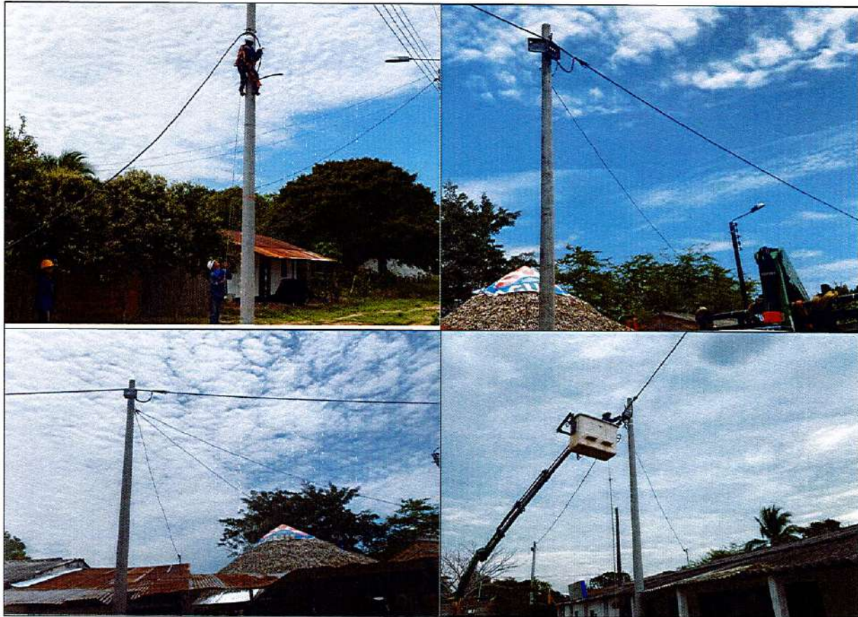
IMAGEN 34. SUMINISTRO E INSTALACIÓN DE ACOMETIDA
