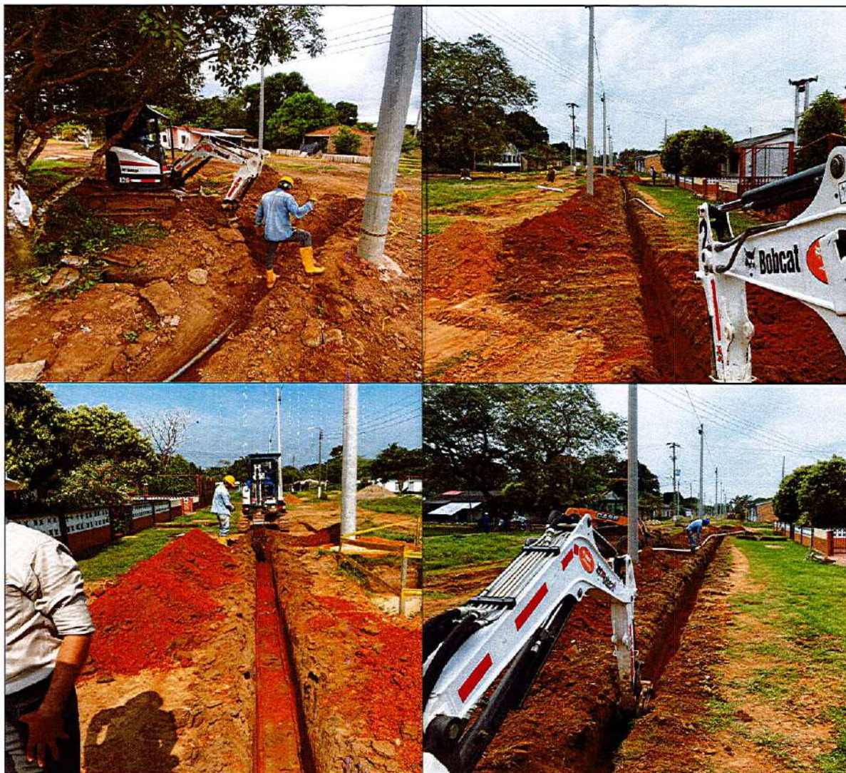
IMAGEN 8. EXCAVACIÓN MECÁNICA EN MATERIAL COMÚN 0 - 2 M (AREA RESTRINGIDA)
