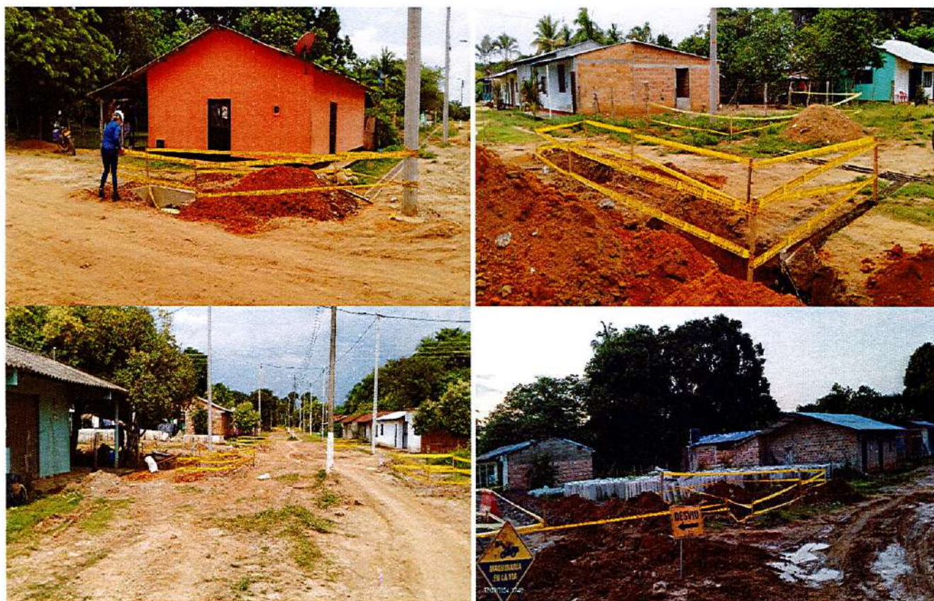
IMAGEN 57. REGISTRO DE SEÑALIZACIÓN
