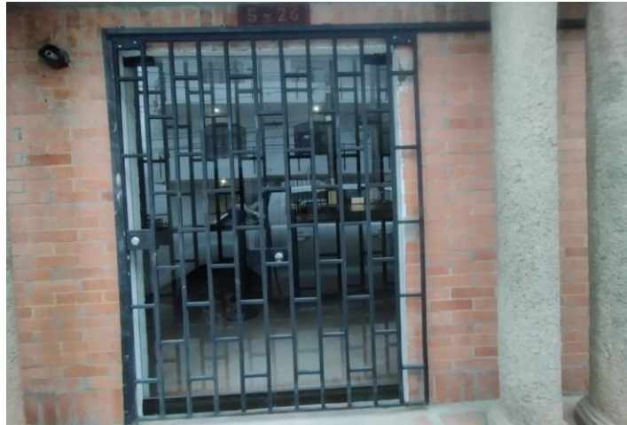
Cambio puerta principal
