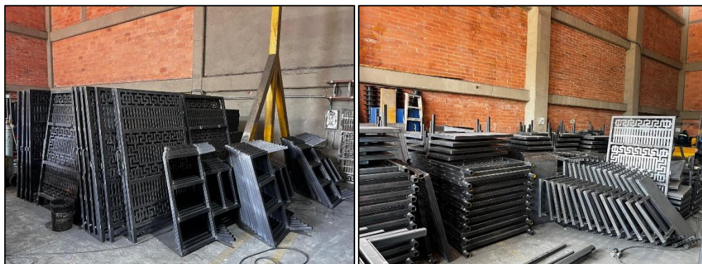
Imagen 11. Terminado de unión de elementos de cerramiento, sin pintar.
