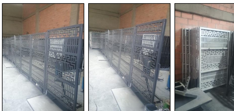
Imagen 13. Aplicación de pintura en poliuretano de módulos CP-1.
