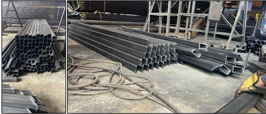
Imagen 5. Etapa de corte de perfiles metálicos de acuerdo con planos de detalle.
