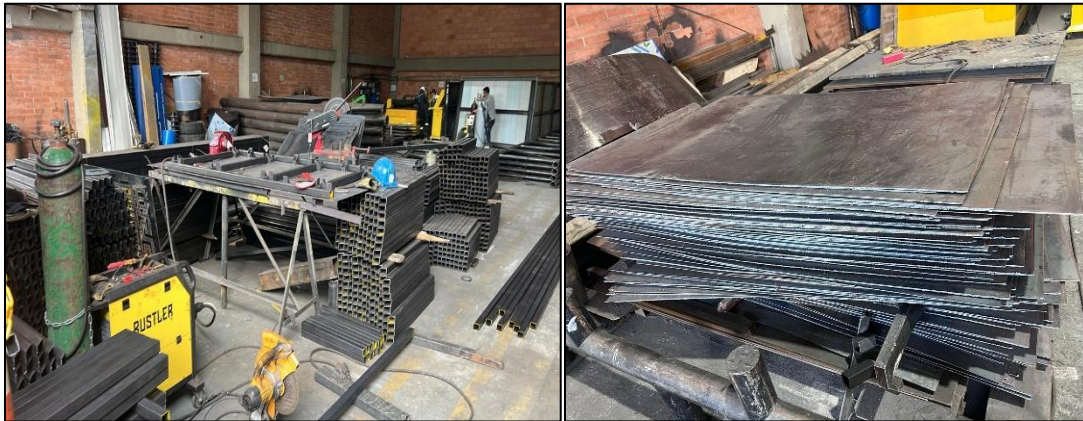
Imagen 6. Corte de perfiles metálicos para marcos y bases de modulo CP-1
