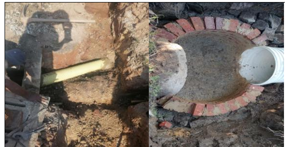
Arbeláez - alcantarillado y acueducto
