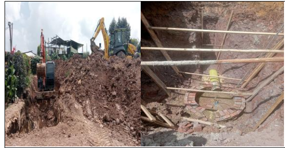
Tabio - alcantarillado Los Pinos
