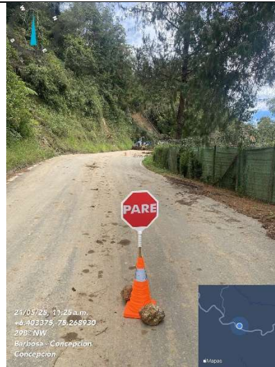
Fotografía 12 Apoyo señalización derrumbe
