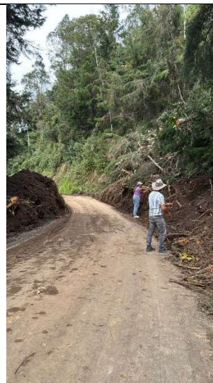
Fotografía 2 Apoyo señalización derrumbe
