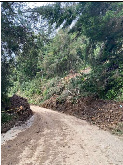
Fotografía 1 Apoyo señalización derrumbe
