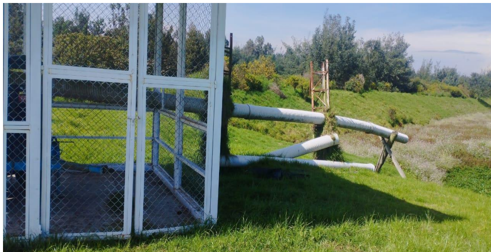
Figura 13. Apoyos de la tubería.
