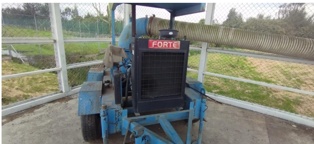
Figura 13. Apertura del punto de bombeo H – M
