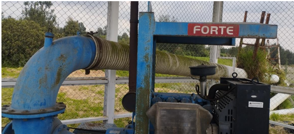
Figura 14. Revisión de la tubería de descarga.
