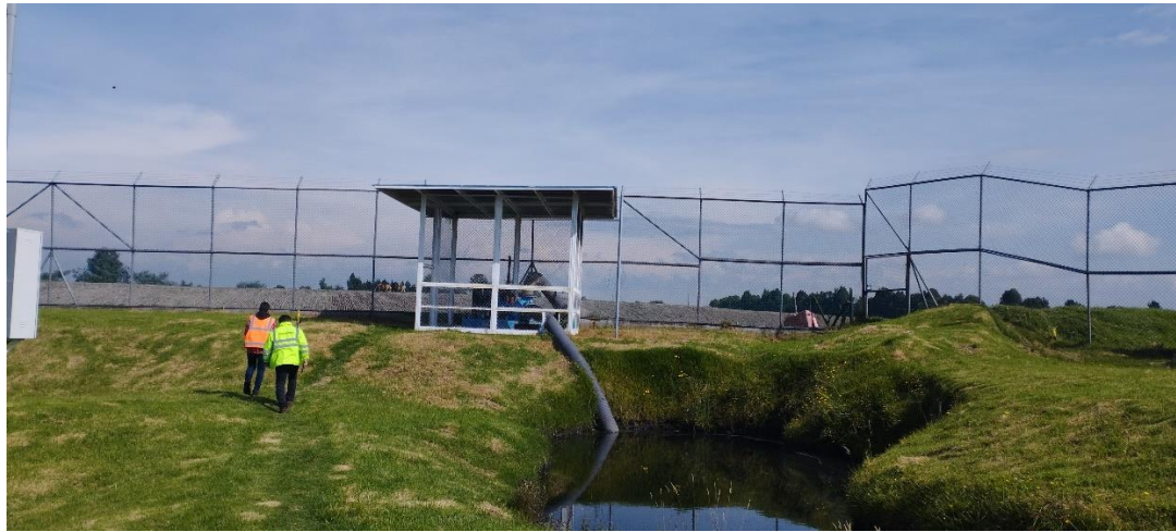
Figura 1. Punto de bombeo.
