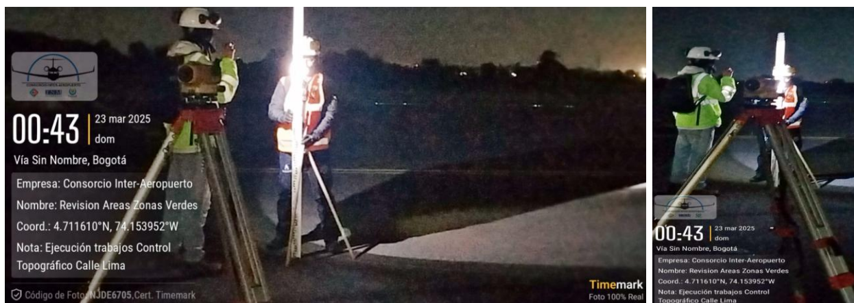
Imagen 1 Registro fotografico nivelacion geometrica calle LIMA
