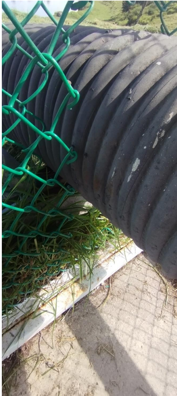
Figura 5. Manguera presenta fisuras por golpes.
