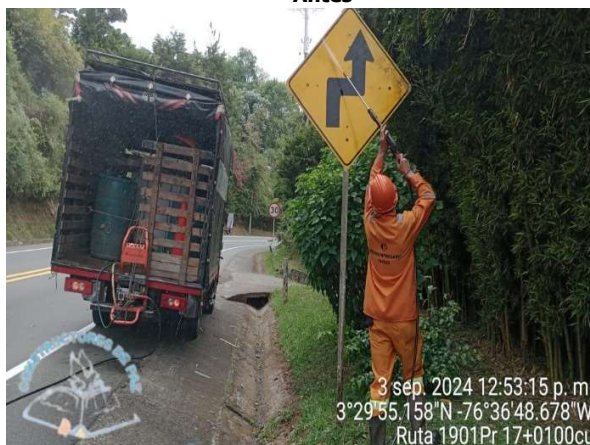
Limpieza señal – PR17+0100
