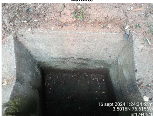
Limpieza alcantarilla - PR17+0540 Después
