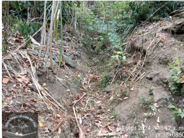
Limpieza descole – PR38+0850 Antes
