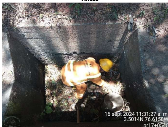
Limpieza alcantarilla - PR17+0540 Durante
