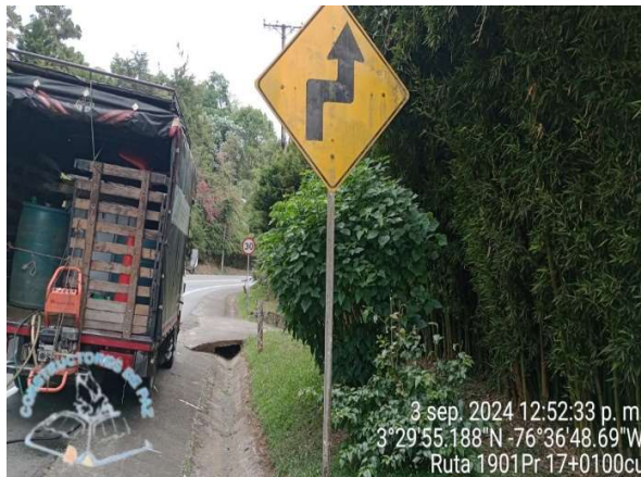
Limpieza señal – PR17+0100
