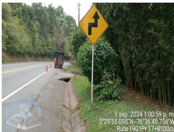
Limpieza señal – PR17+0100
