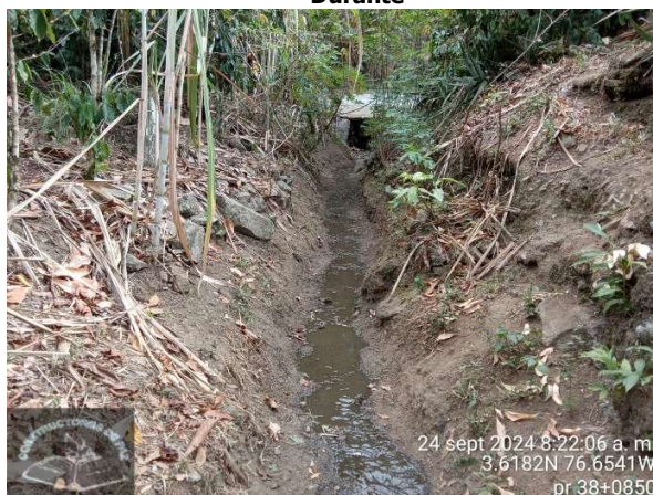
Limpieza descole – PR38+0850 Después
