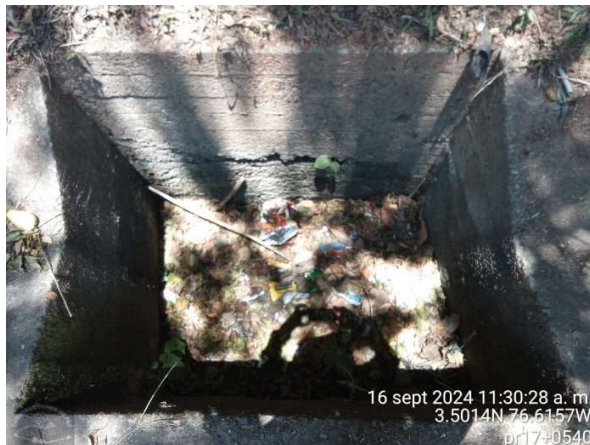
Limpieza alcantarilla - PR17+0540 Antes
