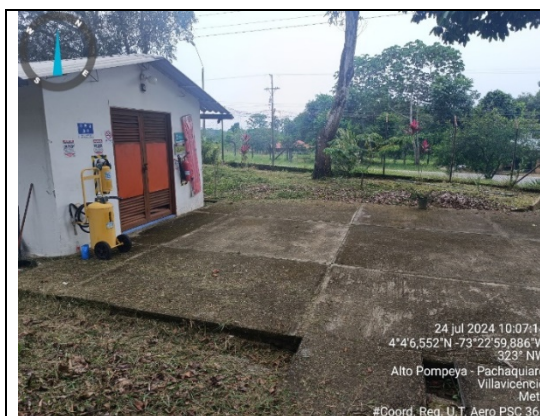
Vista noroeste instalaciones planta VOR de Pompeya – Meta.
