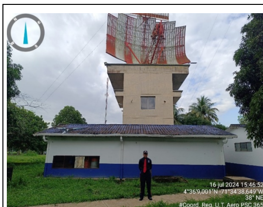
Vista noroeste radar carimagua, servicio de seguridad instalado
