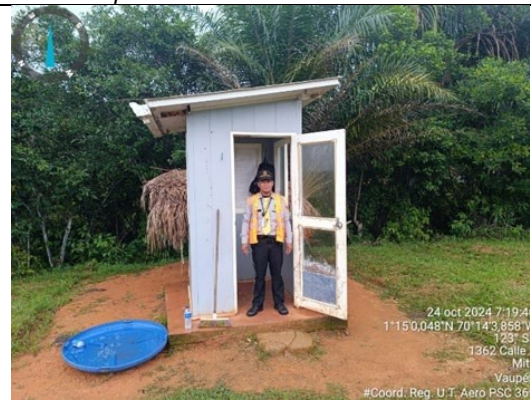
Caseta de vigilancia Alfa 4 vista sur.
