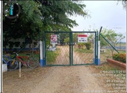
Imagen 6. Vista noreste portón acceso hacia inmueble oficina de gerencia PZA.
