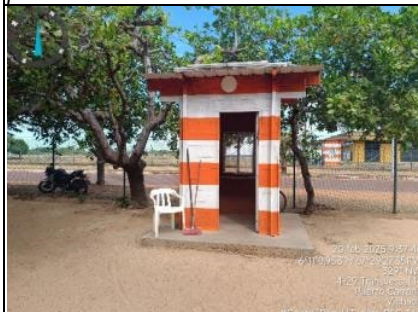
Imagen 16. Vista noroeste caseta de vigilancia del puesto # 4 o casa de planta.
