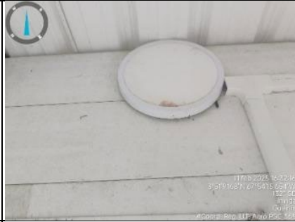
Imagen 14. Vista de la lampara y techo parte frontal de la caseta.
