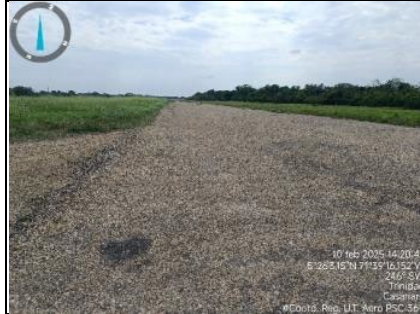
Imagen 4. Vista suroeste pista de aterrizaje aeropuerto Trinidad.
