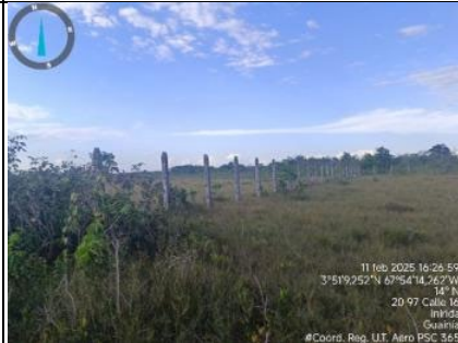
Imagen 8. Imagen de cerramiento únicamente con los postes en pie.
