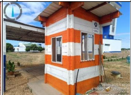
Imagen 18. Vista oeste caseta de vigilancia puesto # 8.
