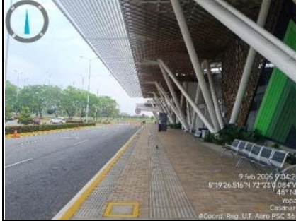
Imagen 4. Vista noreste parte frontal terminal aéreo aeropuerto Yopal.
