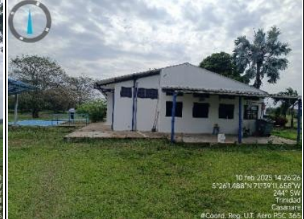
Imagen 3. Vista suroeste instalaciones aeropuerto Trinidad.
