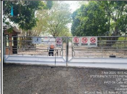
Imagen 8. Vista suroeste portón acceso vehicular puesto # 2.
