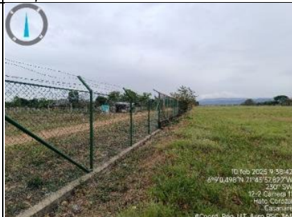
Imagen 18. Vista suroeste cerramiento costado derecho aeropuerto HTZ.
