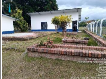
Imagen 2. Vista norte inmueble 1. aeropuerto Tablón de Tamara.
