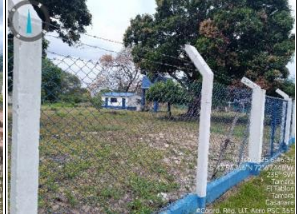
Imagen 3. Vista suroeste cerramiento con malla eslabonada.
