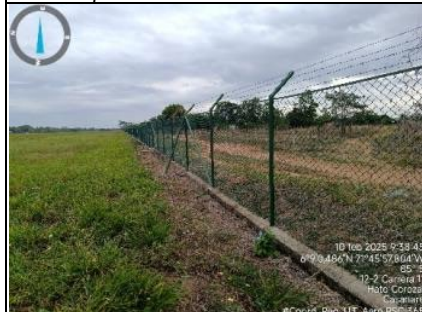
Imagen 19. Vista noreste cerramiento costado derecho aeropuerto HTZ.
