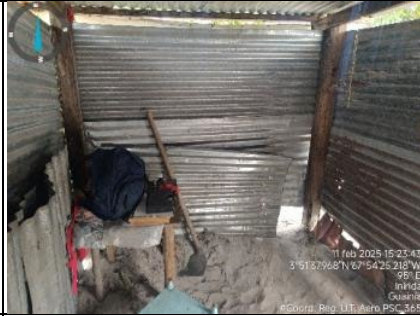
Imagen 2. Vista Este, interior caseta de vigilancia.
