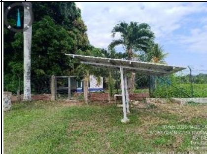
Imagen 11. Vista de paneles solares de la
