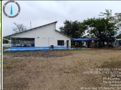
Imagen 5. Vista suroeste inmueble terminal aérea sala de espera.
