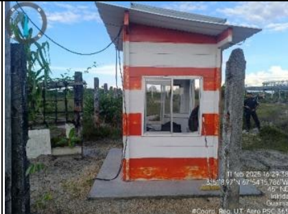
Imagen 11. Vista Noreste, caseta de vigilancia.
