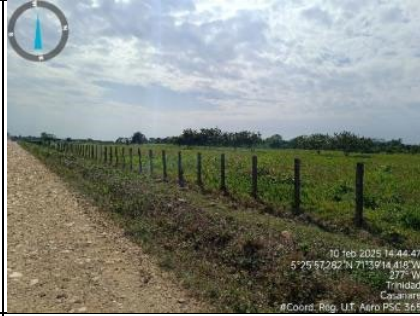
Imagen 17. Vista oeste cerramiento en postes de cemento y alambre trenzado.
