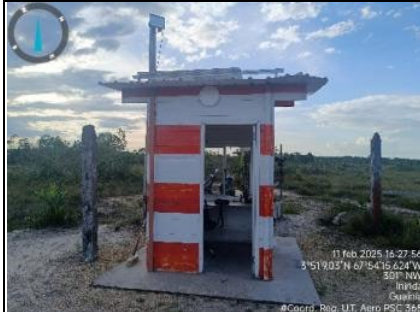
Imagen 10. Vista Noroeste, caseta de vigilancia.
