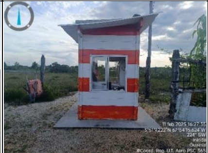
Imagen 9. Vista Suroeste, caseta de vigilancia.
