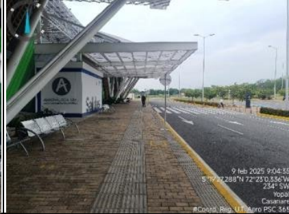
Imagen 5. Vista suroeste parte frontal terminal aéreo aeropuerto Yopal.
