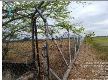
Imagen 21. Vista noreste cerramiento costado derecho aeropuerto HTZ.
