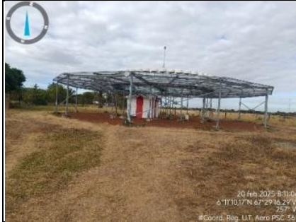
Imagen 7. Vista oeste VOR Puerto Carreño.
