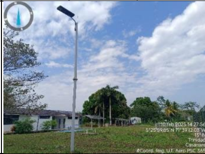
Imagen 14. Vista norte instalaciones y reflector de ese sector.
