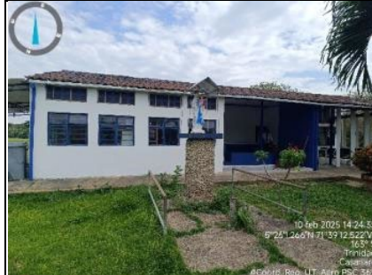
Imagen 7. Vista sureste instalaciones aeropuerto Trinidad.
