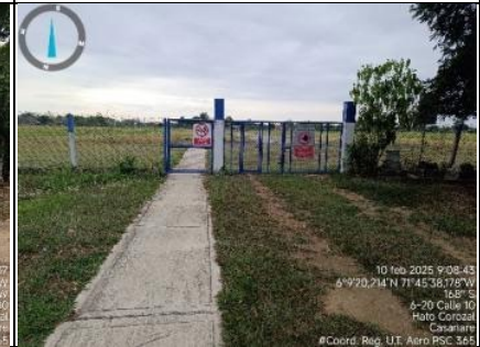
Imagen 6. Vista sur portón acceso peatonal y vehicular a plataforma y pista.
