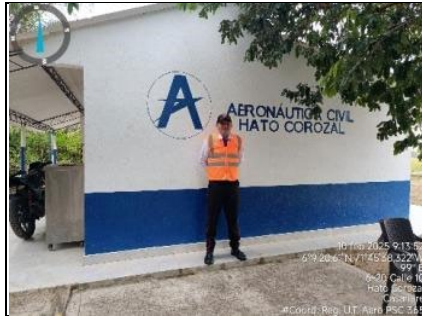
Imagen 1. Vista este instalaciones y unidad de seguridad.
