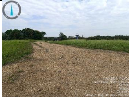
Imagen 5. Vista sureste de calle rodaje desde pista hacia plataforma.
