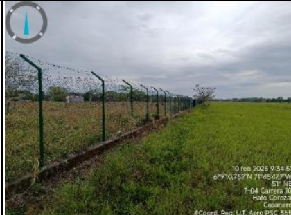
Imagen 14. Vista noreste cerramiento costado derecho aeropuerto HTZ.
