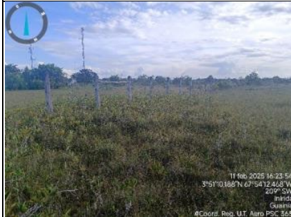
Imagen 7. Imagen de cerramiento únicamente con los postes en pie.
