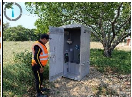
Imagen 6. Vista del baño portátil al servicio del personal de seguridad.
