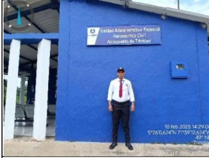
Imagen 16. Vista instalaciones y unidad de seguridad en servicio.
