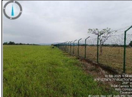
Imagen 13. Vista sureste cerramiento costado derecho aeropuerto HTZ.
