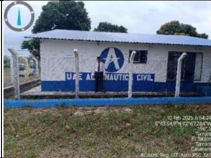
Imagen 5. Vista sur inmueble 1. y unidad de seguridad.
