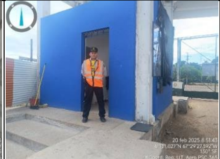
Imagen 12. Vista sureste unidad de seguridad puesto # 1 entrada vehicular.
