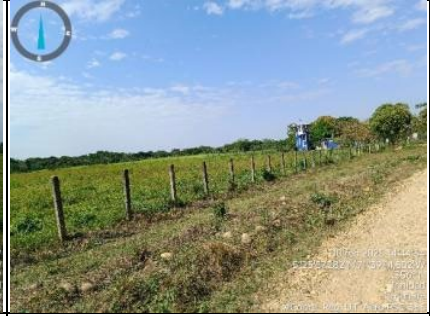
Imagen 18. Vista norte cerramiento en postes de cemento y alambre trenzado.
