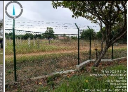
Imagen 9. Vista sur cerramiento reparado en punto donde ingresaba la comunidad.
