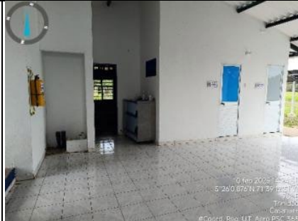
Imagen 8. Vista este batería de baños aeropuerto Trinidad.
