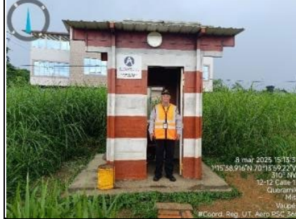
Imagen 7. Vista unidad de seguridad y caseta vigilancia cabecera 2-0.
