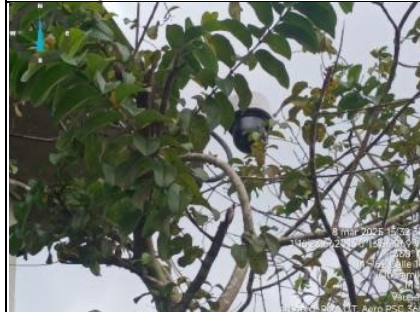
Imagen 10. Vista domo 360° de bomberos que tiene obstrucción por ramas de árbol.
