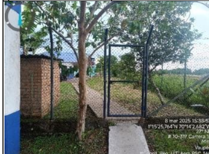
Imagen 13. Vista noreste portón acceso desde gimnasio a bomberos.
