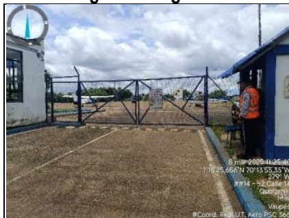
Imagen 1. Vista oeste portón ingreso vehicular a plataforma puesto # 1.
