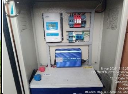
Imagen 8. Gabinete y equipos solución solar caseta vigilancia cabecera 2-0.
