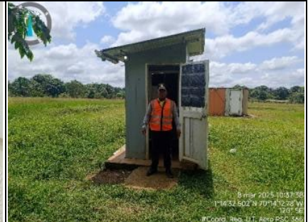
Imagen 27. Vista sureste caseta y unidad de seguridad puesto VOR/DME Mitú.
