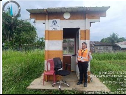
Imagen 17. Vista caseta y unidad de seguridad cabecera 0-2.
