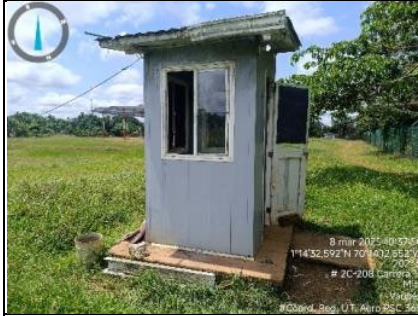
Imagen 28. Vista suroeste caseta de vigilancia puesto VOR/DME Mitú.
