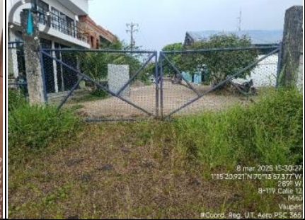
Imagen 9. Vista oeste portón salida de emergencia cerca de bomberos.
