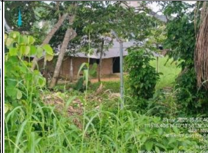
Imagen 14. Vista noroeste tramo de cerramiento sin malla eslabonada.
