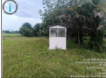
Imagen 19. Vista norte caseta vigilancia cabecera 0-2 en desuso.
