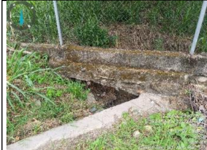
Imagen 7. Vista cerramiento perimetral sur oriente calle 40. fácil acceso por la pileta de desagüe.
