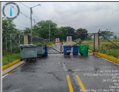
Imagen 2. Vista de portón noreste punto de acceso vehicular
