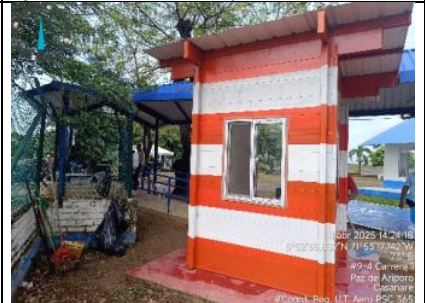
Imagen 9. Vista este de la caseta de vigilancia de Paz de Ariporo.
