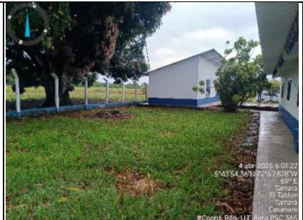
Imagen 3. Vista suroeste cerramiento con malla eslabonada.
