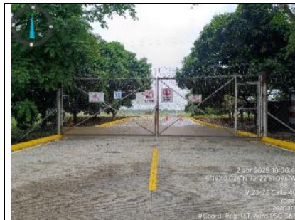
Imagen 1. Vista portón sureste punto acceso vehicular puesto # 10.
