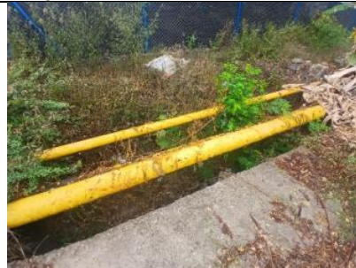
Imagen 47. Verificación canal desagüe
