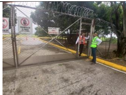
Imagen 50. Vista recorrida verificación punto acceso vehicular
