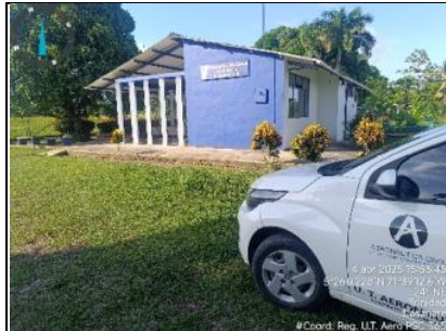
Imagen 1. Vista noreste, instalaciones.
