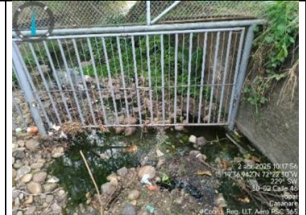
Imagen 9. Vista pileta de desagüe cerramiento perimetral sur occidente calle 48, fácil acceso parte inferior.
