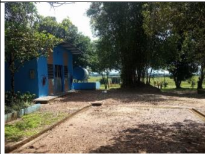
Imagen 4. Vista casa de planta y VOR – San José del Guaviare.
