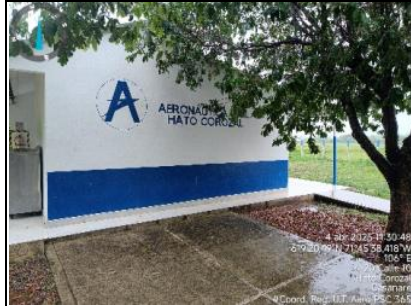
Imagen 1. Vista este, instalaciones.
