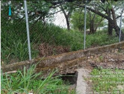
Imagen 8. Vista cerramiento perimetral sur oriente calle 40. fácil acceso por la pileta de desagüe.
