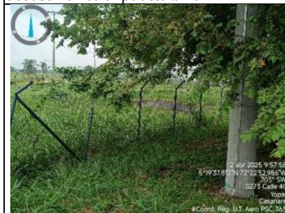
Imagen 4. Vista malla sur occidente calle 40 concertina de seguridad en regular estado por arborización.
