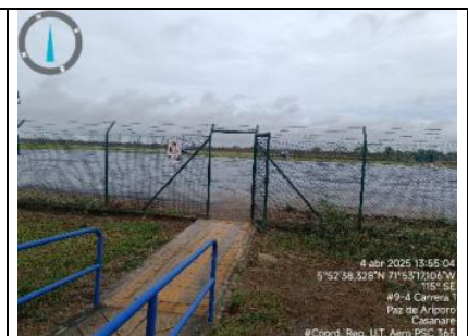
Imagen 3. Vista sendero y portón peatonal a plataforma.
