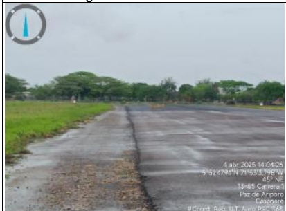
Imagen 13. Vista presencia de venados en la pista.
