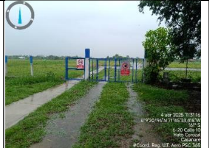
Imagen 6. Vista sur portón acceso peatonal y vehicular a plataforma y pista.
