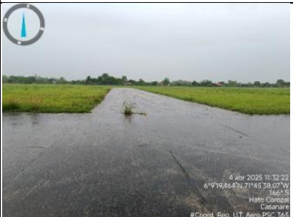
Imagen 7. Vista sur calle de rodaje desde plataforma a pista.
