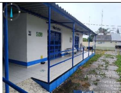
Imagen 2. Vista instalaciones oficinas Helistar aeropuerto PZA.
