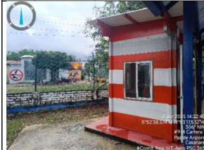
Imagen 7. Vista norte de la caseta de vigilancia de Paz de Ariporo.
