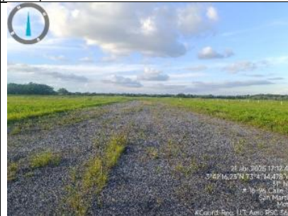
Imagen 5. Vista noroeste, pista aeropuerto San Martín.
