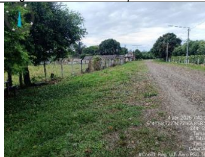
Imagen 14. Vista suroeste "cost. izq." cerramiento del aeropuerto.
