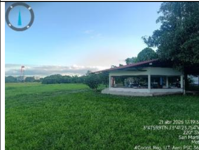
Imagen 8. Vista suroeste kiosko sala de espera aeropuerto San Martín.
