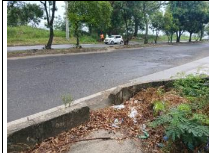
Imagen 43. Vista recorrida verificación perimetral
