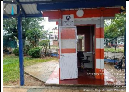
Imagen 6. Vista oeste de la caseta de vigilancia de Paz de Ariporo.
