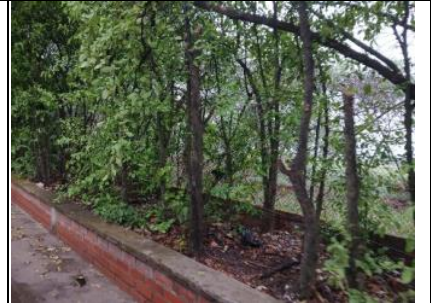
Imagen 12. Vista cerramiento perimetral
