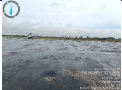
Imagen 5. Vista suroeste plataforma del aeropuerto.
