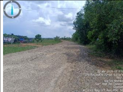
Imagen 2. Vista sur vía acceso VOR San José del Guaviare
