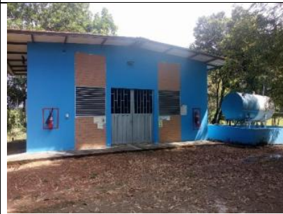
Imagen 5. Vista casa de planta VOR – San José del Guaviare.
