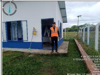
Imagen 5. Vista sur inmueble 1. y unidad de seguridad.
