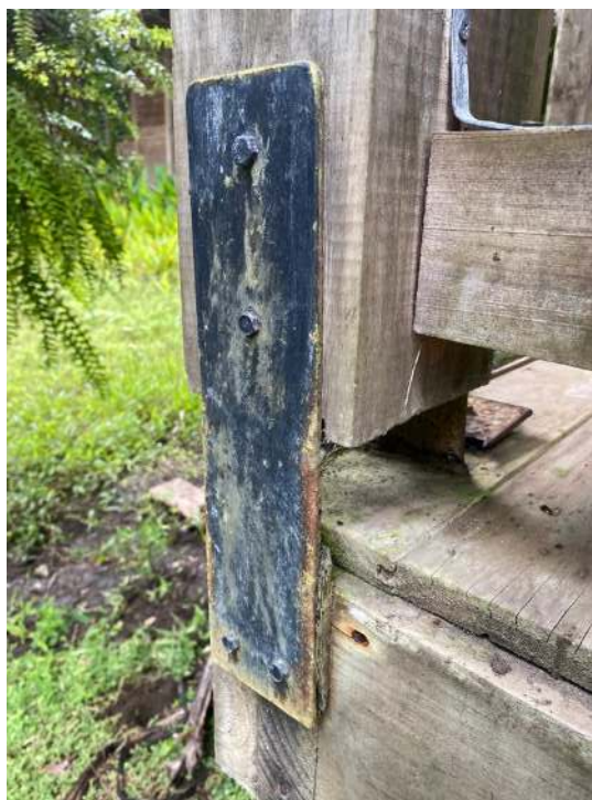
Imagen 8. Estado actual de platinas de conexión de barandas con estructura de Restaurante. Fuente: Propia Fundación EDICOL
