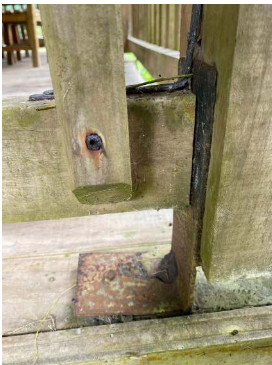
Imagen 8. Estado actual de platinas de conexión de barandas con estructura de Restaurante. Fuente: Propia Fundación EDICOL
