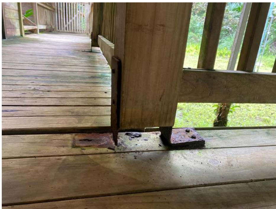
Imagen 7. Estado actual de platinas de conexión de barandas con estructura de Restaurante. Fuente: Propia Fundación EDICOL
