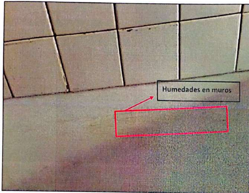
Muros interiores Primer piso
