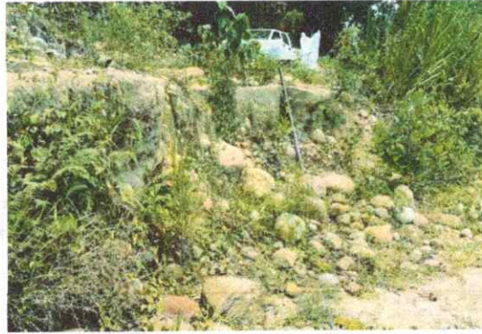
Talud expuesto por erosión en locación M-1
