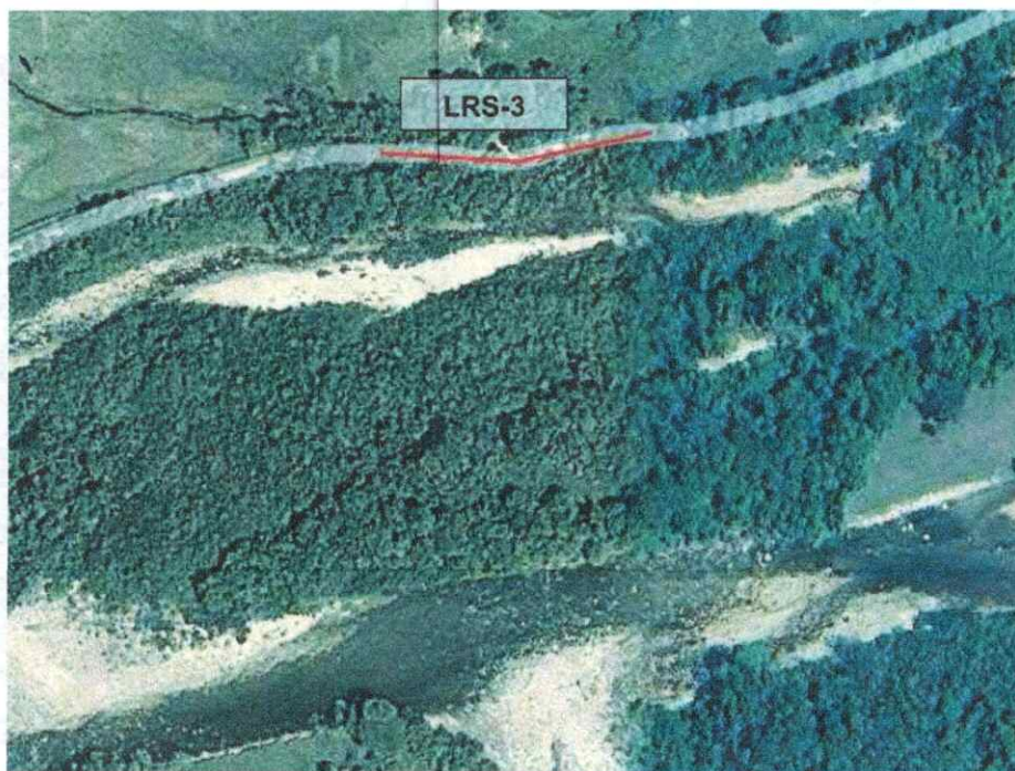
Figura 3. Zona de ejecución línea LRS-3 para evaluación de muro contra erosión (Imagen de Google Earth editada para localizaciones)
