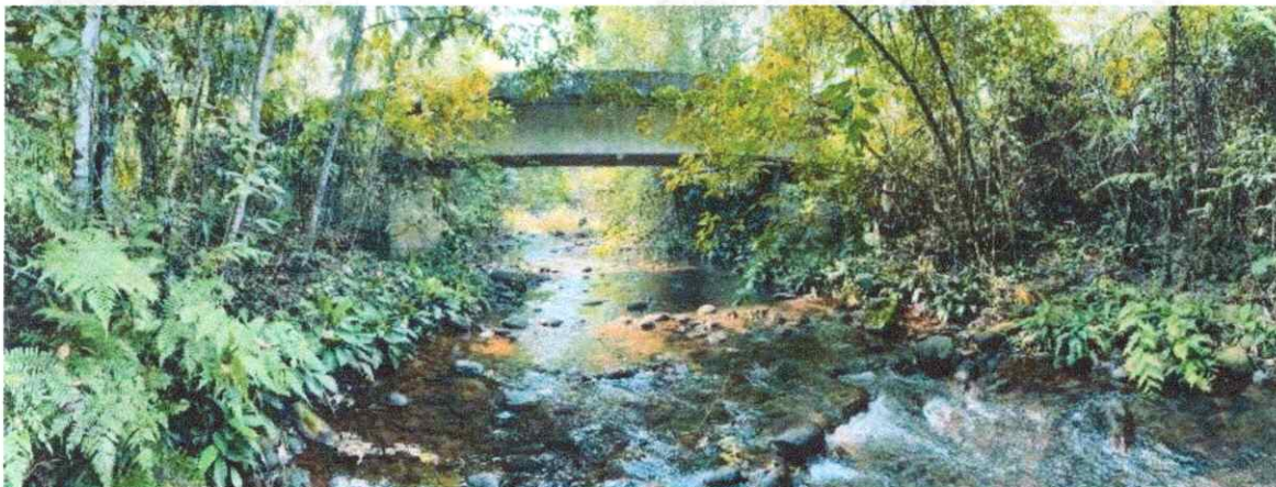
Fotografía 3. Estado actual del puente
