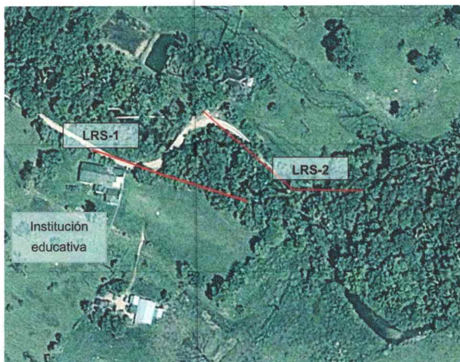
Figura 2. Zona de ejecución líneas LRS-1 y LRS-2 para los estribos del puente (Imagen de Google Earth editada para localizaciones)
