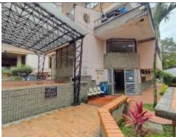
VISTA INTERNA CORREDORES
