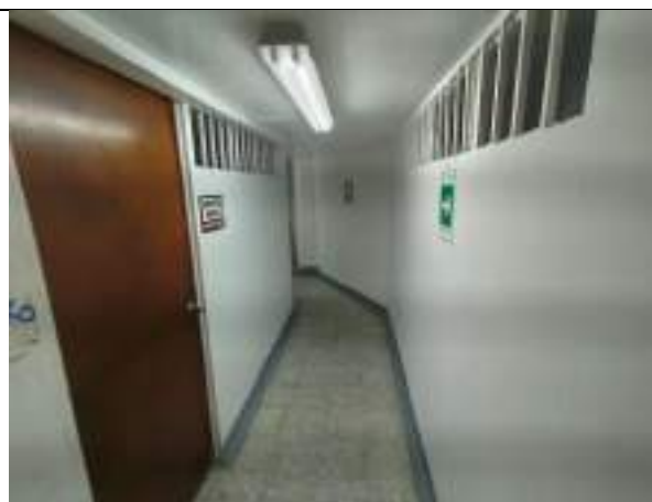
VISTA GENERAL INTERNA FACULTAD
