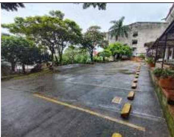
VISTA PLACA PARQUEADERO
