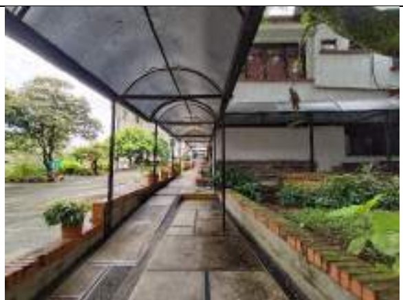
VISTA INTERNA CORREDORES
