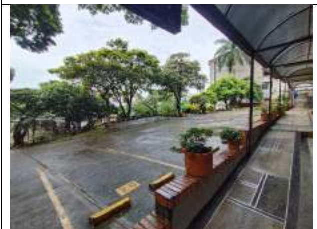
VISTA PLACA PARQUEADERO
