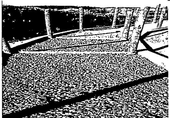
FECHA, LUGAR Y DESCRIPCIÓN: 19 de julio de 2024, sendero Perolindez, suministro e instalación de triturado.
