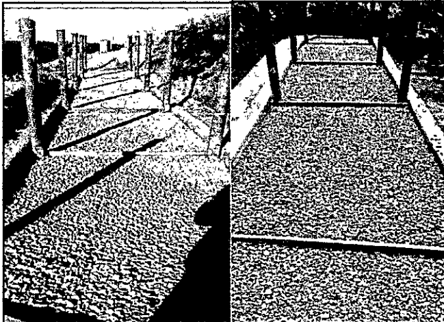
FECHA, LUGAR Y DESCRIPCIÓN: 22 de julio de 2024, sendero Perolindez, suministro e instalación de triturado.
